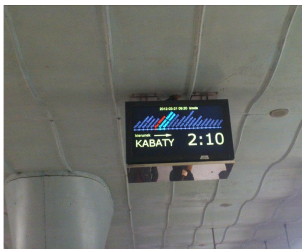
Fot. 9.4. Przykład tablicy informacyjnej na stacji metra Źródło ZTM
