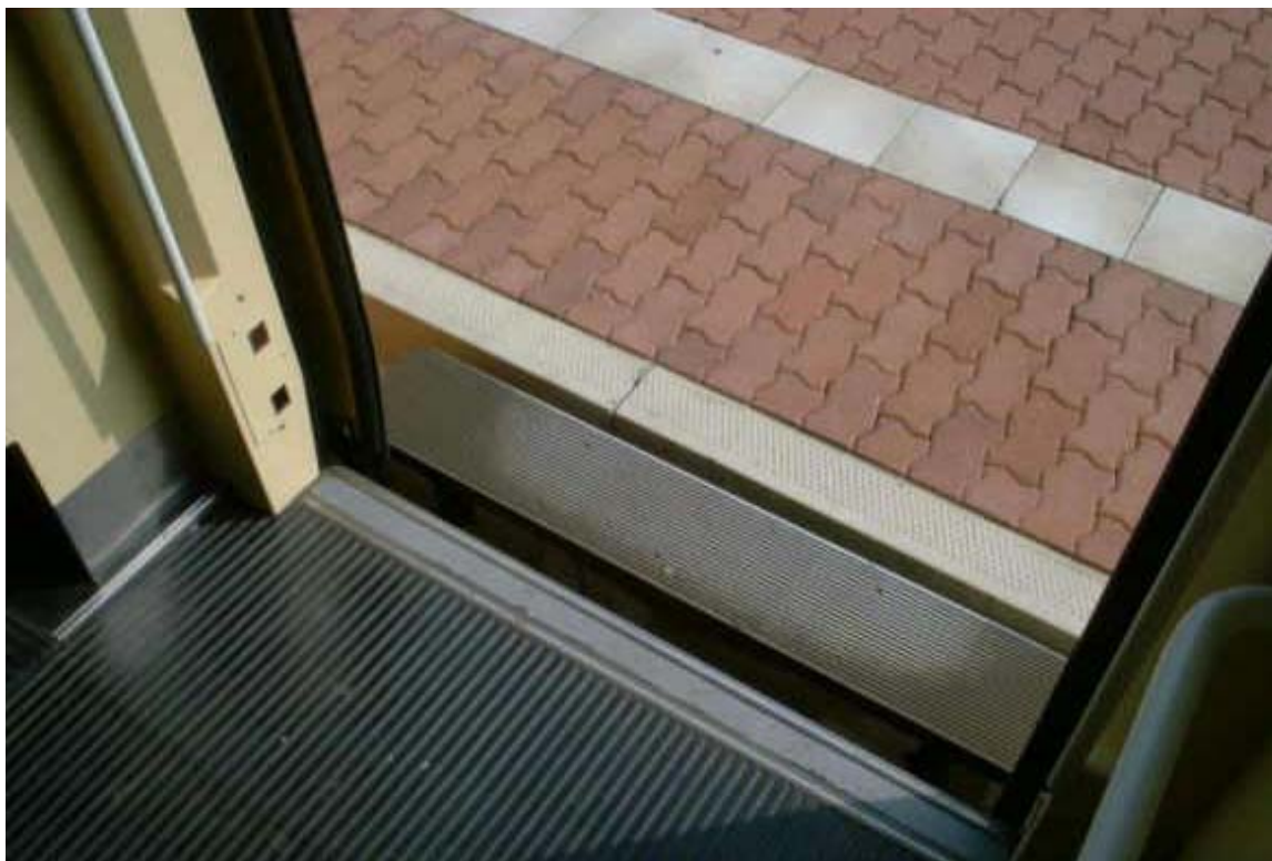
Fot. 1.2 Idealne położenie podłogi wagonu względem nawierzchni peronu
