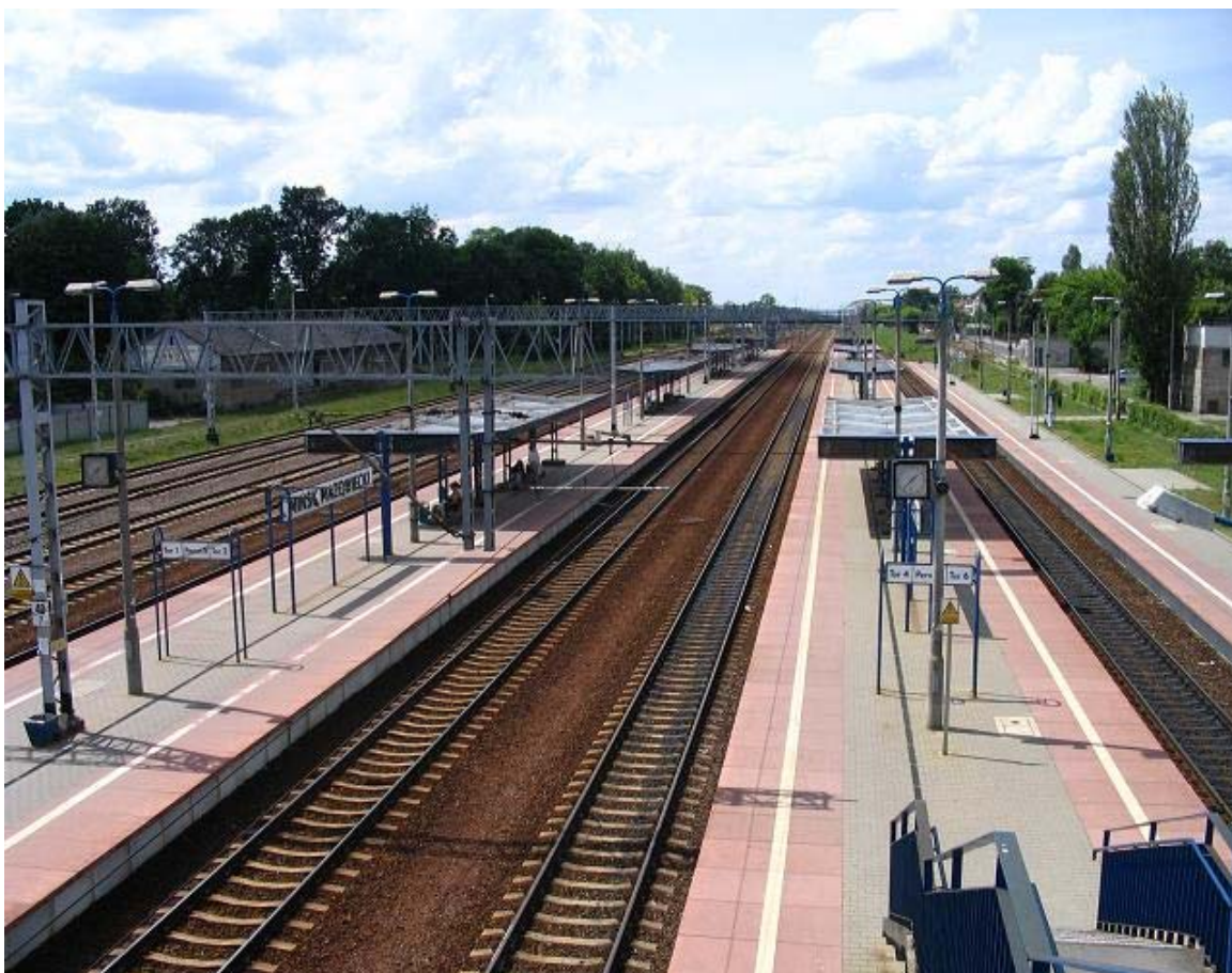
Fot. 1.1 Zmodernizowane perony w Mińsku Mazowieckim
