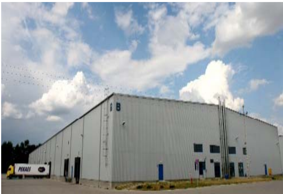
Fot. 4.10 Przykład zespołu magazynów „Metropol Park Błonie”
