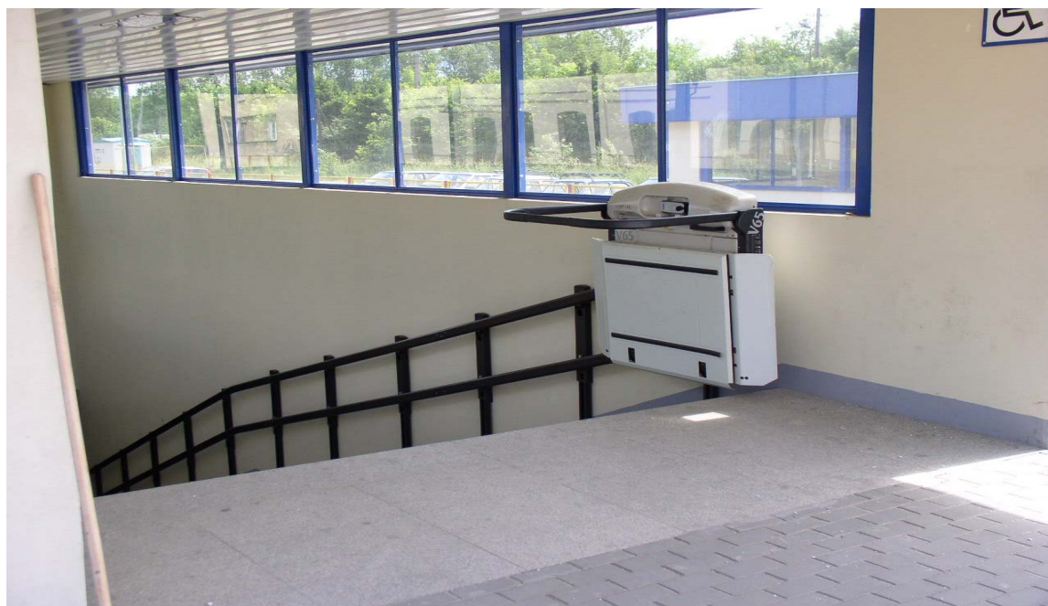
Fot. 1.3 Przyścienny ukośny podnośnik platformowy dla osób niepełnosprawnych
