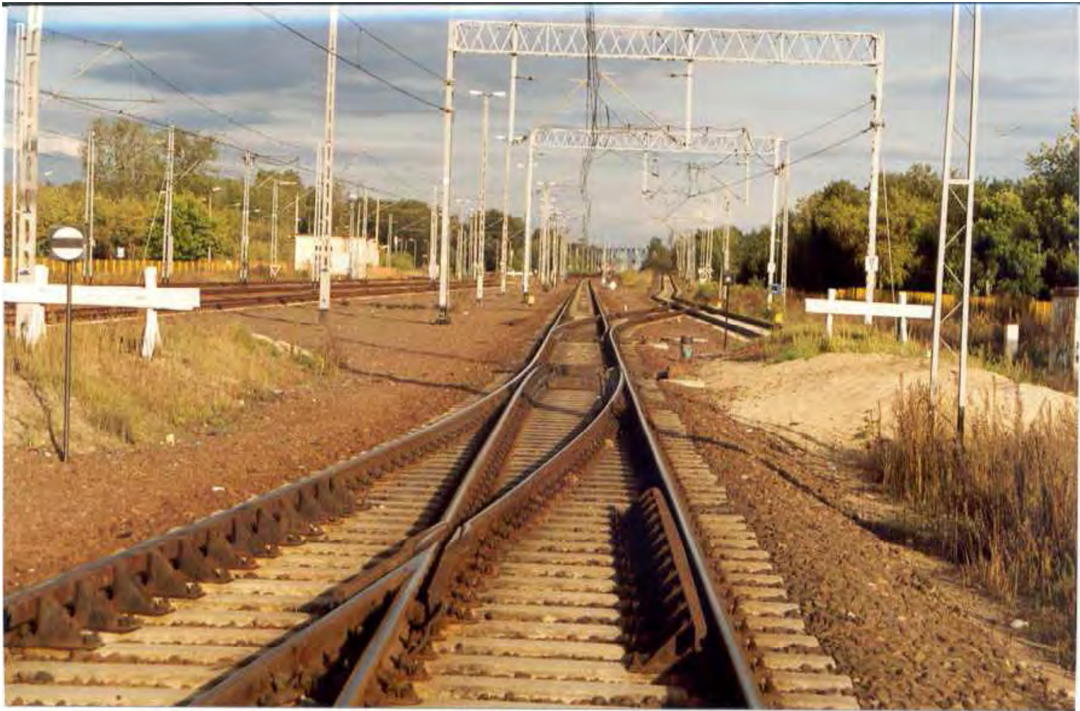
Rysunek 5.2 Widok wschodniej głowicy stacji Warszawa Rembertów
