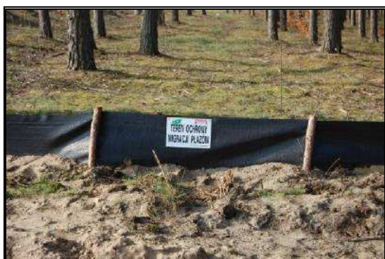
Fot. 5.4 Przykład wygradzenia placu budowy autostrady A2
