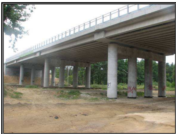
Rys. 3.2 Wiadukt drogi krajowej nr 50 nad linią kolejową
