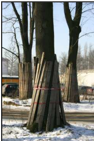
Fot. 5.3 Przykładowy sposób ochrony pnia drzewa przed uszkodzeniami związanymi z pracami wykonywanymi w jego pobliżu
