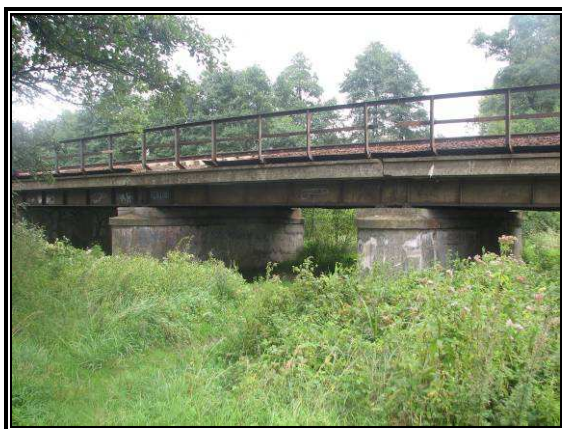
Rys. 3.6 Most nad rzeką Suchą Nidą w km 49+631
