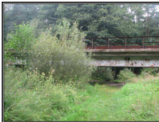
Rys. 3.5 Most na Dopływie Olszówki w km 47+805
