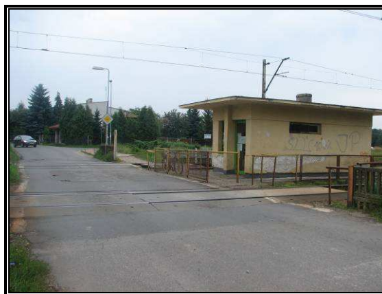
Rys. 3.3 Przejazd drogowy w 50+038
