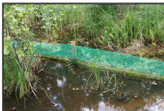
Fot. 5.5 Wygradzenia przed migrującymi płazami na placu budowy drogi ekspresowej S3
