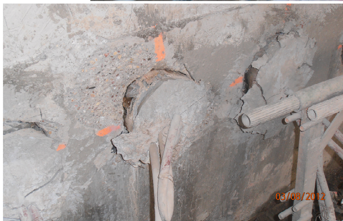
Rys. 7 Wypchnięte przewierły ściany szczelinowej z rurami osłaniającymi wyrobisko za ścianą szczelinową; był to proces postępujący, uwidoczniły na fotografiach z 3.08 i 13.08
