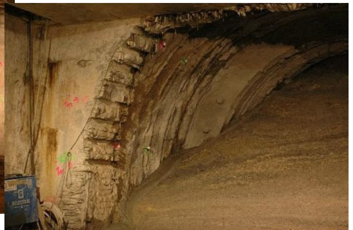
Rys. 9 Początkowa faza wypływu gruntu po przebiciu stopu wyrobiska; po lewej stronie spływająca woda
