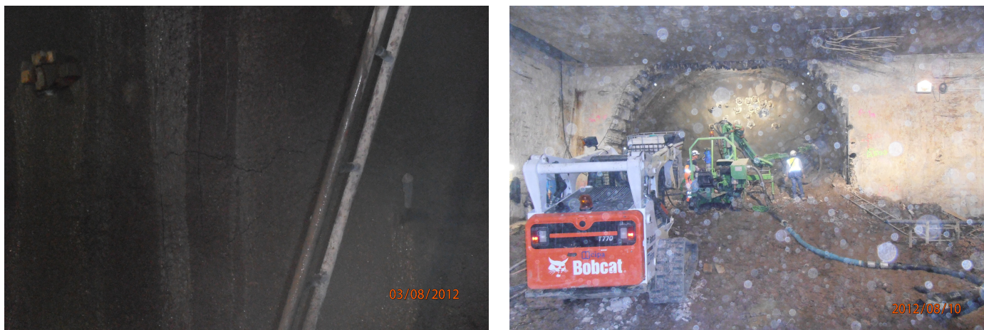
Rys. 6 Pęknięcie ściany zamykającej przodek (3.08); kolejna naprawa uszkodzonego przodka (10.08)
