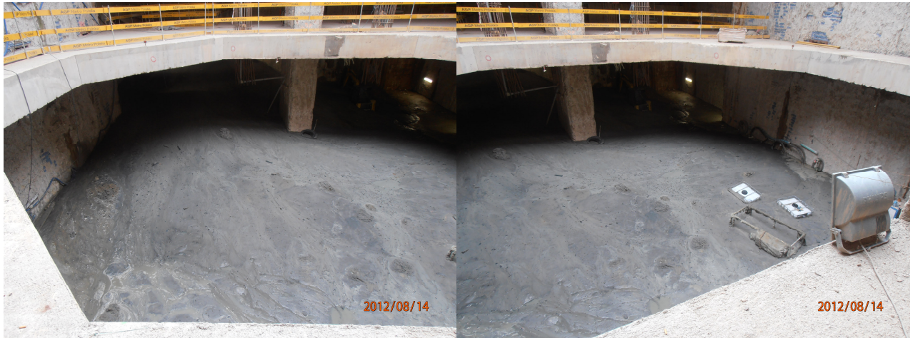
Rys. 10 Postępujący napływ gruntu, zapelniający komorę peronową
