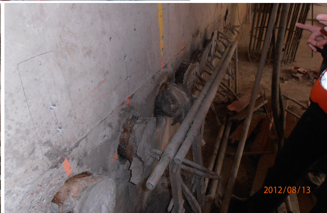
Rys. 7 Wypchnięte przewierły ściany szczelinowej z rurami osłaniającymi wyrobisko za ścianą szczelinową; był to proces postępujący, uwidoczniły na fotografiach z 3.08 i 13.08
