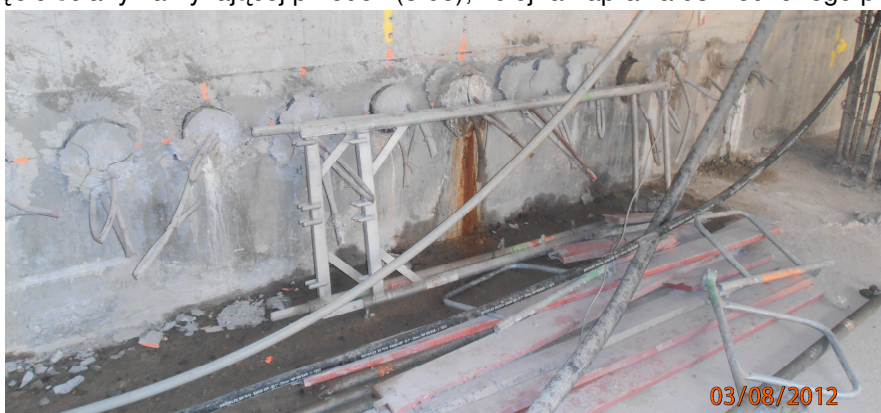
Rys. 6 Pęknięcie ściany zamykającej przodek (3.08); kolejna naprawa uszkodzonego przodka (10.08)
