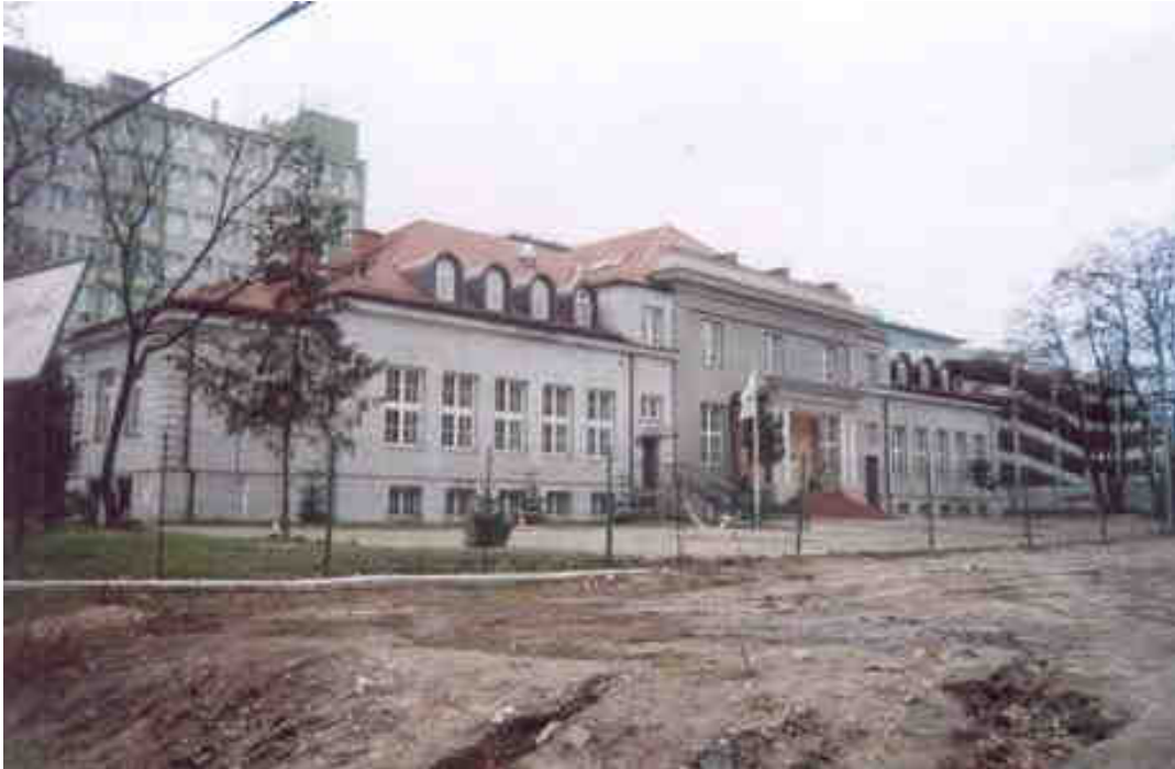
Fot.6 ODCINEK ZACHODNI - ul. Kasprzaka 18 – nr rej. 1437 z dn. 03.07.1990r.
