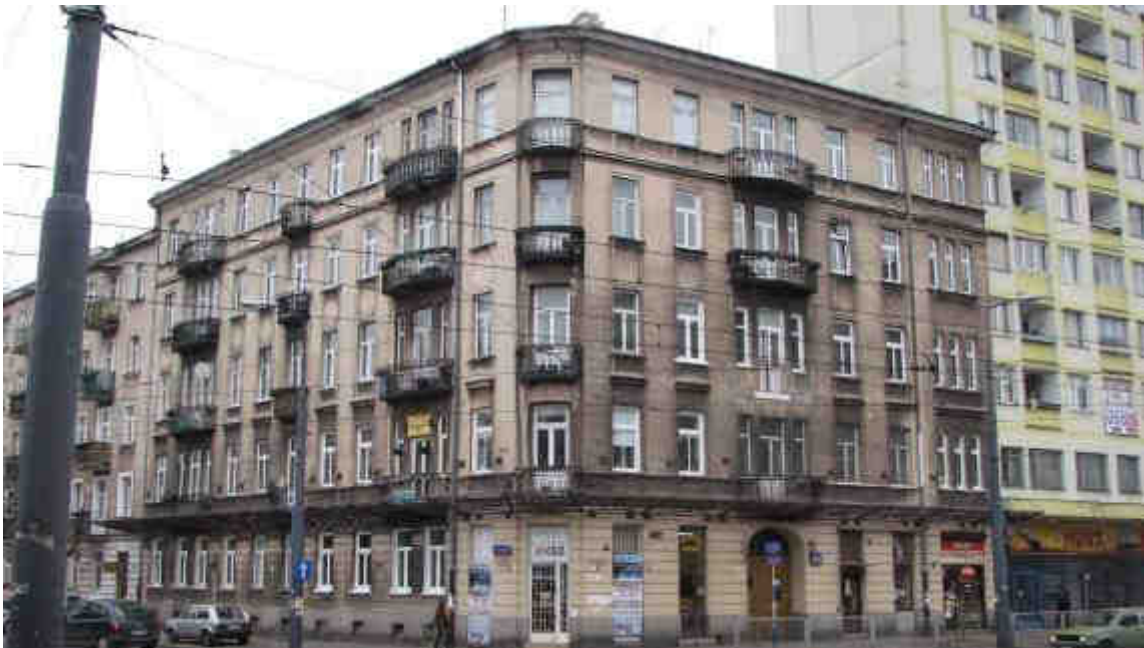
Fot.25 ODCINEK WSCHODNI PÓŁNOCNY - ul. Targowa 84 nr rej. 1565 z dn. 30.03.1994r.
