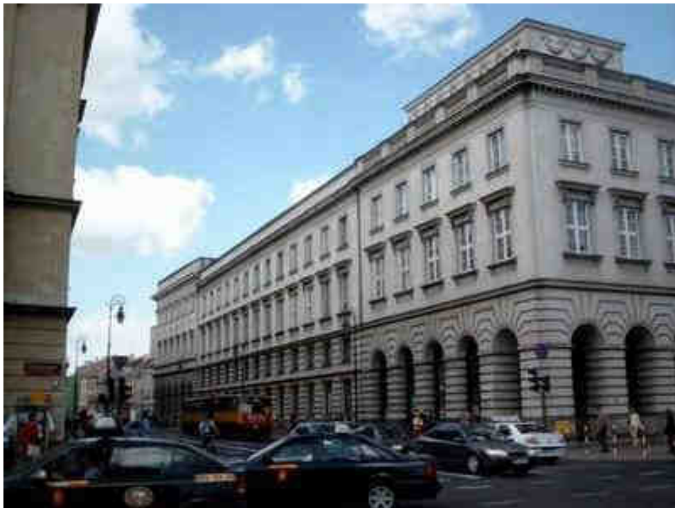
Fot.15 ODCINEK CENTRALNY - ul. Nowy Świat 72/74 – nr rej. 970 z dn. 01.07.1965r.
