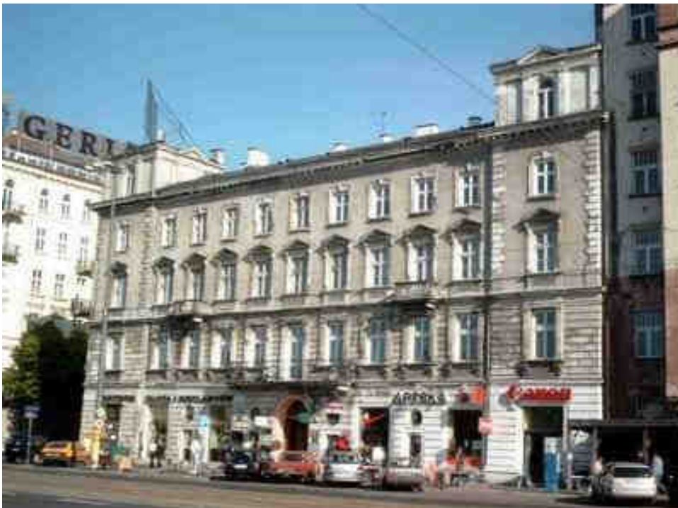
Fot.11 ODCINEK CENTRALNY - ul. Nowy Świat 55 – nr rej. 1575 z dn. 20.04.1994r.
