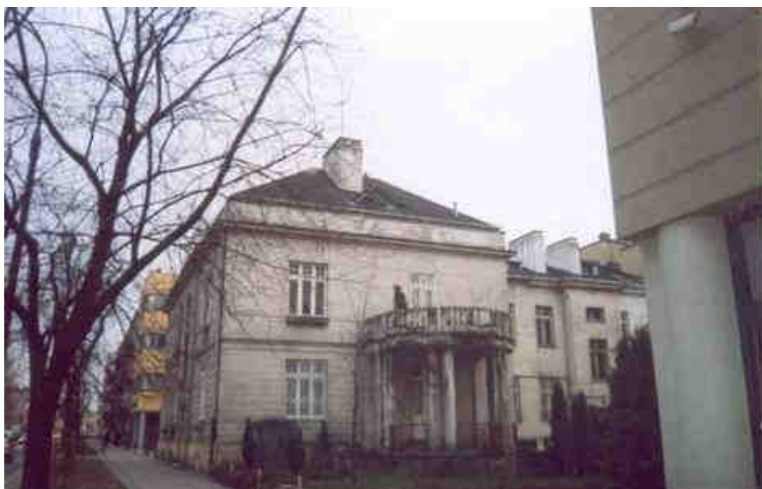
Fot.5 ODCINEK ZACHODNI - ul. Płocka 9/11 – nr rej. 1419 z dn. 17.04.1990r.
