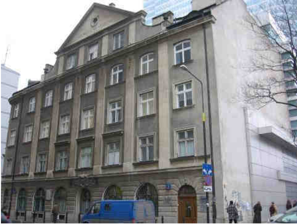
Fot.8 ODCINEK CENTRALNY - ul. Mariańska 1 – nr rej 880 z dn 05.02.1975r.
