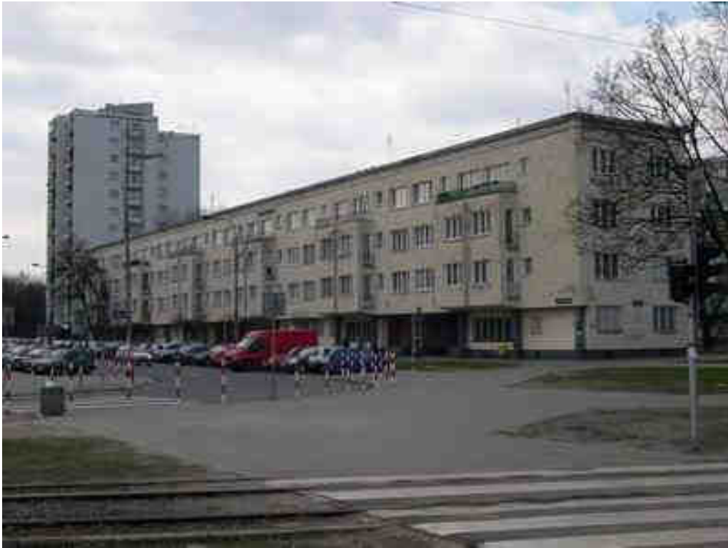
Fot.28 ODCINEK WSCHODNI PÓŁNOCNY - ul. Targowa 83 nr rej. 1558 z dn. 01.07.1965r.
