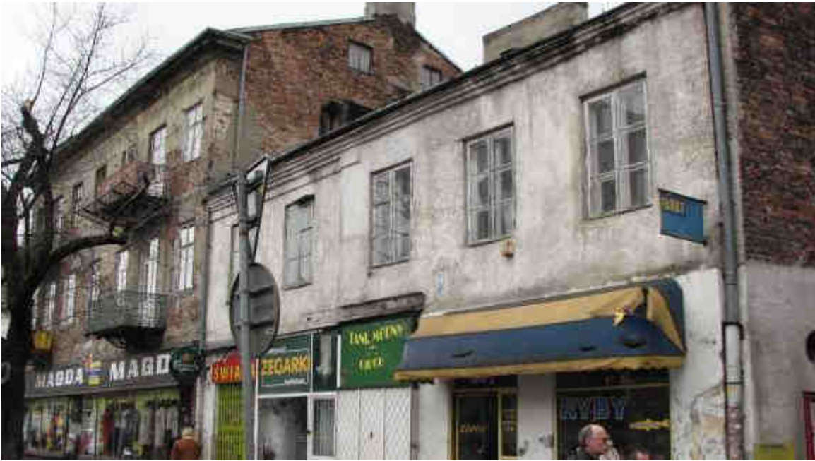
Fot.20 ODCINEK CENTRALNY - ul. Targowa 50/52 nr rej. A-64 z dn. 19.01.2001r.
