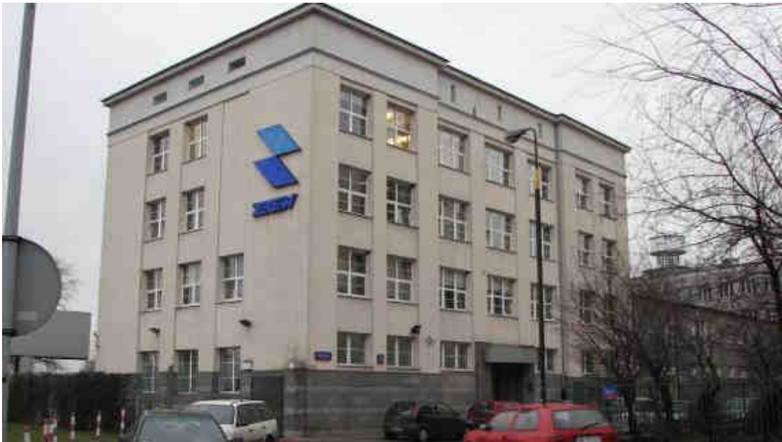
Fot.17 ODCINEK CENTRALNY - ul. Elektryczna 2 – nr rej. A-430 z dn. 06.06.2005r.
