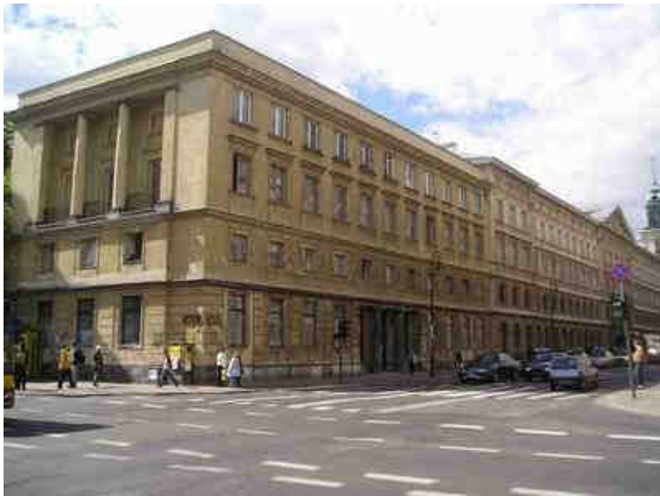
Fot.14 ODCINEK CENTRALNY - ul. Nowy Świat 67/69 – nr rej. 362 z dn. 01.07.1965r.
