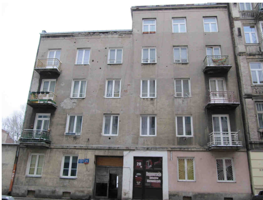
Fot.14 ODCINEK WSCHODNI PÓLNOCNY - ul. Strzelecka 28
