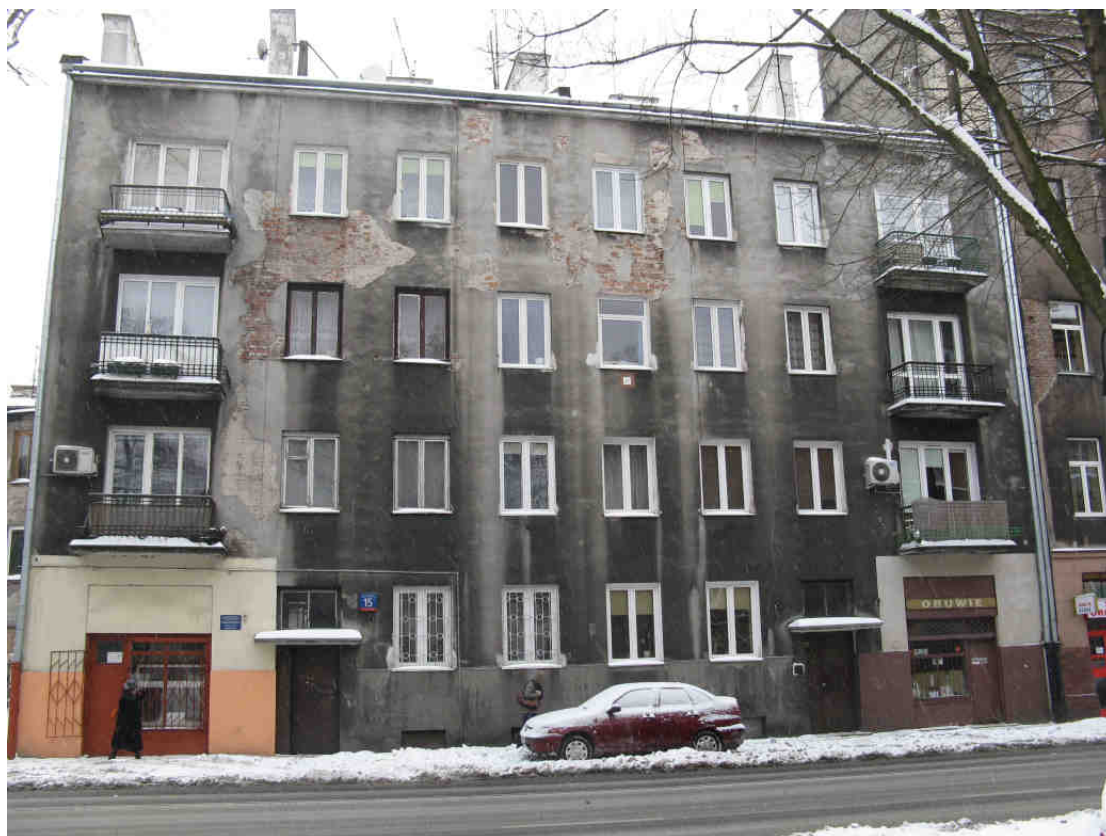
Fot.27 ODCINEK WSCHODNI PÓŁNOCNY - ul. Szwedzka 15
