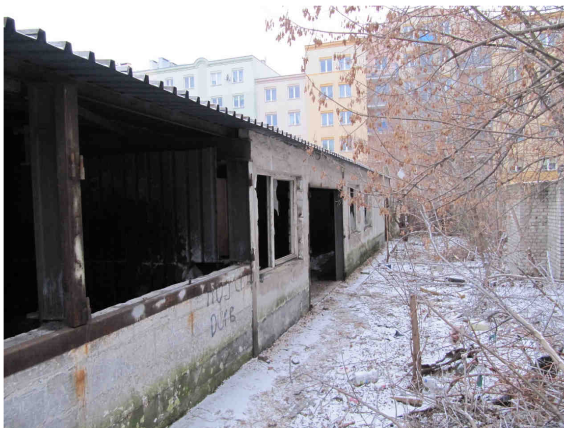
Fot.16 ODCINEK WSCHODNI PÓLNOCNY - ul. Strzelecka 36
