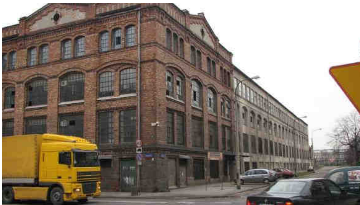
Fot.3 ODCINEK WSCHODNI PÓLNOCNY - ul. Szwedzka 20 nr rej. 400-A z dn. 30.03.2005r.
