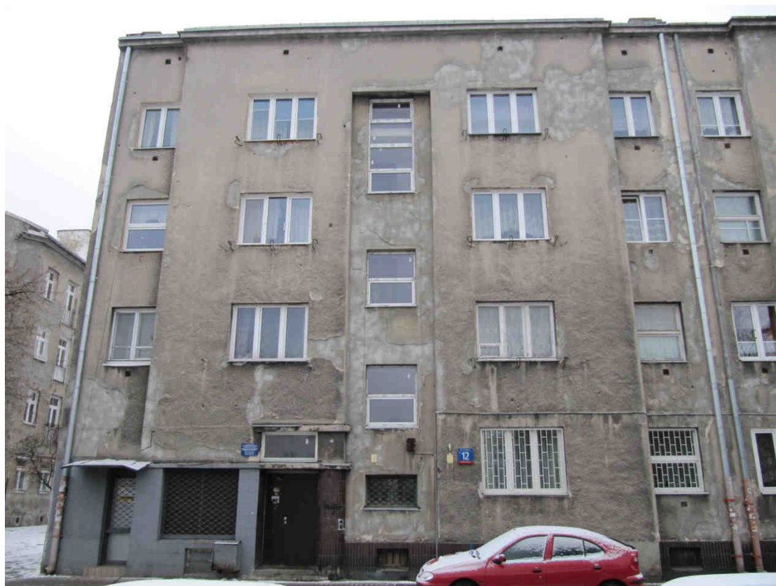
Fot.11 ODCINEK WSCHODNI PÓLNOCNY - ul. Strzelecka 12
