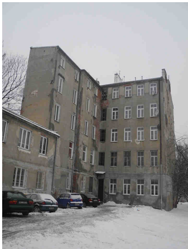
Fot.33 ODCINEK WSCHODNI PÓŁNOCNY - ul. Stalowa 73
