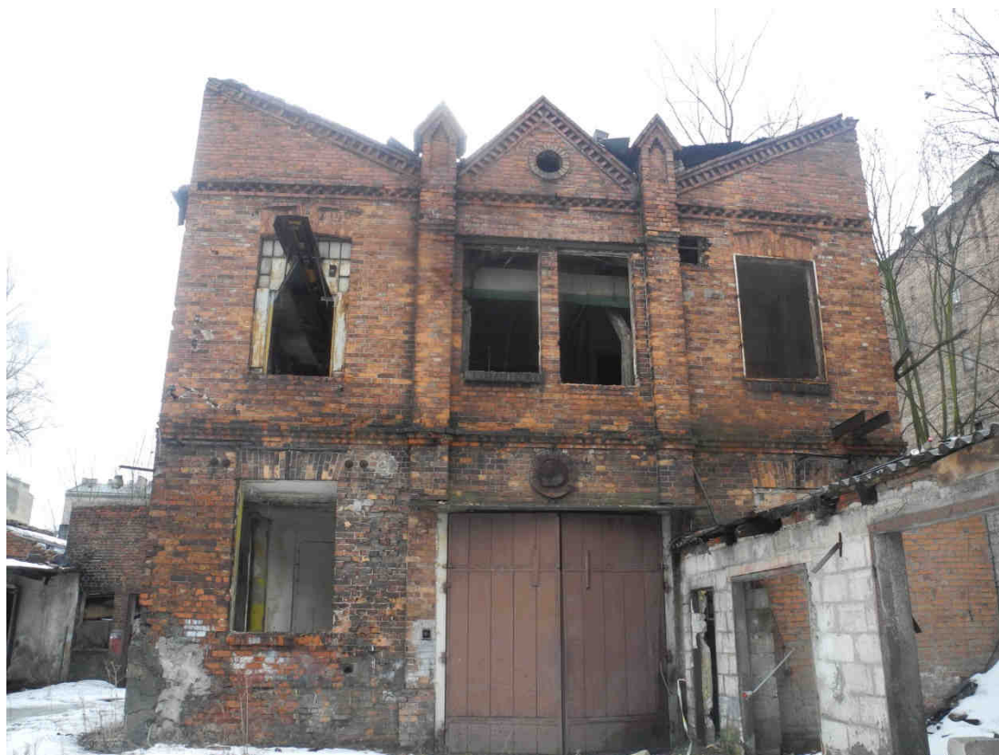
Fot.15 ODCINEK WSCHODNI PÓLNOCNY - ul. Strzelecka 30/32
