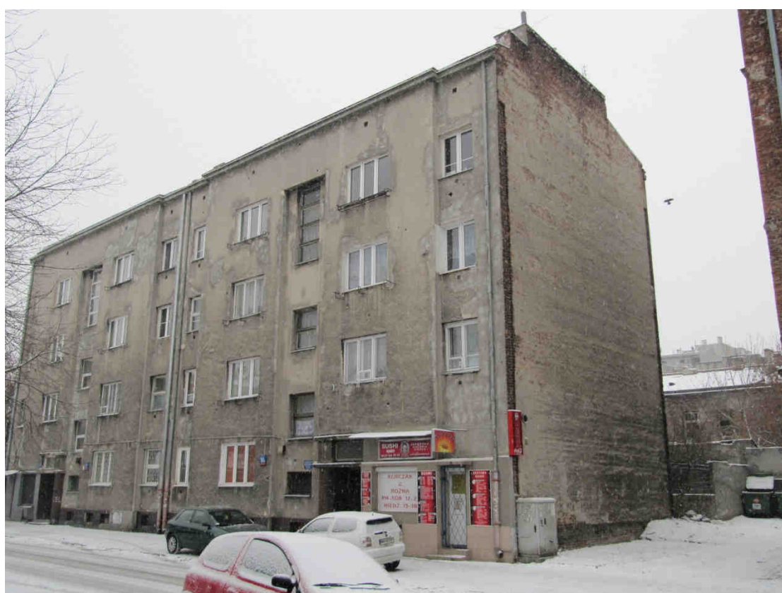
Fot.10 ODCINEK WSCHODNI PÓŁNOCNY - ul. Strzelecka 10A
