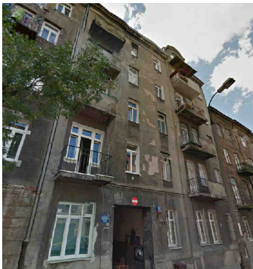
Fot.30 ODCINEK WSCHODNI PÓŁNOCNY - ul. Szwedzka 23
