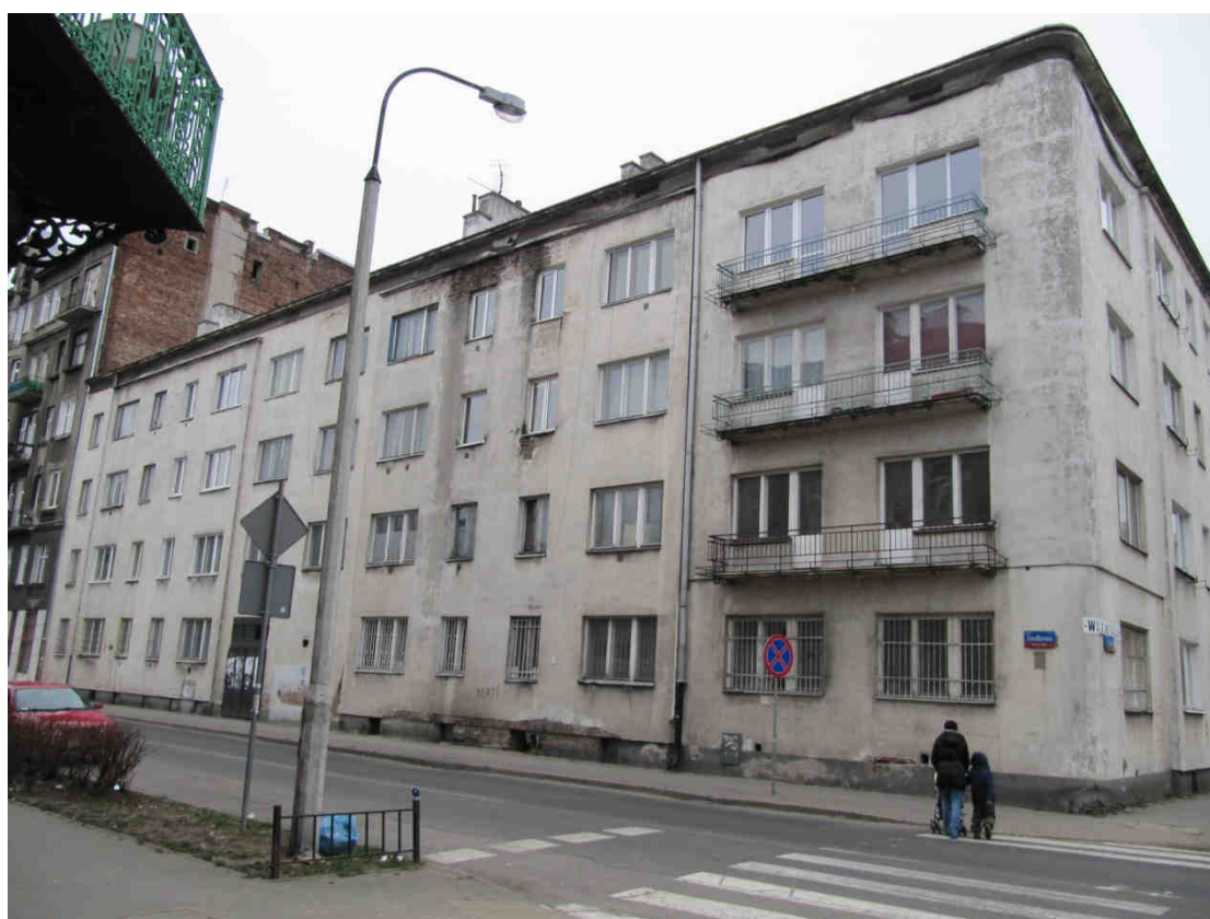
Fot.8 ODCINEK WSCHODNI PÓLNOCNY - ul. Strzelecka 8
