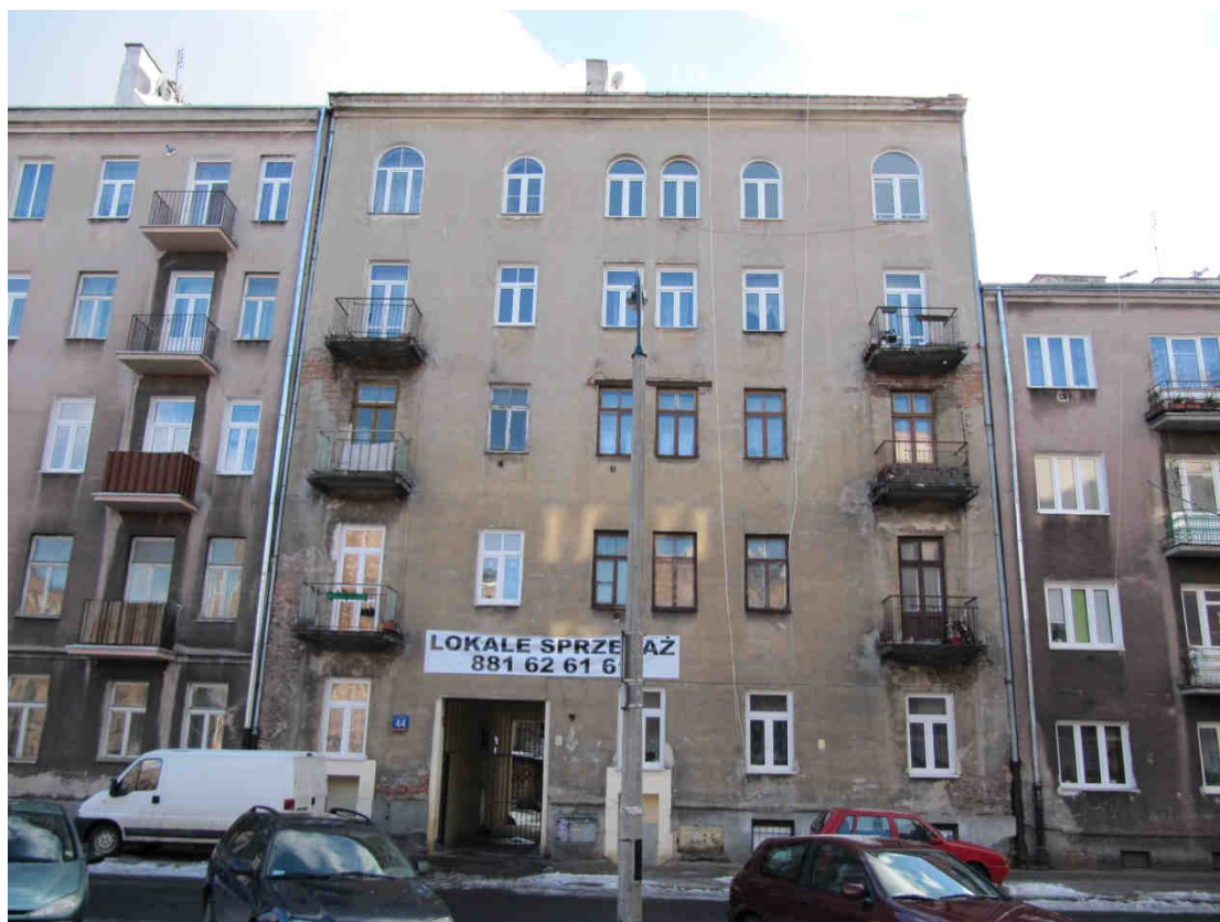
Fot.19 ODCINEK WSCHODNI PÓLNOCNY - ul. Strzelecka 44
