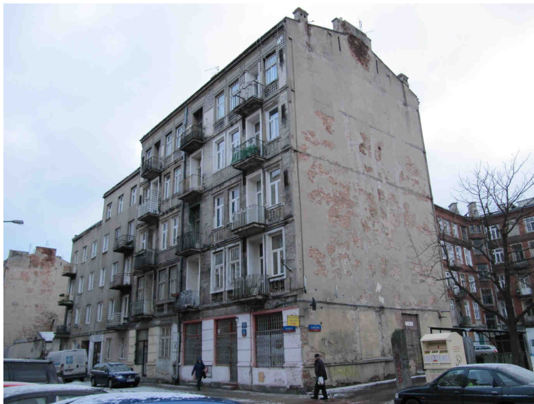
Fot.13 ODCINEK WSCHODNI PÓLNOCNY - ul. Strzelecka 26
