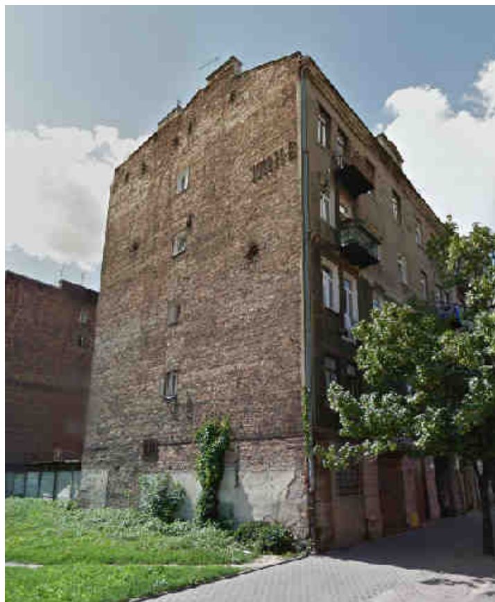
Fot.29 ODCINEK WSCHODNI PÓŁNOCNY - ul. Szwedzka 21
