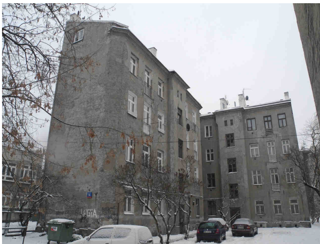
Fot.12 ODCINEK WSCHODNI PÓLNOCNY - ul. Strzelecka 14
