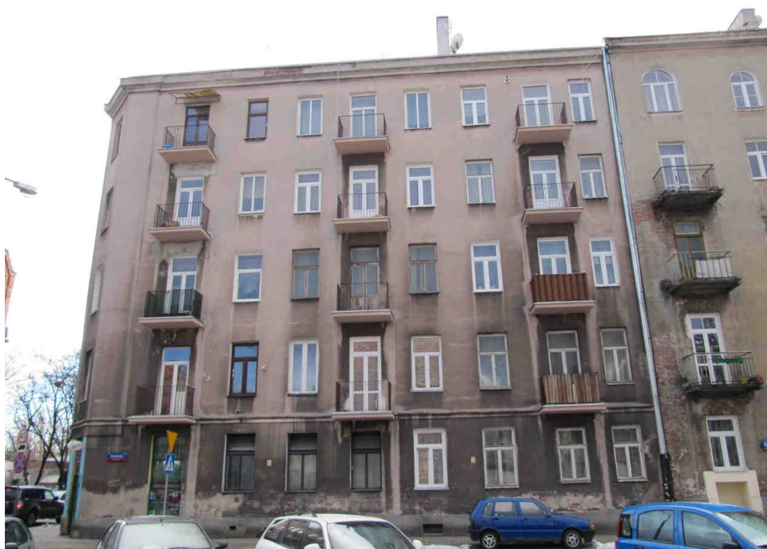
Fot.28 ODCINEK WSCHODNI PÓŁNOCNY - ul. Szwedzka 17
