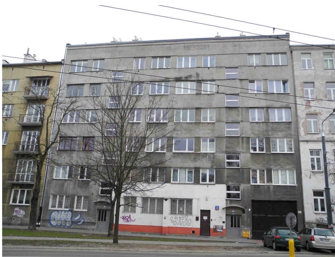
Fot.22 ODCINEK WSCHODNI PÓLNOCNY - ul. 11 Listopada 28
