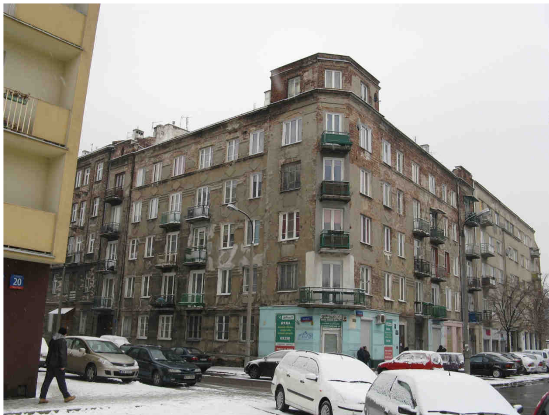
Fot.5 ODCINEK WSCHODNI PÓLNOCNY - ul. Strzelecka 2
