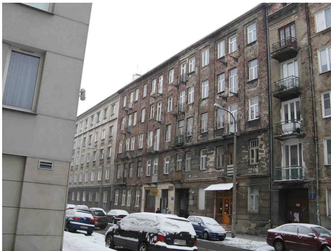
Fot.7 ODCINEK WSCHODNI PÓLNOCNY - ul. Strzelecka 4
