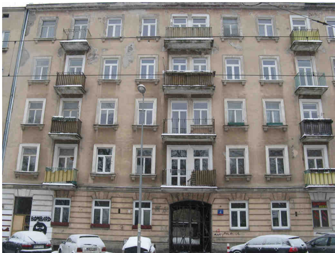
Fot.21 ODCINEK WSCHODNI PÓLNOCNY - ul. 11 Listopada 4
