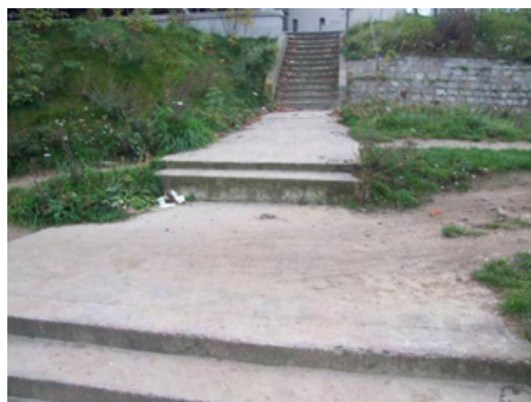
Fot. 225 – Ciąg schodów z poziomu bulwaru na poziom ulicy
