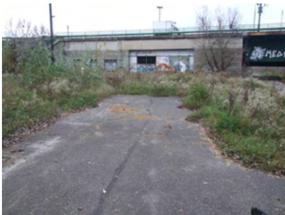
Fot. 89 – Urwany fragment bitumicznej drogi dojazdowej
