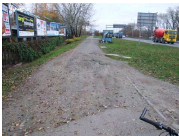
Fot. 98 – Zniszczona nawierzchnia ścieżki
