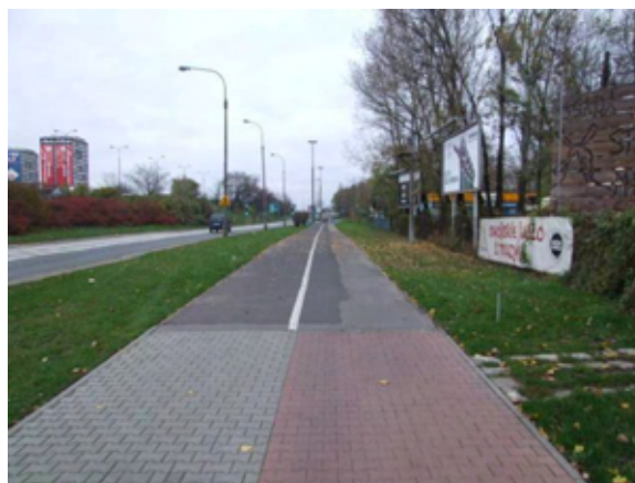
Fot. 111 – Odcinek wzdłuż Wybrzeża Gdyńskiego na wysokości K.S. Spójnia – zmiana nawierzchni
