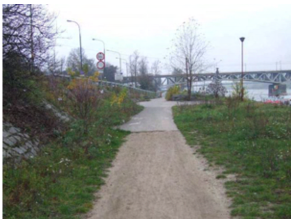
Fot. 220 – Odcinek do mostu w poziomie bulwaru – zmiana nawierzchni
