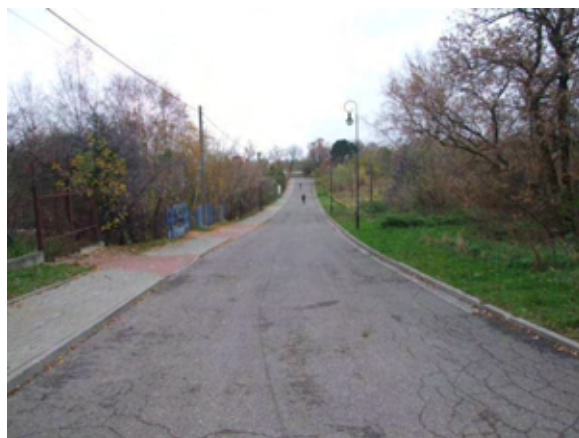
Fot. 46 – Ul. Farysa [8] – widok w stronę południową
