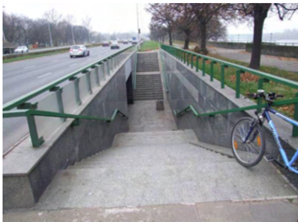
Fot. 170 – Przejście podziemne przy ul. Boleść
