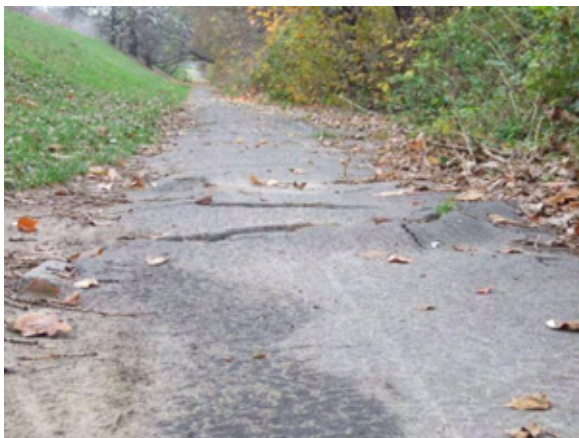
Fot. 71 – Odcinek wzdłuż Wybrzeża Gdynińskiego – pęknięcia i fałdy poprzeczne
