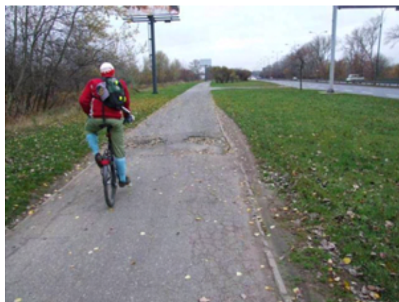
Fot. 100 – Zniszczenia nawierzchni ścieżki
