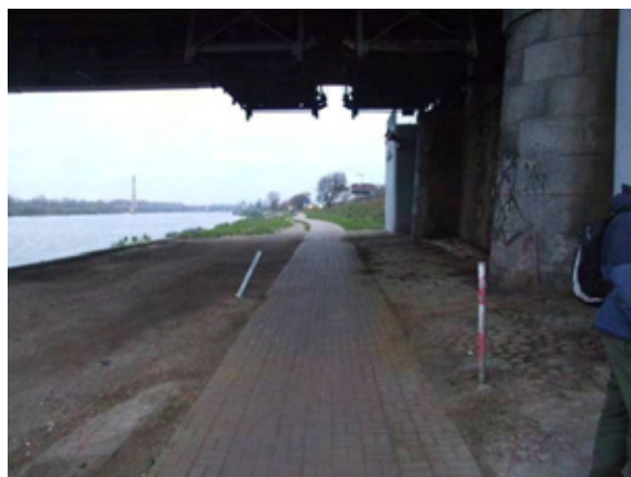
Fot. 185 – Ścieżka rowerowa pod Mostem Śląsko-Dąbrowskim
