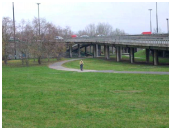
Fot. 85 – Układ ścieżek na wysokości Mostu Grota-Roweckiego
