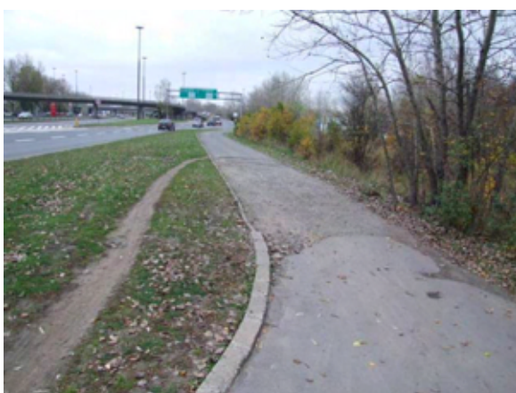
Fot. 97 – Zniszczona nawierzchnia ścieżki – przejazd trawnikiem
