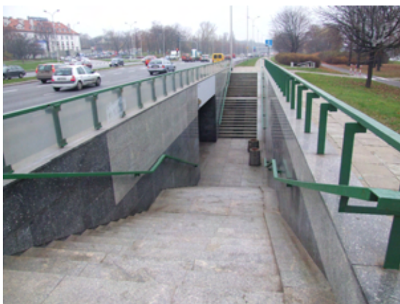
Fot. 307 – Widok ogólny na wejście do przejścia podziemnego pod Wisłostradą w rejonie ul. Sanguszki
