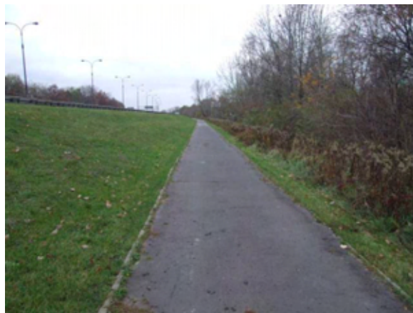
Fot. 84 – Odcinek wzdłuż Wybrzeża Gdynńskiego pomiędzy ul. Gwiaździstą a mostem Grota-Roweckiego
