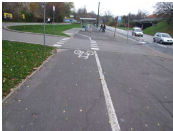
Fot. 108 – Odcinek wzdłuż łącznicy (węzeł – ul. Krasieńskiego)
