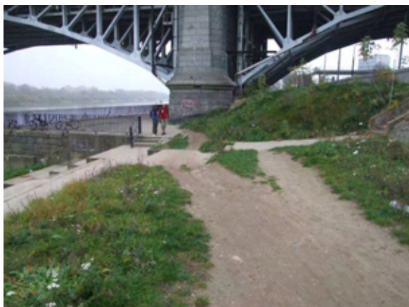
Fot. 222 – Nieuregulowany przejazd pod Mostem Poniatowskiego
