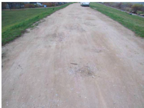
Fot. 292 – Odcinek wzdłuż Cypla Czerniakowskiego – uszkodzenia nawierzchni
