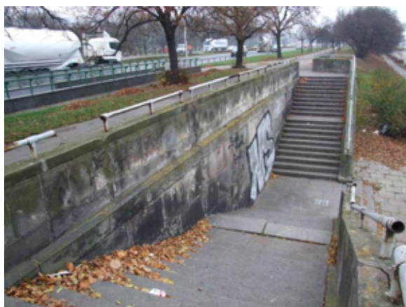
Fot. 169 – Zejście na bulwar na wysokości ul. Boleść
