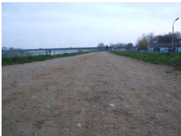
Fot. 286 – Nawierzchnia gruntowa ulepszona
