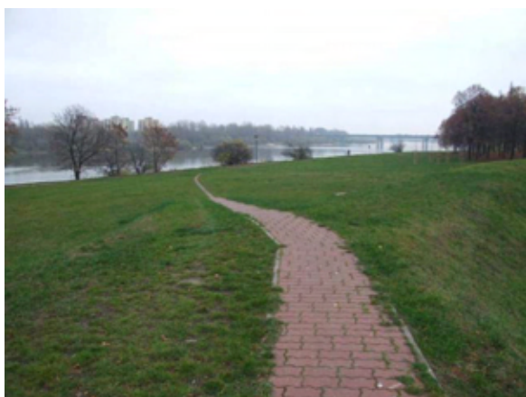
Fot. 262 – Uregulowane przejście przez wał
