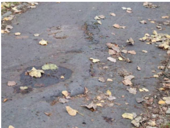
Fot. 139 – Nawierzchnia zniszczona przez korzenie drzewa
