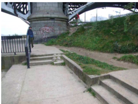
Fot. 224 – Nieuregulowany przejazd pod Mostem Poniatowskiego
