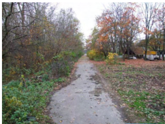
Fot. 122 – Teren na tyłach K.S. Spójnia – fragment zniszczonej nawierzchni bitumicznej
