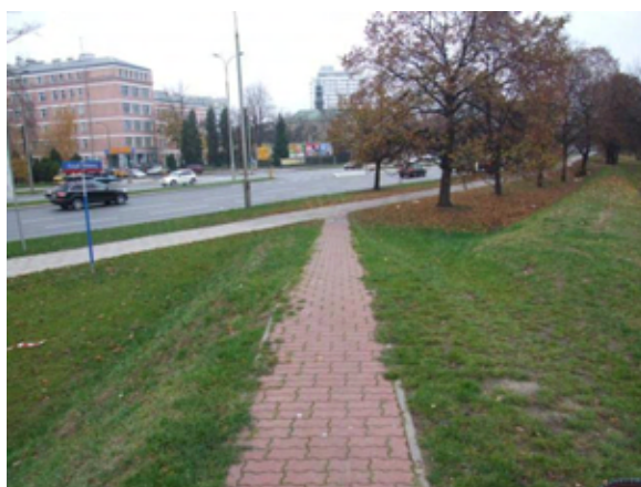
Fot. 261 – Uregulowane przejście przez wał
