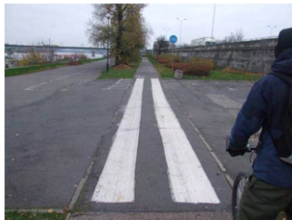
Fot. 177 – Przejście dla pieszych przez zjazd na drogę techniczną (bulwar)
