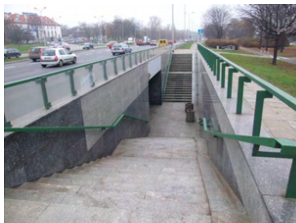
Fot. 159 – Przejście podziemne przy ul. Sanguszki
