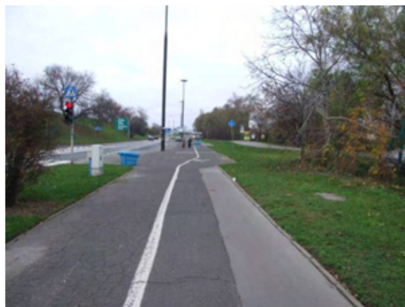
Fot. 110 – Odcinek wzdłuż Wybrzeża Gdyńskiego (węzeł – ul. Krasieńskiego)
