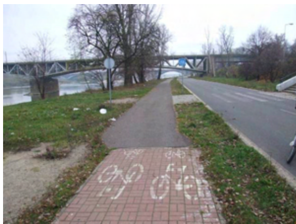
Fot. 211 – Zmiana nawierzchni ścieżki
