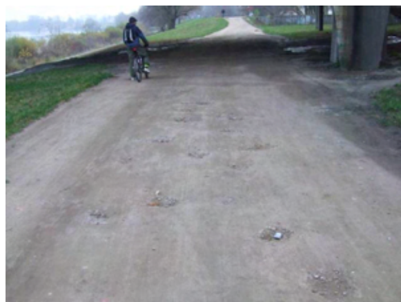
Fot. 293 – Odcinek wzdłuż Cypla Czerniakowskiego pod mostem Łazienkowskim – uszkodzenia nawierzchni
