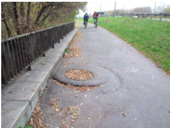
Fot. 81 – Zapadnięta nawierzchnia przy wlocie do kanału w rejonie węzła „Gwiaździsta”
