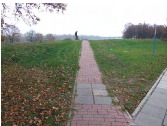
Fot. 260 – Uregulowane przejście przez wał
