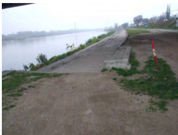
Fot. 195 – wjazd na uczęszczane przez rowerzystów umocnienie brzegu - pod Mostem Śląsko-Dąbrowskim
