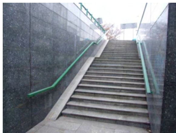
Fot. 157 – Przejście podziemne przy ul. Sanguszki
