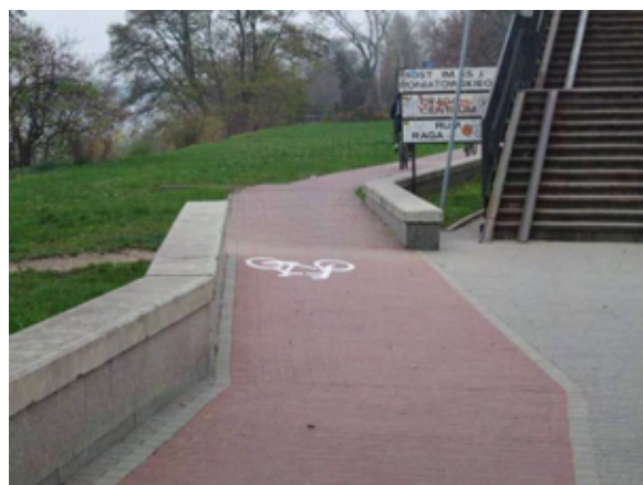
Fot. 243 – Odcinek ścieżki rowerowej wzdłuż ul. Wioślarskiej
