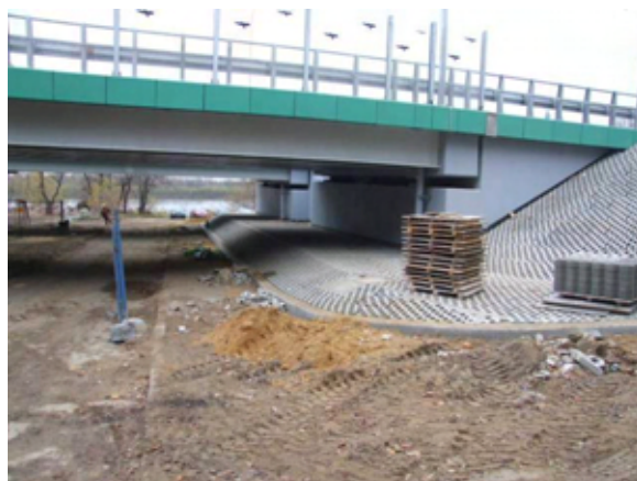
Fot. 62 – Przejazd pod przyczółkiem do ul. Pergaminów
