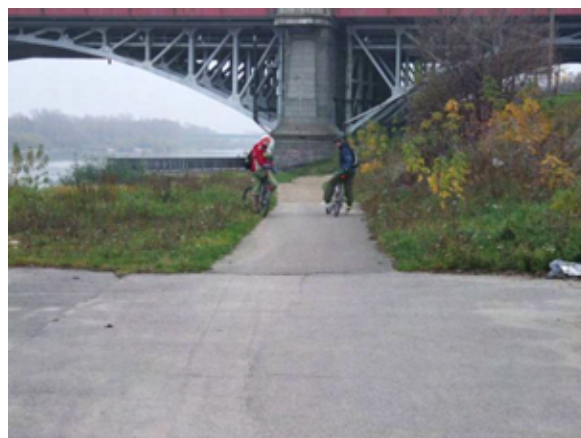
Fot. 219 – Odcinek o nawierzchni bitumicznej do mostu – poziom bulwaru
