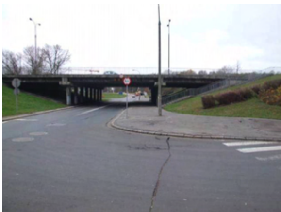
Fot. 79 – Węzeł - ul. Gwiaździsta
