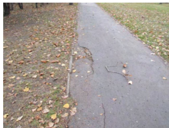
Fot. 132 – Pęknięcia nawierzchni ścieżki
