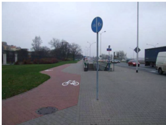
Fot. 189 – Ścieżka rowerowa wzdłuż Wybrzeża Gdańskiego od strony Starego Miasta
