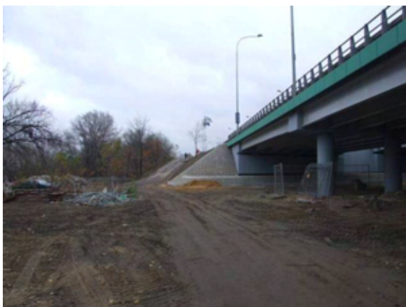
Fot. 61 – Przyczółek południowy estakady
