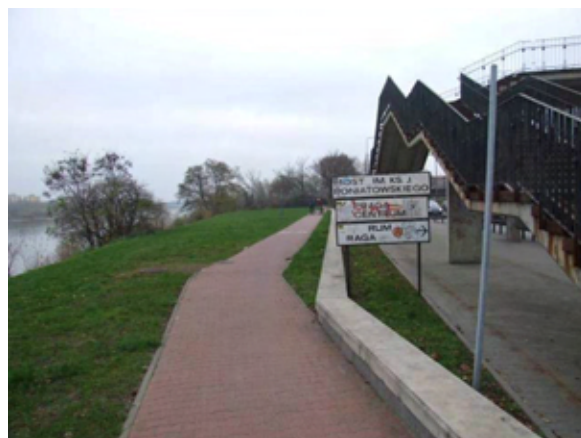
Fot. 245 – Odcinek ścieżki rowerowej wzdłuż ul. Wioślarskiej
