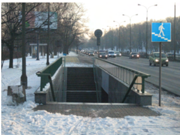
Fot. 305 – Widok ogólny na wejście do przejścia podziemnego pod Wisłostradą w rejonie Cytadeli
