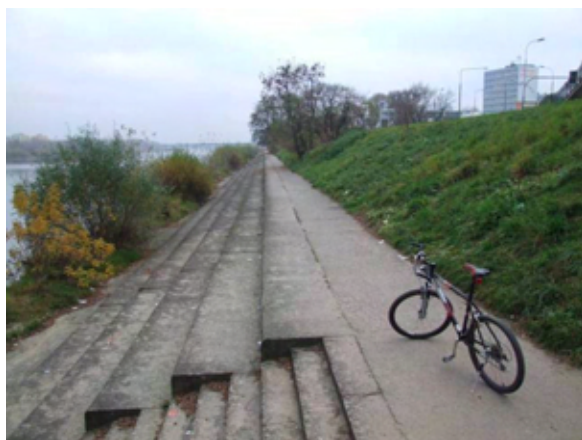
Fot. 228 – Uczęszczany odcinek umocnienia brzegu Wisły
