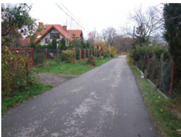
Fot. 39 – Ul. Prozy – szerokość jezdni 4,2m
