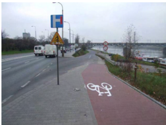
Fot. 238 – Wyprowadzenie ścieżki rowerowej na poziom Wyrzeża Kościuszkowskiego
