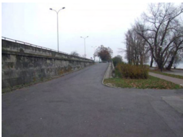
Fot. 178 – Zjazd na bulwar (na wysokości ul. Boleść)
