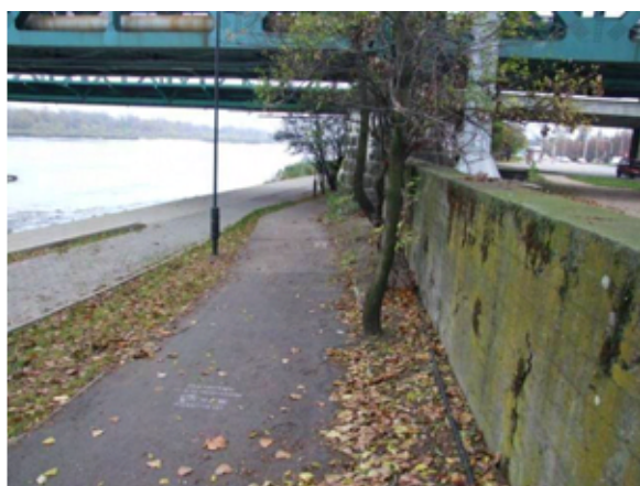
Fot. 146 – Odcinek przed Mostem Gdańskim – wzdłuż muru przeciw-powodziowego
