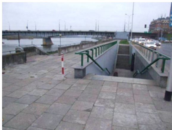
Fot. 183 – Przejście podziemne na wysokości ul. Grodzkiej
