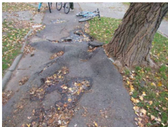
Fot. 130 – Nawierzchnia zniszczona przez korzenie drzewa
