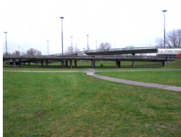
Fot. 86 – Układ ścieżek na wysokości Mostu Grota-Roweckiego
