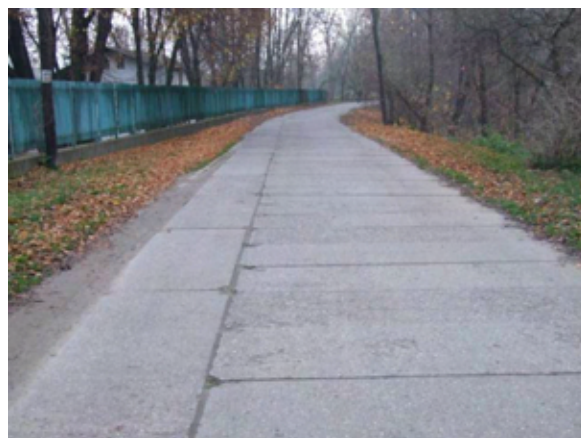
Fot. 299 – Droga wzdłuż terenu ZHP
