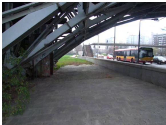
Fot. 241 – Przestrzeń pomiędzy filarem a ścieżką rowerową
