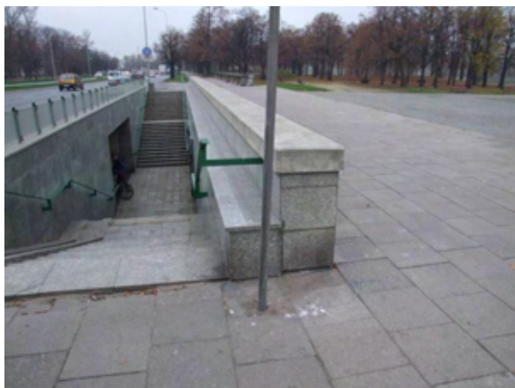
Fot. 275 – Przejście podziemne pod ul. Solec w stronę Pomnika Sapera
