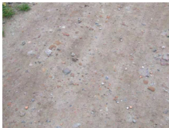
Fot. 221 – Odcinek do mostu w poziomie bulwaru – zmiana nawierzchni
