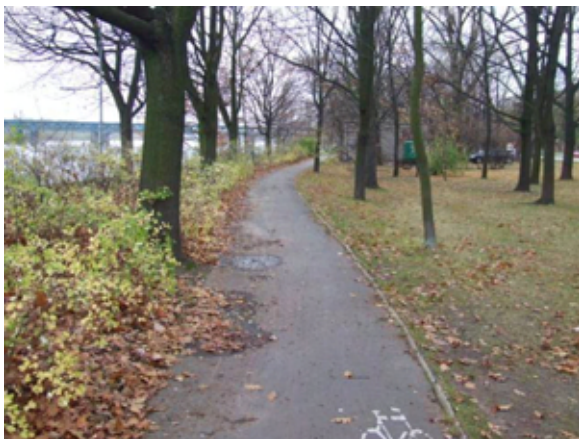
Fot. 133 – Odcinek ścieżki rowerowej wzdłuż bulwaru – krzewy w skrajni, zastoiska wody
