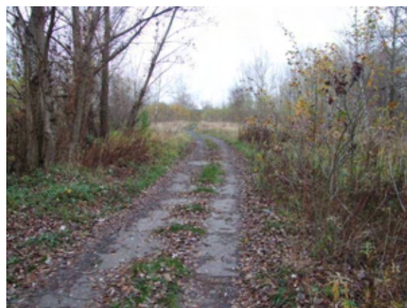
Fot. 92 – Zniszczony fragment nawierzchni bitumicznej
