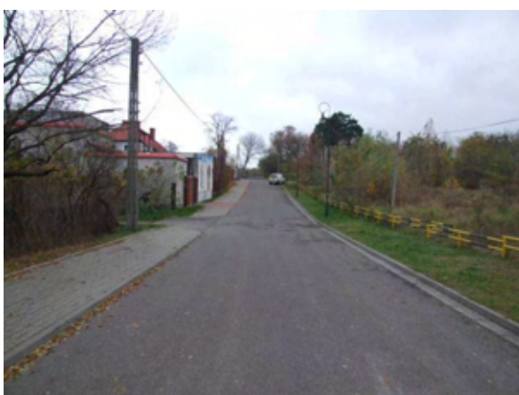
Fot. 47 – Ul. Farysa [8] – widok w stronę południową
