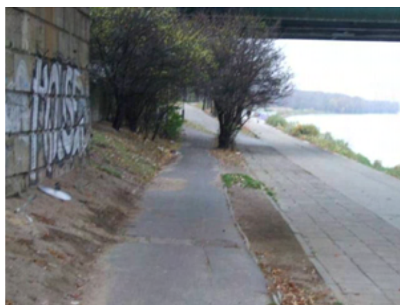
Fot. 147 – Przejazd pod Mostem Gdańskim (ograniczona krzewami widoczność przejazdu)
