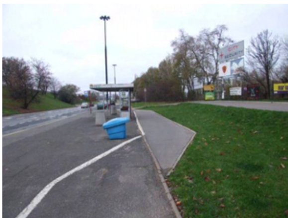
Fot. 109 – Odcinek wzdłuż łącznicy (węzeł – ul. Krasieńskiego) – przejazd za wiatą przystanku
