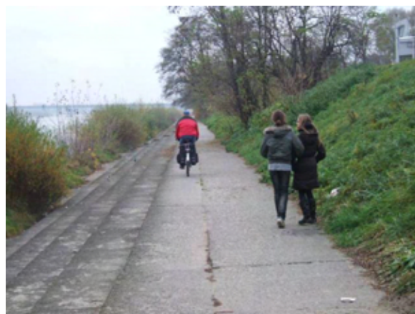
Fot. 229 – Uczęszczany odcinek umocnienia brzegu Wisły
