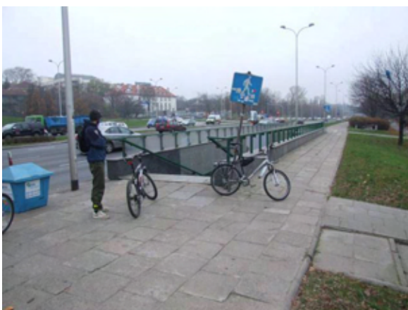
Fot. 156 – Przejście podziemne przy ul. Sanguszki
