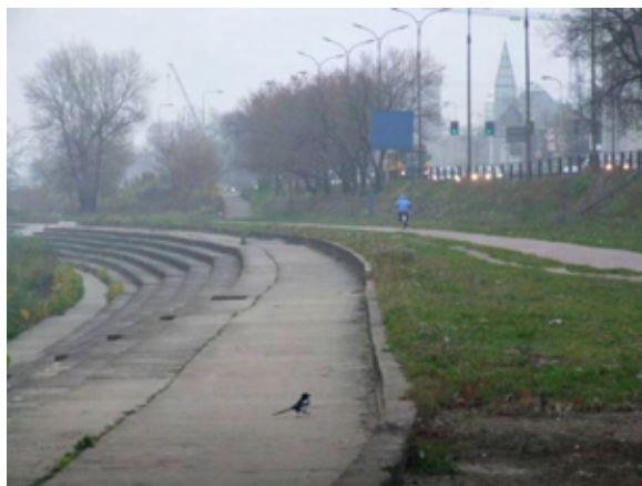
Fot. 199 – Betonowe wzmocnienie brzegu wzdłuż Wybrzeża Kościuszkowskiego
