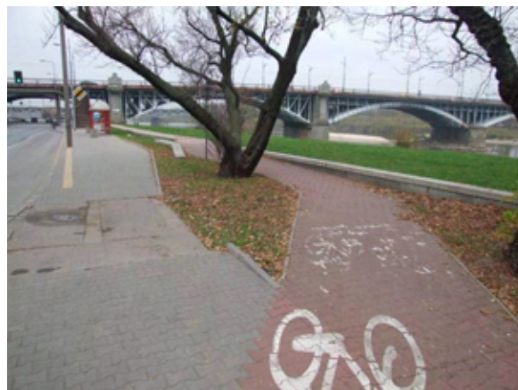
Fot. 247 – Odcinek ścieżki rowerowej wzdłuż ul. Wioślarskiej – drzewo w skrajni ścieżki
