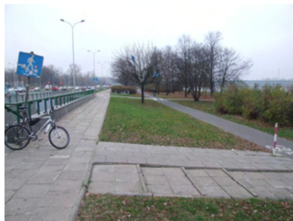
Fot. 308 – Widok ogólny na teren wokół wschodniego wejścia do przejścia podziemnego w rejonie ul. Sanguszki
