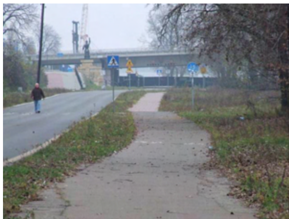
Fot. 210 – Zmiana nawierzchni ścieżki
