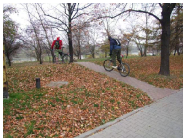
Fot. 255 – Przejazd przez wał – nawierzchnia z kostki
