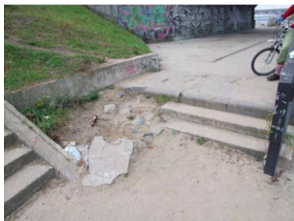
Fot. 227 – Uczęszczany przejazd pod Mostem Poniatowskiego – podjazd usypany przez rowerzystów
