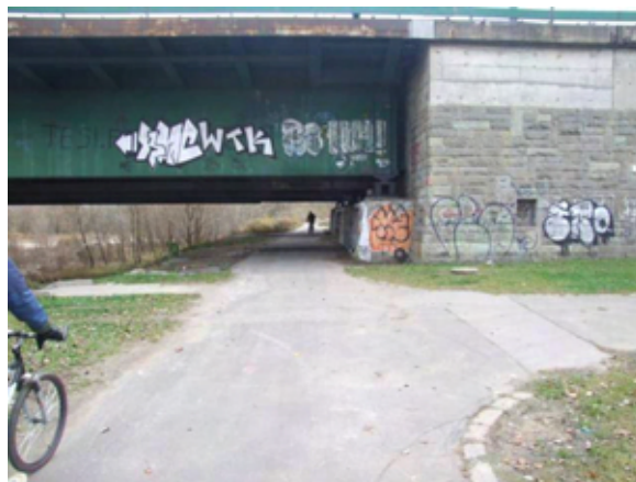
Fot. 88 – Ścieżka pod przyczółkiem mostu Roweckiego
