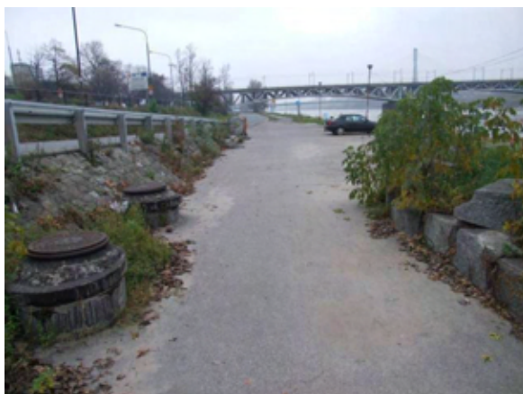
Fot. 218 – Odcinek o nawierzchni bitumicznej do mostu - poziom bulwaru
