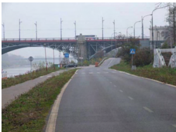
Fot. 216 – Bulwar przed Mostem Poniatowskiego
