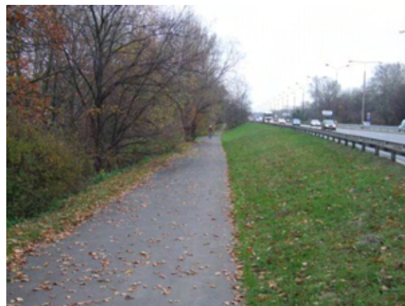
Fot. 68 – Odcinek wzdłuż Wybrzeża Gdyńskiego
