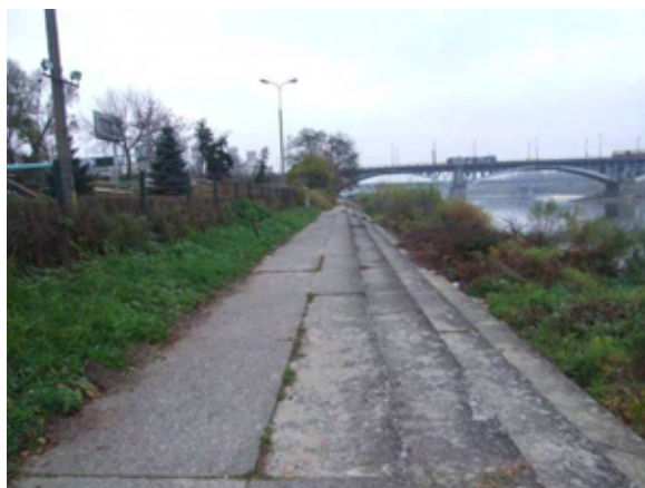
Fot. 231 – Odcinek wzdłuż terenu Warszawskiego Towarzystwa Wioślarskiego
