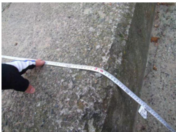
Fot. 230 – Szerokość uczęszczanego umocnienia - 3 m, w miejscu schodów - 2,30 m
