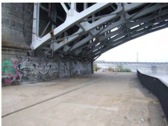
Fot. 226 – Uczęszczany przez rowerzystów odcinek pod filarem mostu
