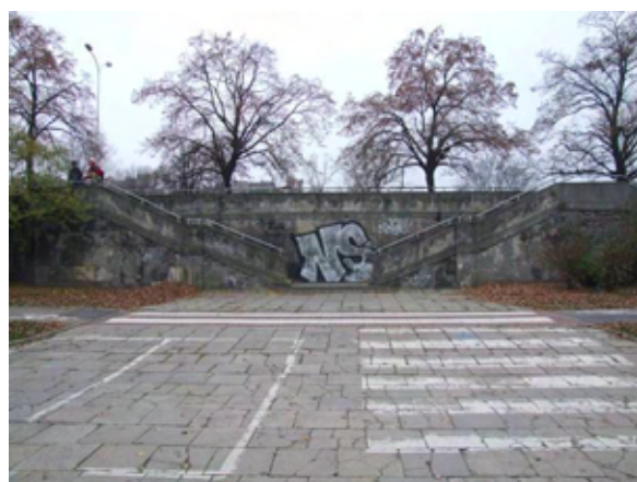
Fot. 312 – Widok na ścianę czołową zejścia na bulwar wiślany
