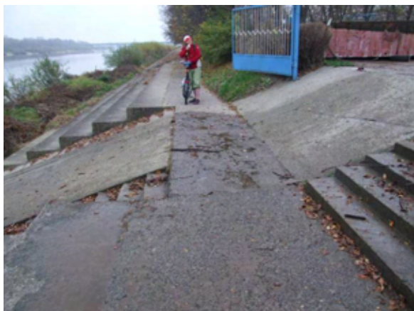
Fot. 232 – Odcinek wzdłuż terenu Warszawskiego Towarzystwa Wioślarskiego
