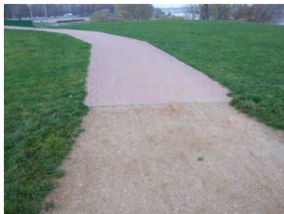
Fot. 285 – Zmiana nawierzchni na gruntową ulepszoną
