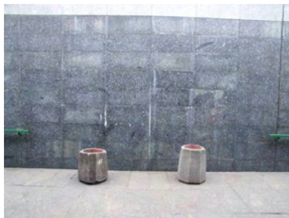
Fot. 314 – Ściana czołowa przejścia podziemnego pod Wisłostradą – ul. Grodzka
