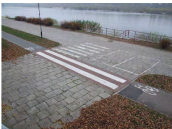
Fot. 168 – Ścieżka na wysokości ul. Boleść – zmiana nawierzchni na przejściu dla pieszych
