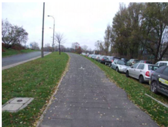
Fot. 103 – Odcinek od Centrum Olimpijskiego do ul. Krasieńskiego (niewielkie spękania siatkowe nawierzchni)
