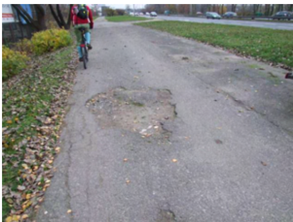
Fot. 99 – Zniszczenia nawierzchni ścieżki
