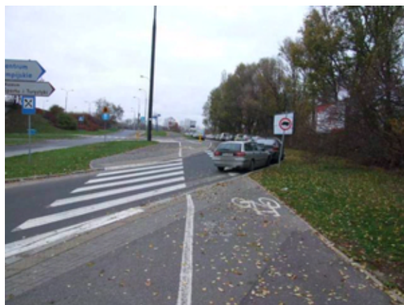
Fot. 106 – Przejazd przez ulicę dojazdową do Centrum Olimpijskiego – odwrotne oznakowanie
