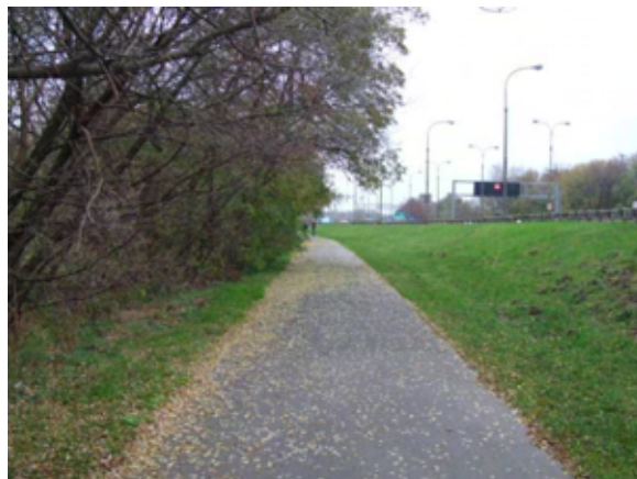
Fot. 82 – Odcinek wzdłuż Wybrzeża Gdynńskiego pomiędzy ul. Gwiaździstą a mostem Grota-Roweckiego
