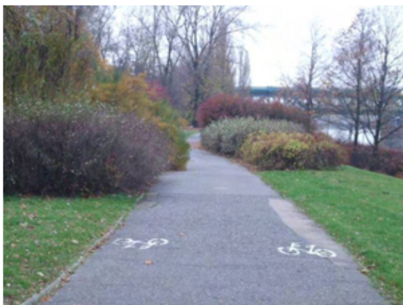
Fot. 152 – Odcinek wzdłuż Wybrzeża Gdańskiego – krzewy w skrajni ścieżki
