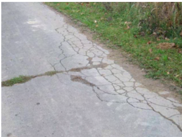
Fot. 57 – Stan nawierzchni ścieżki
