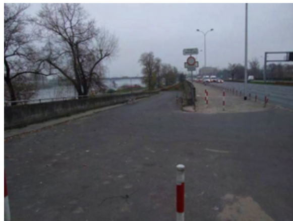
Fot. 173 – Zjazd na bulwar (na wysokości ul. Boleść)
