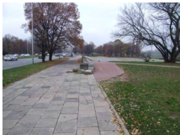
Fot. 274 – Włączenie (podjazd) w ciąg pieszy wzdłuż ul. Solec
