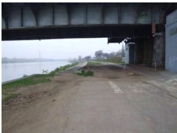
Fot. 184 – Ścieżka rowerowa pod Mostem Śląsko-Dąbrowskim
