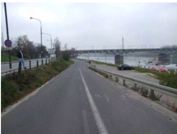
Fot. 236 – Wyprowadzenie ścieżki rowerowej na poziom Wybrzeża Kościuszkowskiego
