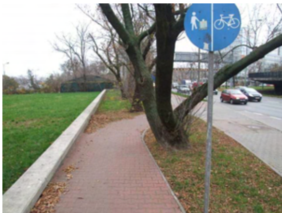
Fot. 246 – Odcinek ścieżki rowerowej wzdłuż ul. Wioślarskiej – drzewo w skrajni ścieżki
