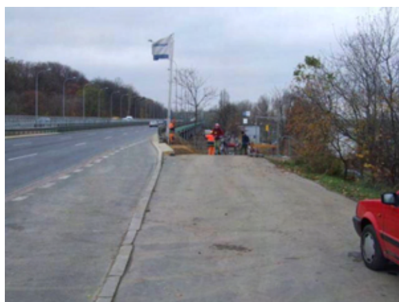
Fot. 66 – Wyjazd na poziom ulicy od strony Wisły
