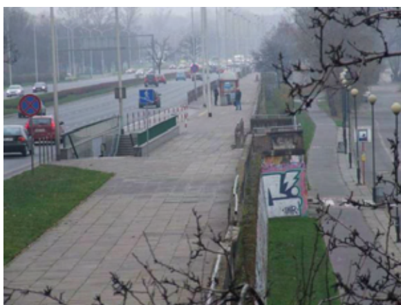
Fot. 311 – Widok ogólny na wejście do przejścia podziemnego pod Wisłostradą i na zejście na bulwar wiślany przy ul. Grodzkiej
