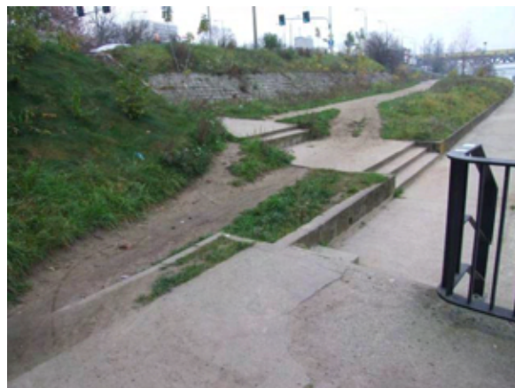
Fot. 223 – Nieuregulowany przejazd pod Mostem Poniatowskiego
