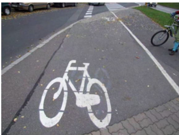
Fot. 105 – Przejazd przez ulicę dojazdową do Centrum Olimpijskiego – odwrotne oznakowanie
