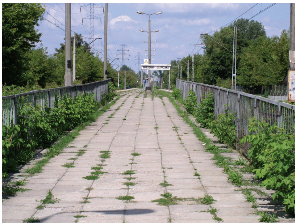
Fot. 4.1 Stacja kolejowa Warszawa-Kasprzaka.
