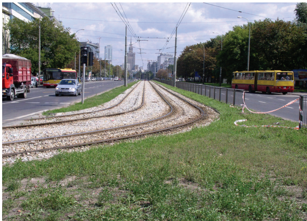
Fot. 4.3 Widok ulicy Kasprzaka, w kierunku Centrum, w miejscu włączenia się trasy z ulicy Skierniewickiej.
