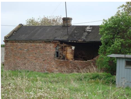
Fot. 5 Budynek mieszkalny w pobliżu skrzyżowania ulicy Poprawnej i Nowo – Bora - Komorowskiego.
