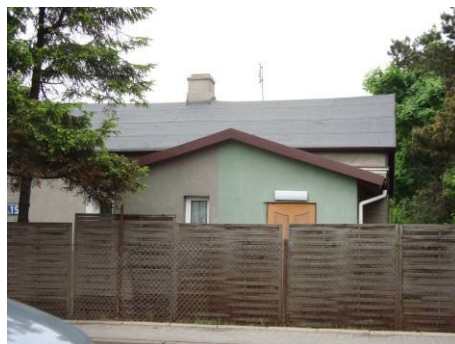
Fot. 10 Budynek mieszkalny w pobliżu skrzyżowania ulicy Zwoleńskiej i Nowo – Bora - Komorowskiego.
