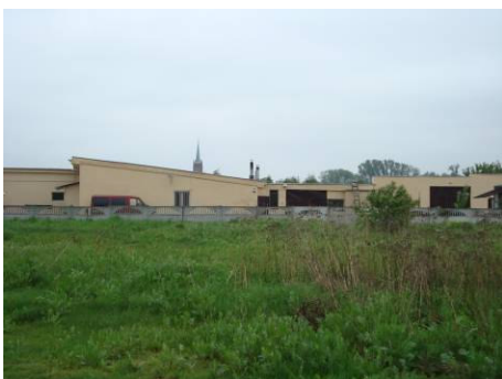
Fot. 7 Budynki przemysłowe w pobliżu ul. Bronowskiej.
