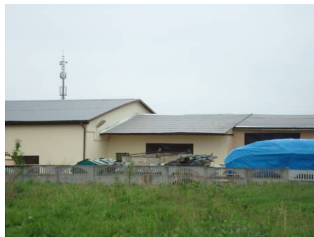
Fot. 6 Budynki przemysłowe w pobliżu ul. Bronowskiej.
