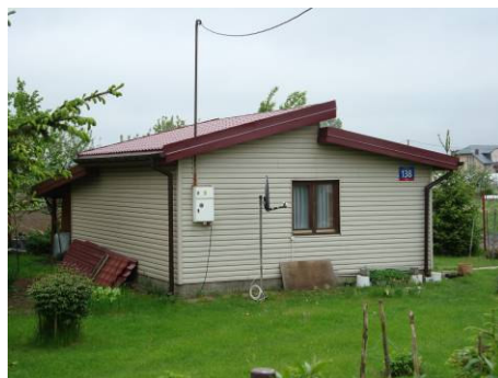
Fot. 4 Budynek mieszkalny w pobliżu skrzyżowania ulicy Poprawnej i Nowo – Bora - Komorowskiego.
