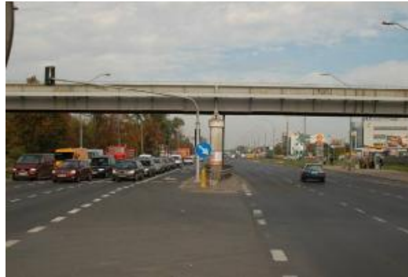
Fot. 6.14 Widok na wiadukt kolejowy w rejonie ul. Żoły – widoczna kolizja trasy tramwaju z podporą wiaduktu
