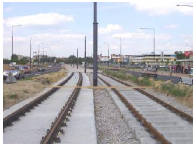
Fot. 9.2 Przykład torowiska tramwajowego przygotowanego pod zabudowę nawierzchnią trawiastą
