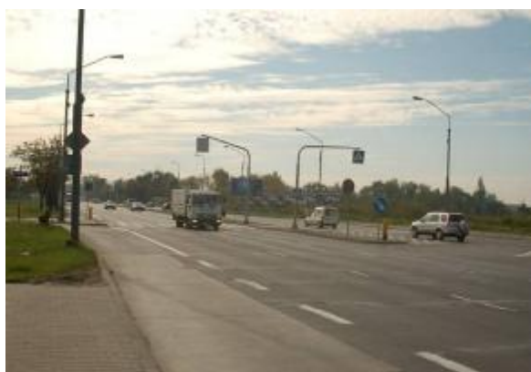
Fot. 6.28 Rejon usytuowania zespołu przystankowego tramwajowego Dąbrówka – widok w kierunku centrum Piaseczna
