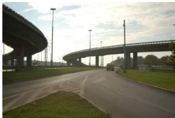
Fot. 6.4 Węzeł drogowy Puławska – Rzymowskiego. Widok w kierunku Piaseczna na łącznicę wjazdową z ul. Rzymowskiego
