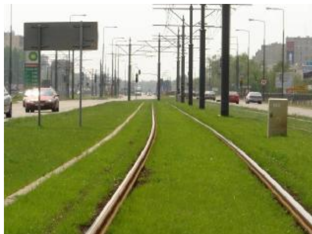
Fot. 9.4 Trasa tramwajowa z Bemowa na Bielany – przykład odcinka szlakowego z torowiskiem zabudowanym nawierzchnią trawiastą
