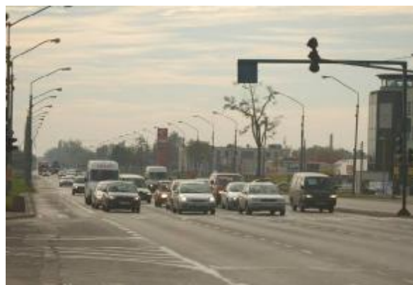
Fot. 6.22 Skrzyżowanie ulic Puławskiej z Karczunkowską (widok na południowy wlot ul. Puławskiej)
