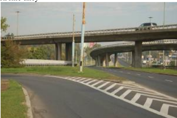
Fot. 6.3 Węzeł drogowy Puławska – Rzymowskiego. Widok w kierunku pętli tramwajowej Wyścigi
