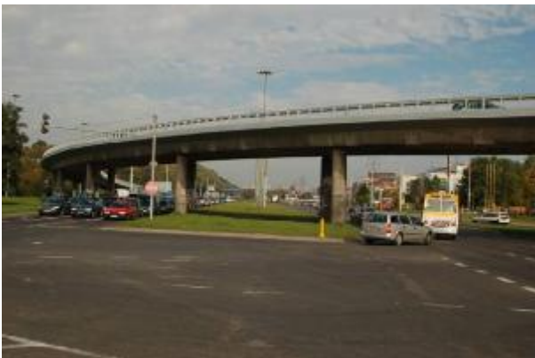
Fot. 6.7 Węzeł Puławska/Poleczki/Pileckiego - usytuowanie podpór estakady w pasie dzielącym ul. Puławskiej i widoczna rezerwa terenu pod trasę tramwajową
