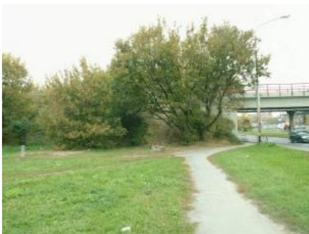
Fot. 6.29 Nasyp przed wiaduktem kolejowym – miejsce na wykonanie tunelu dla trasy tramwajowej.
