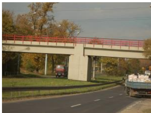
Fot. 6.30 Wiadukt kolejowy bocznicą kolejowej do terenów Thompson-Polkolor – widoczna podpora wiaduktu w pasie dzielącym ul. Puławskiej.
