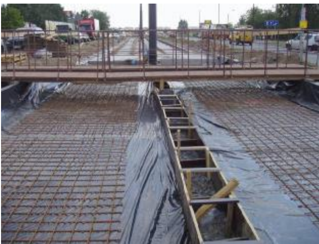
Fot. 9.1 Przykład koryta trasy tramwajowej wyłożonego matą podtorową i przygotowanego pod układanie podkładów betonowych
