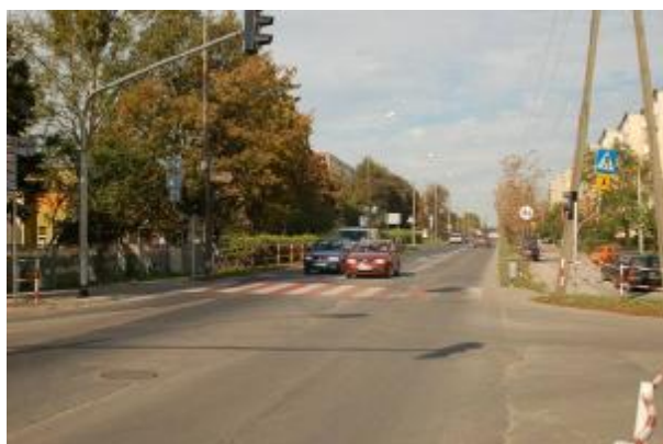
Fot. 6.34 Skrzyżowanie ul. Wojska Polskiego i Szkolnej – rejon usytuowania przystanku tramwajowego Szkolna.
