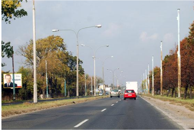
Fot. 5.1 ul. Puławska – widoczne słupy po trakcji trolejbusowej
