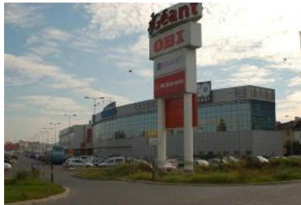
Fot. 6.12 Centrum handlowe usytuowane w sąsiedztwie zespołu przystankowego Sójki .
