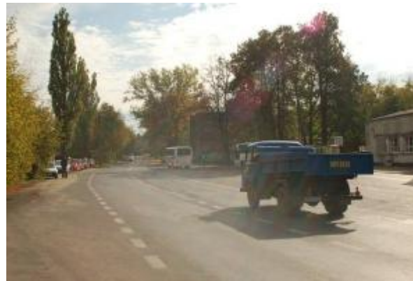
Fot. 6.39 Rejon usytuowania zespołu przystankowego Piaseczno Stacja
