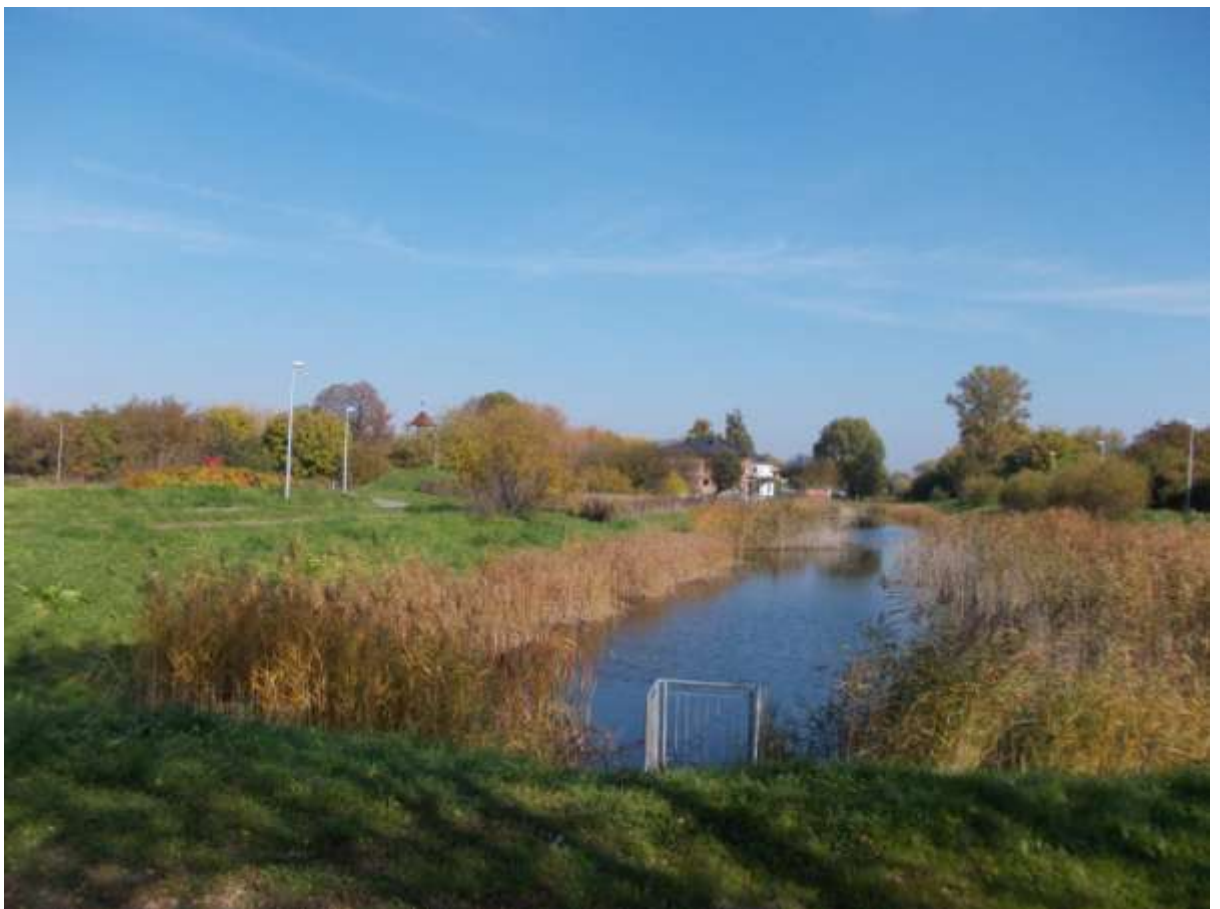
Rysunek 22 Rejon Fosi Wolickiej, jeden z trzech zbiorników (środkowy), w tle zabudowa zlokalizowana przy ul. Wolickiej 8, 10 i 12.
