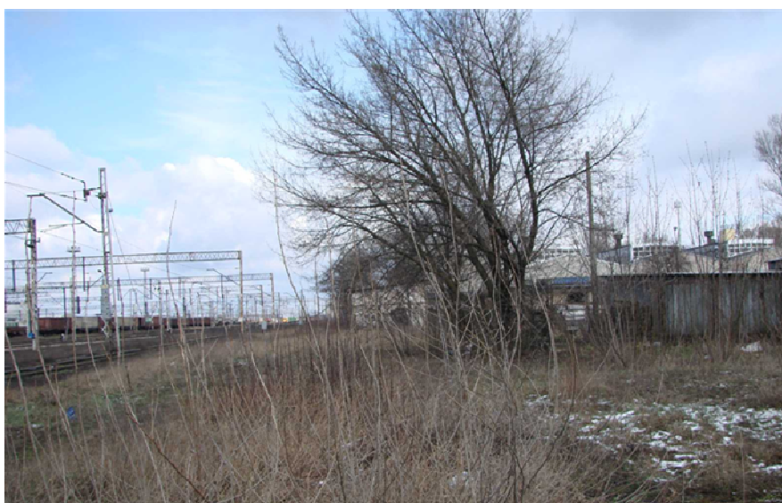
Teren stacji rozrządowej Warszawa-Praga
