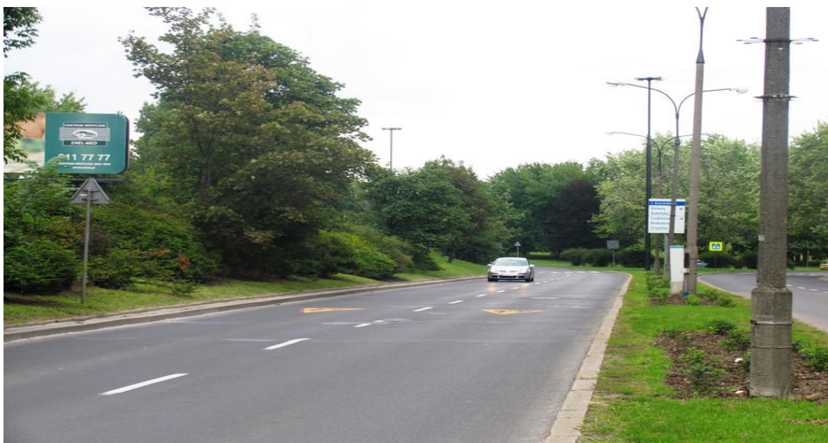
Ulica Krasińskiego - widok od strony Czarnieckiego w kierunku węzła Wisłostrada
