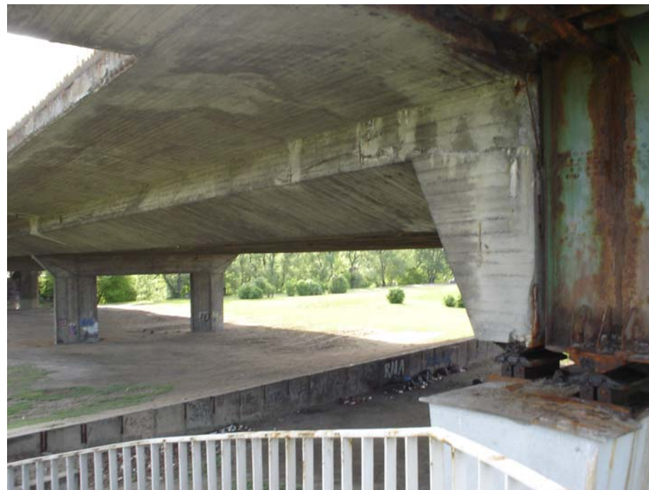
Płyta żelbetowa widok od dołu
