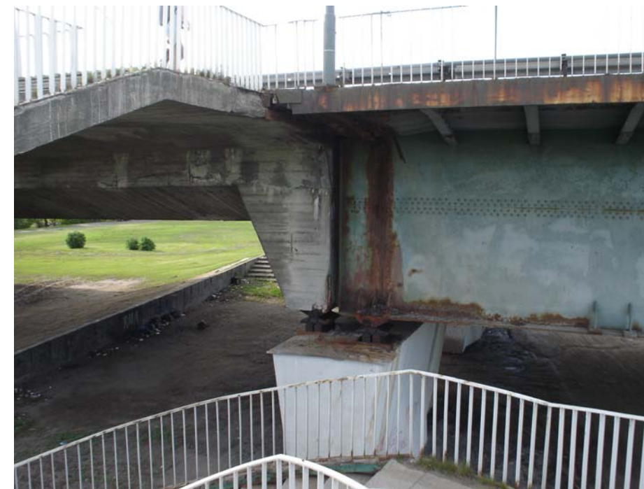
Zetknięcie płyty żelbetowej z płytą stalową, wsparcie dwóch struktur na jednym z głównych filarów
