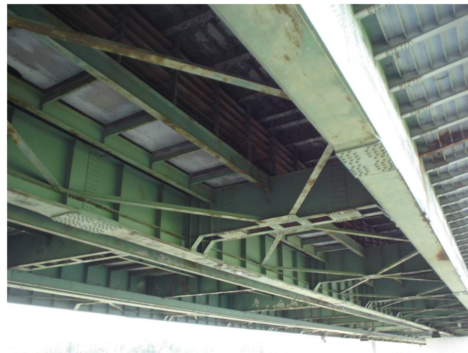
Dźwigary Mostu Łazienkowskiego
