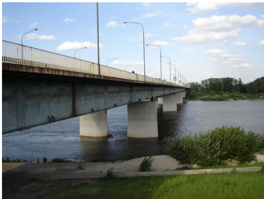
Prześwity Mostu Łazienkowskiego nad Wisłą
