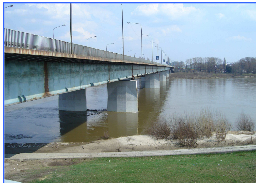
Struktura która przeznaczona jest do modernizacji
