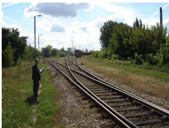
Fot. 5. Rejon przecięcia projektowanej trasy z łącznicą kolejową
