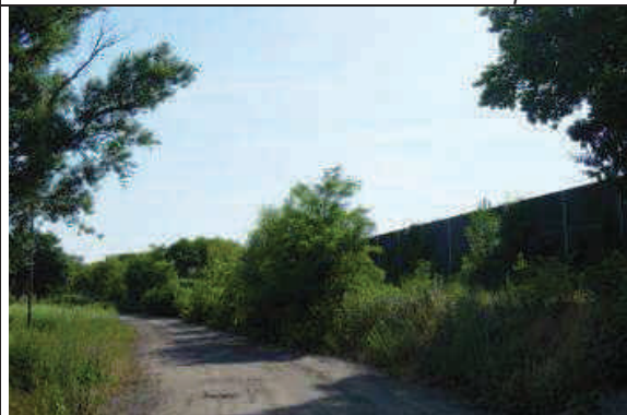
Przykład odbioru drogi z ekranem przeciwdźwiękowym wysokości 4m na nasypie ok. 2m - Krajobraz rolniczo - leśny
