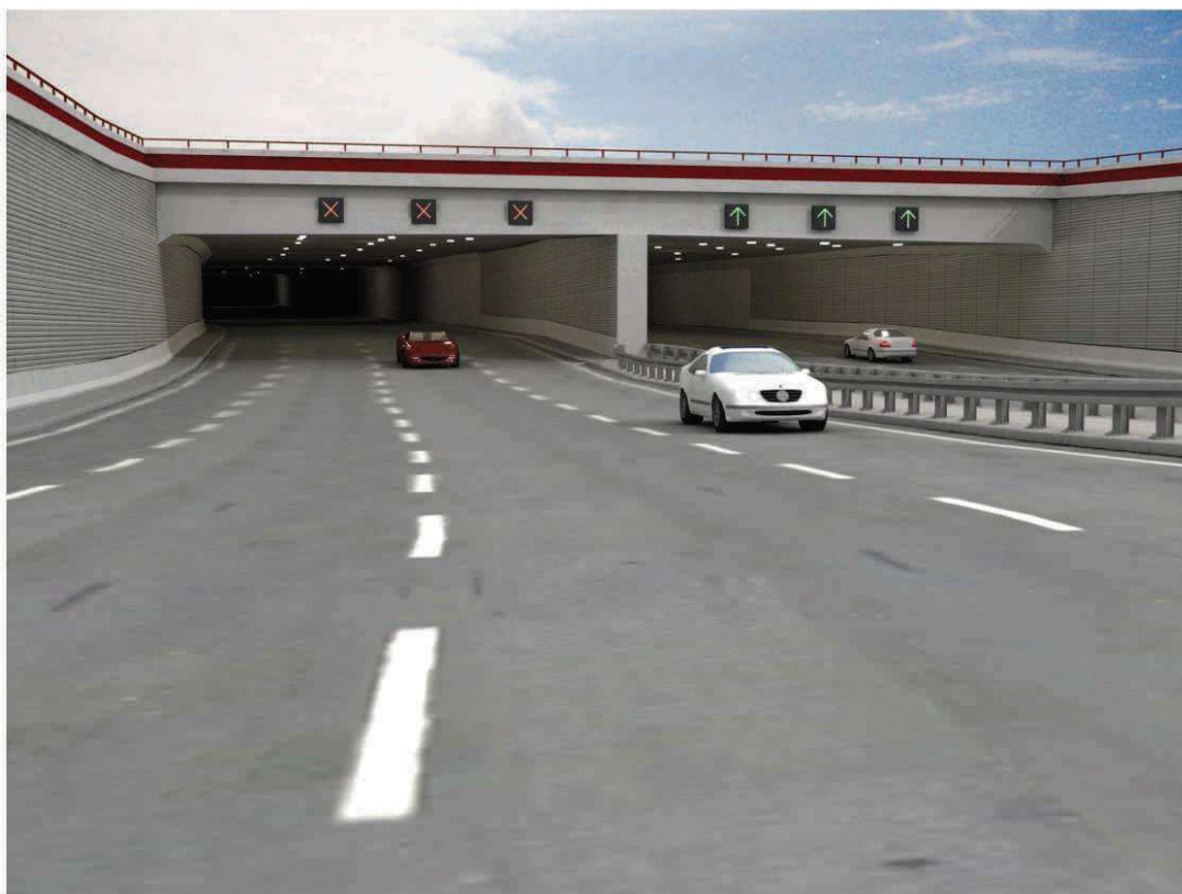
POŁUDNIOWA OBWODNICA WARSZAWY - TUNEL DROGOWY
