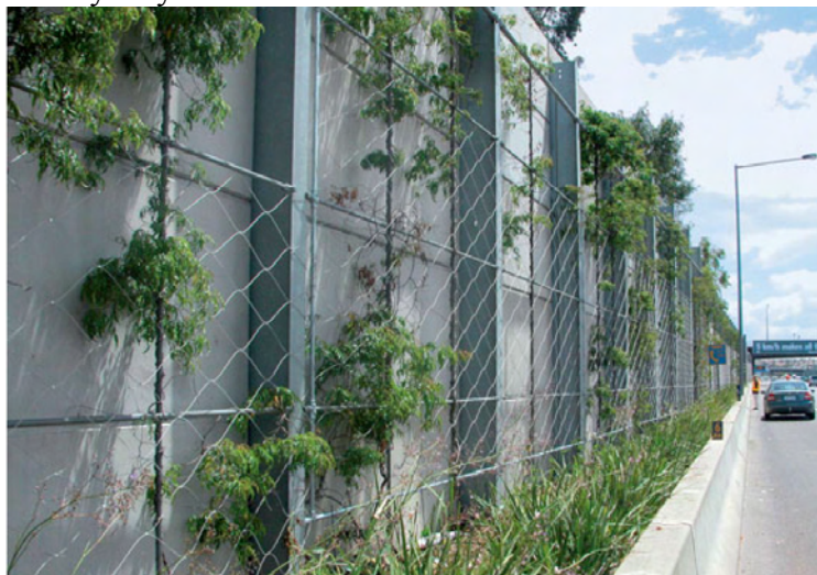
Przykładowe zdjęcie siatki wsporczej dla pnączy przy ekranach.
