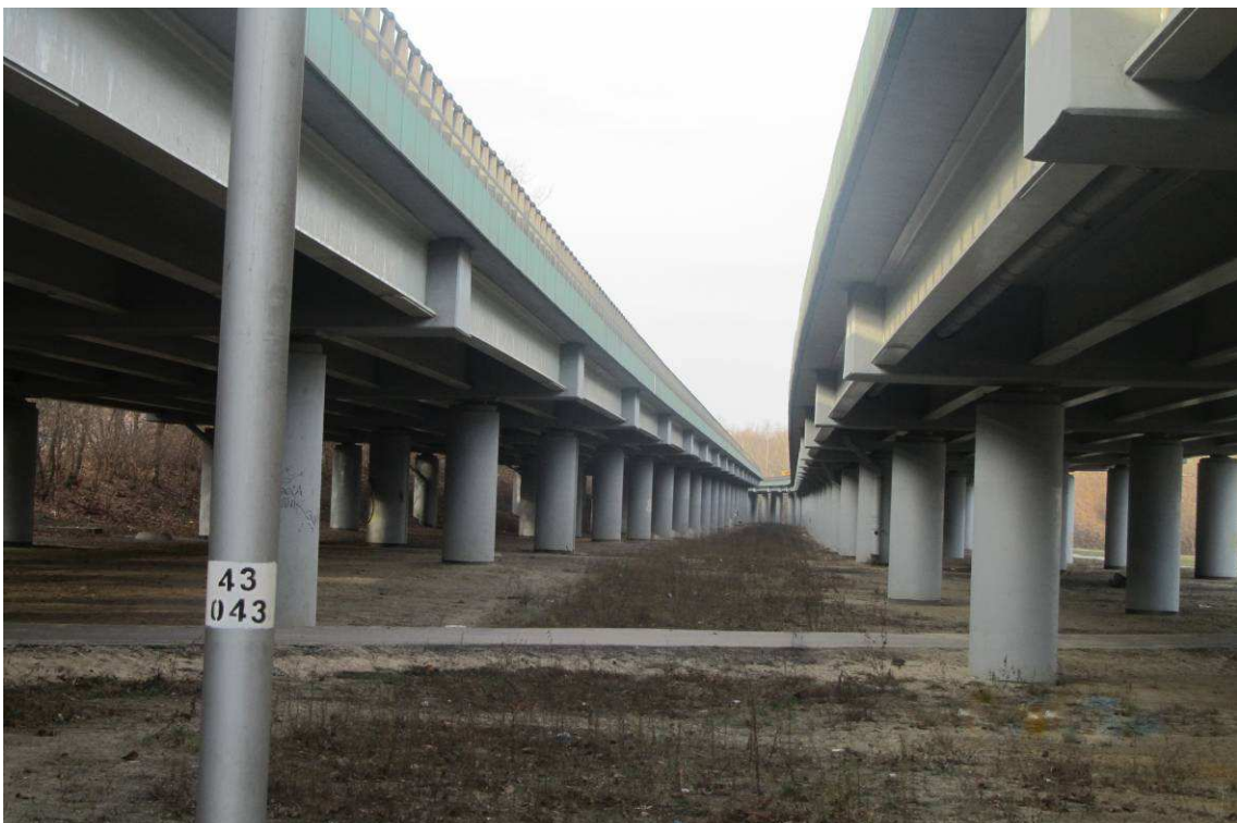
Fotografia 6 Estakada w ciągu Wisłostrady
