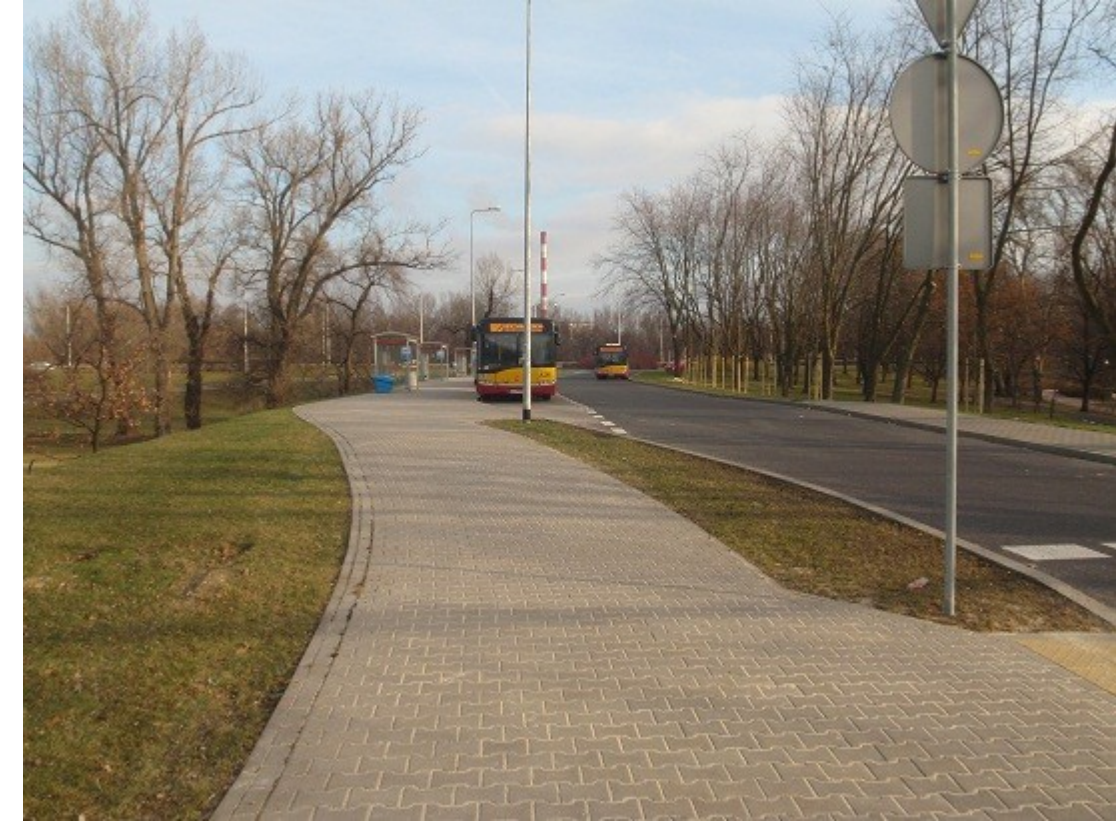
Fot. Przystanek autobusowy (zajezdnia) przy Parku przy Lesie Młocińskim - rejon węzła "Gwiazdzysta"
