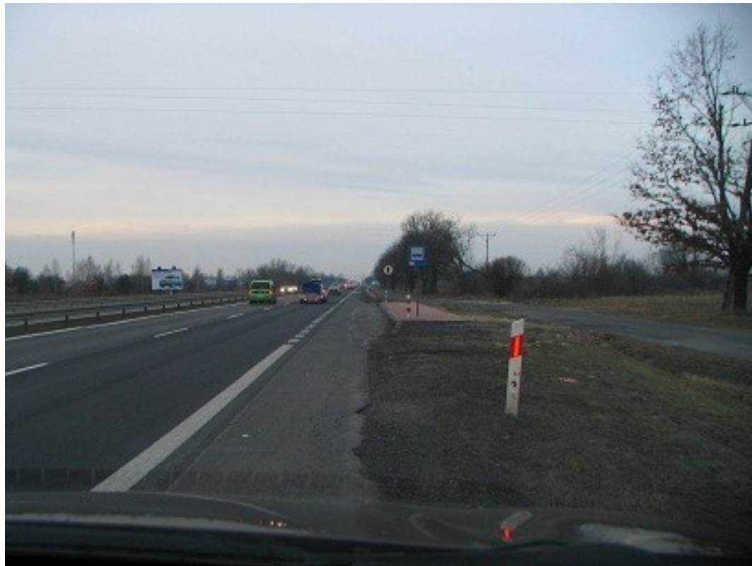
Fot. Przystanek autobusowy przy ulicy Kolejowej (DK7)
