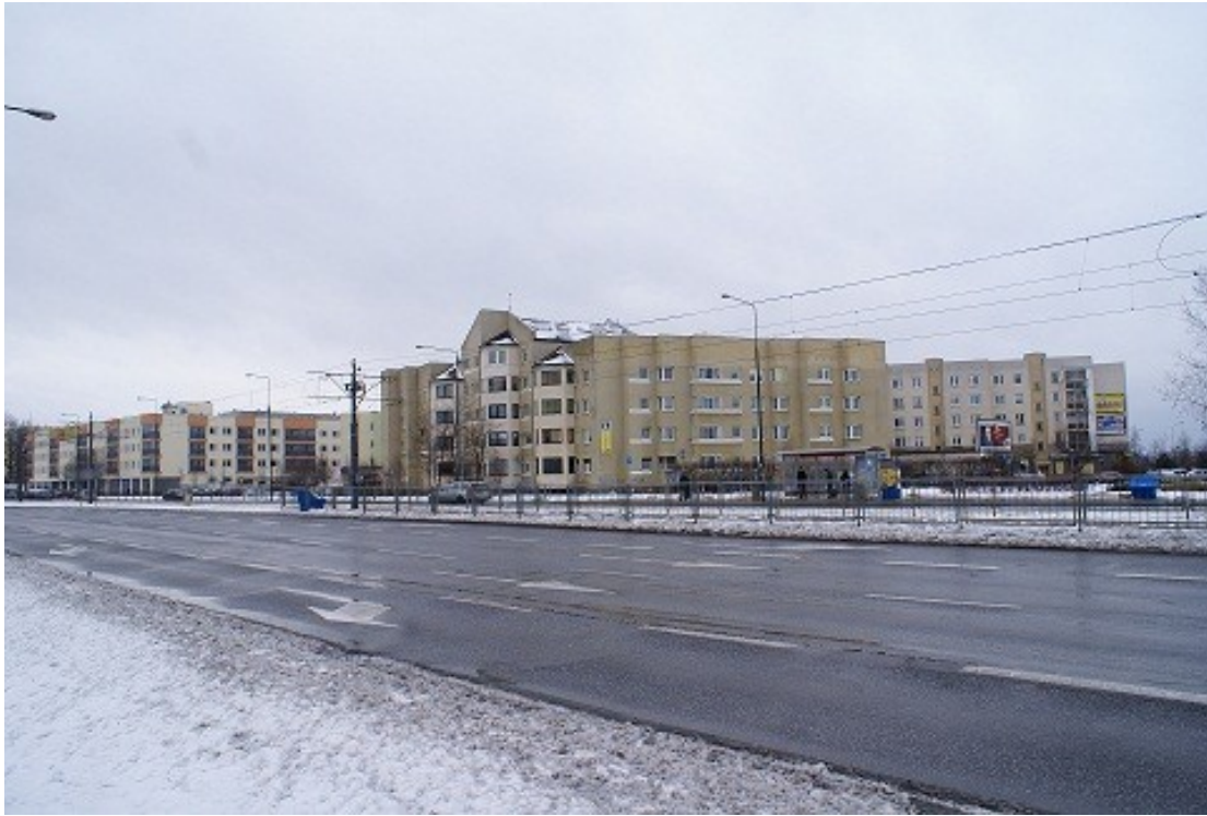
Fot. Zabudowa wielorodzinna przy ulicy Powstańców Śląskich - km 22+550 (widok w kierunku południowo-zachodnim).
