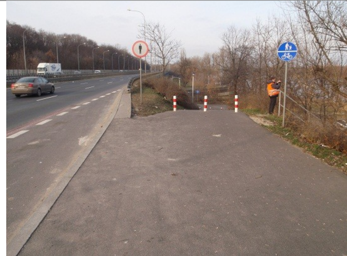
Fot. Widok na dolną terasę zalewową Wisły (strona prawa) oraz Las Bielański (strona lewa) – km 19+250.
