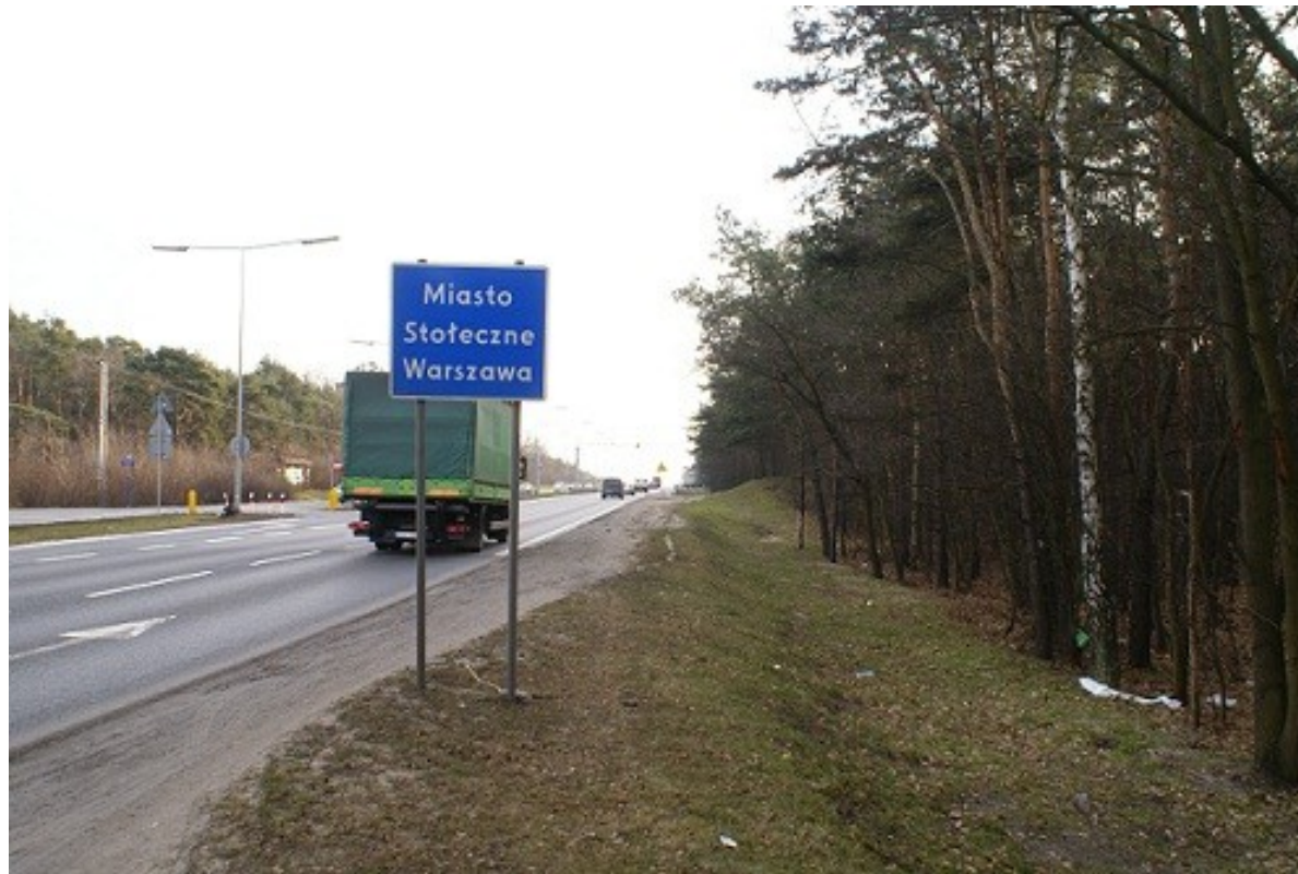
Fot. Przebiega projektowanej trasy przez teren Lasu Młocińskiego – km ok. 14+600 (widok w kierunku Warszawy).
