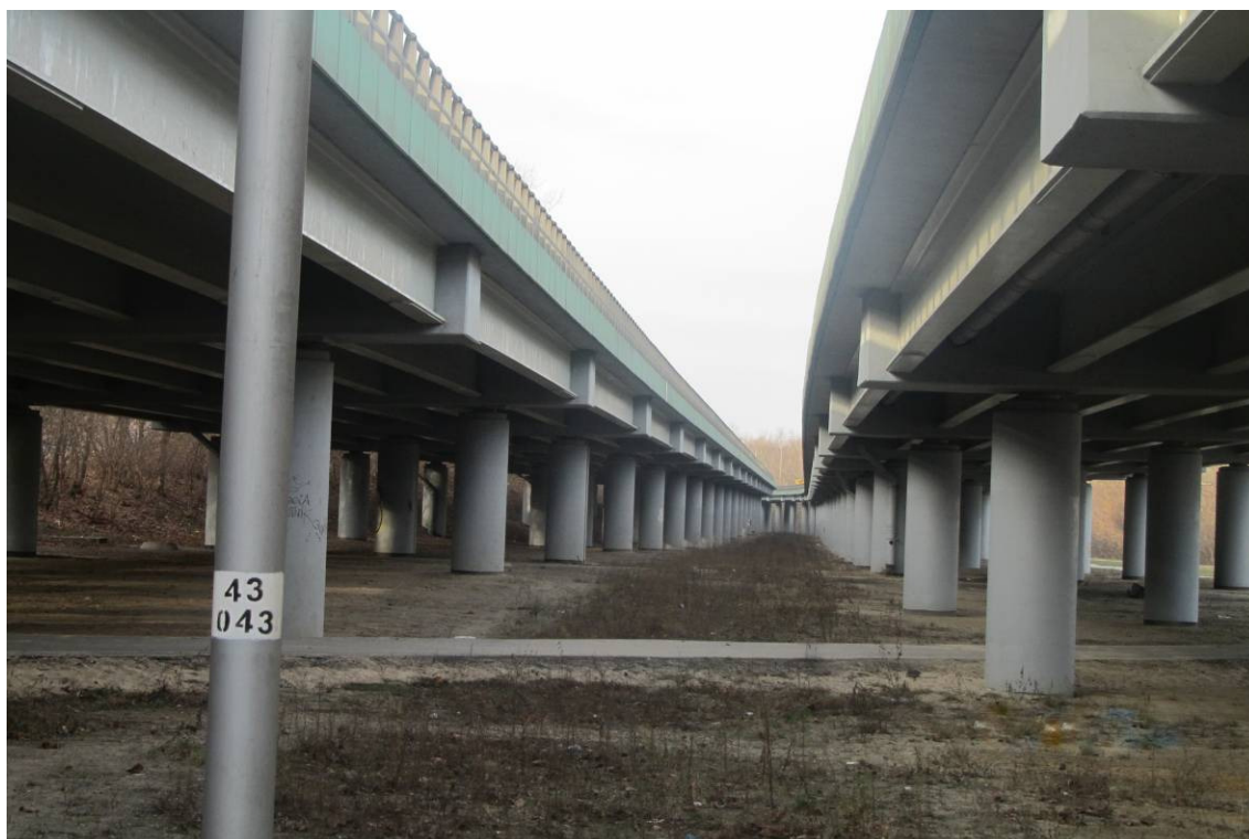
Fotografia 11 Estakada w ciągu Wisłostrady
