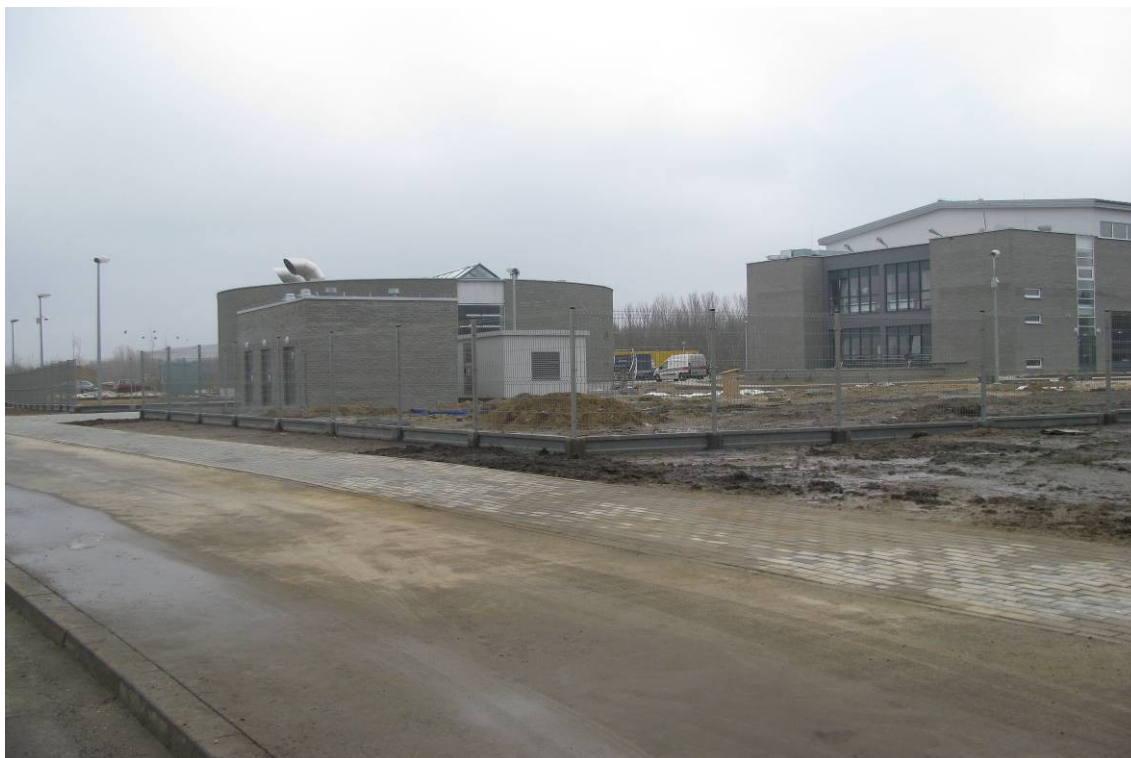
Fotografia 15 Przepompownia oczyszczalni ścieków „Czajka” zlokalizowana na lewym brzegu Wisły w rejonie wariantu I
