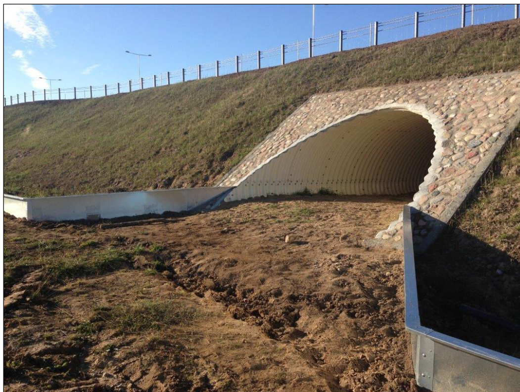
Fot. 10.12 Sposób dowiązania systemu płotków naprowadzających do przejścia dla zwierząt
