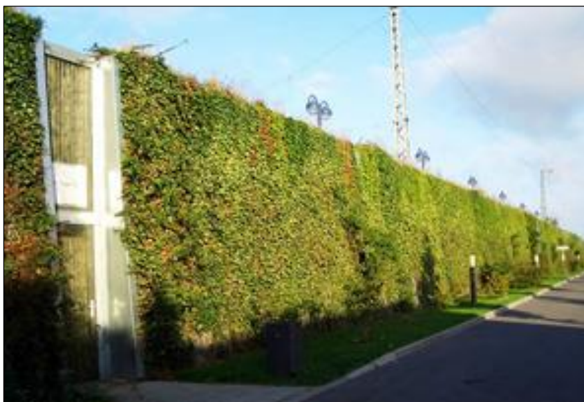
Fot. 10.15 Ekran ziemny obrośnięty pnąciami
