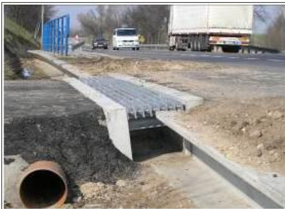
Fot. 10.13 Przykład wykonania „stop-rynny”
