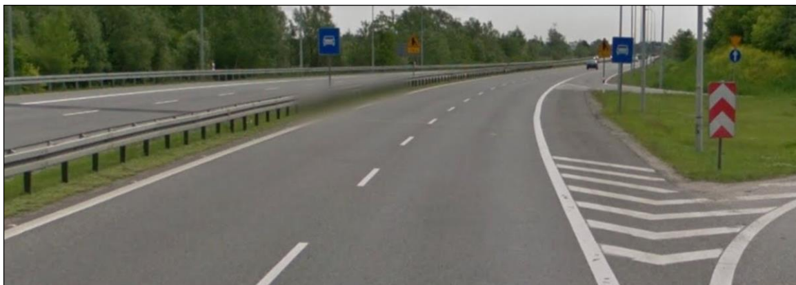
Fot. 2.2 Istniejąca droga krajowa Nr 8 na parametrach S w sąsiedztwie istniejącego węzła Radzymin I
