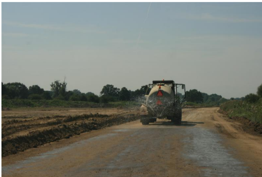
Fot. 7.1 Zraszanie dróg dojazdowych w celu ograniczenia pylenia
