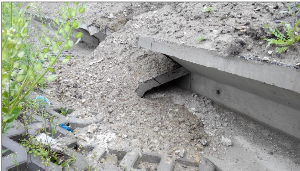
Fot. 4.1 Przykład uszkodzenia płytki betonowej (DW786)
