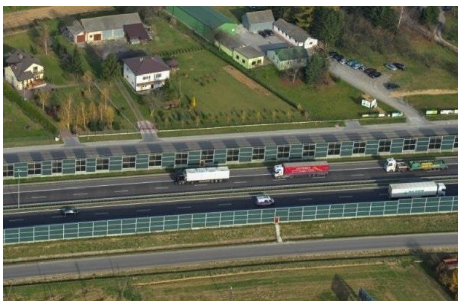
Fot. 8.7 Przykład wykonania ekranów akustycznych przy drodze ekspresowej S17 (obwodnica Lublina) [123]
