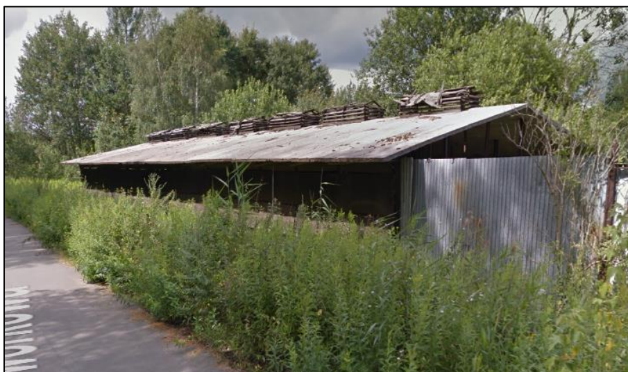
Fot. 8.4 Obiekt do rozbiórki zawierający azbest
