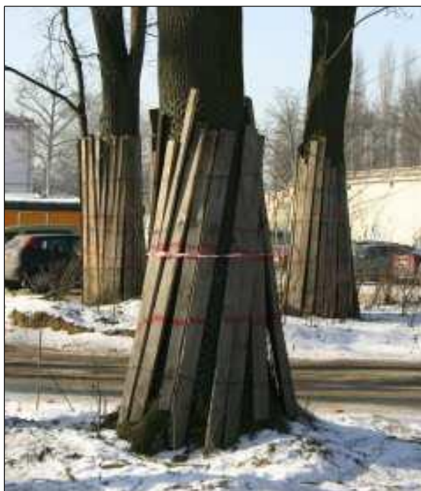
Fot. 9.26 Przykładowy sposób ochrony pnia drzewa przed uszkodzeniami mechanicznymi
