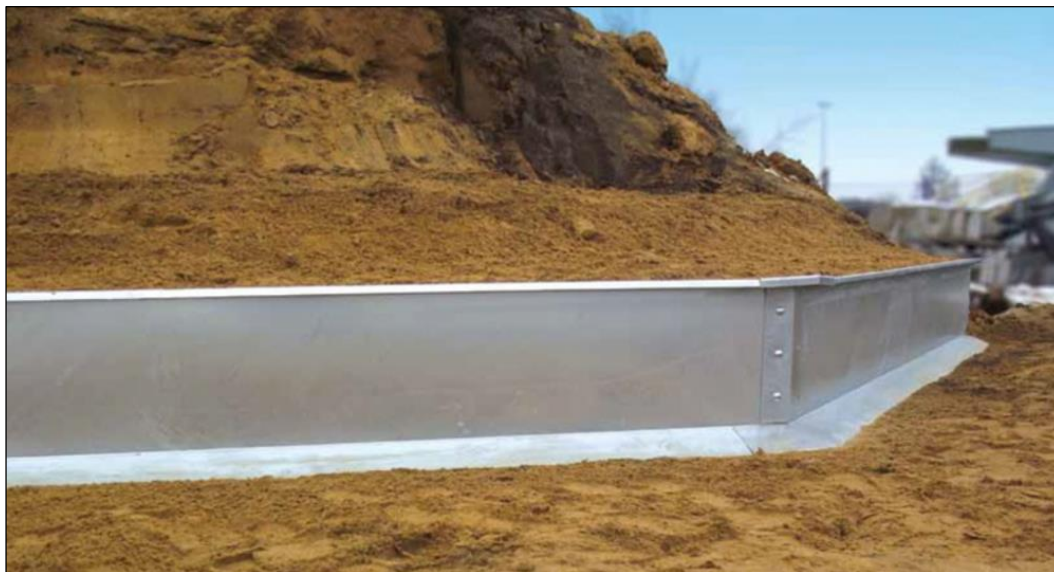
Fot. 10.11 Przykładowe rozwiązania wygradzeń ochronno-naprowadzających dla płazów
