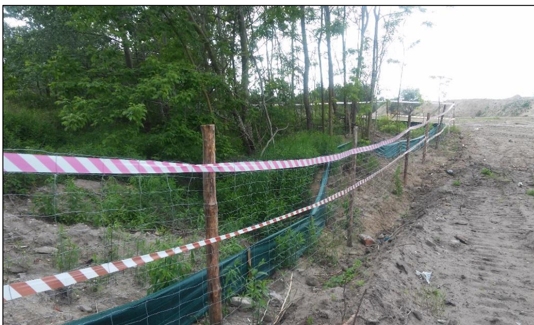
Fot. 9.27 Tymczasowe wygradzenia dla płazów (zastosowane na odcinku A drogi S8) [fot. S. Kuliś]
