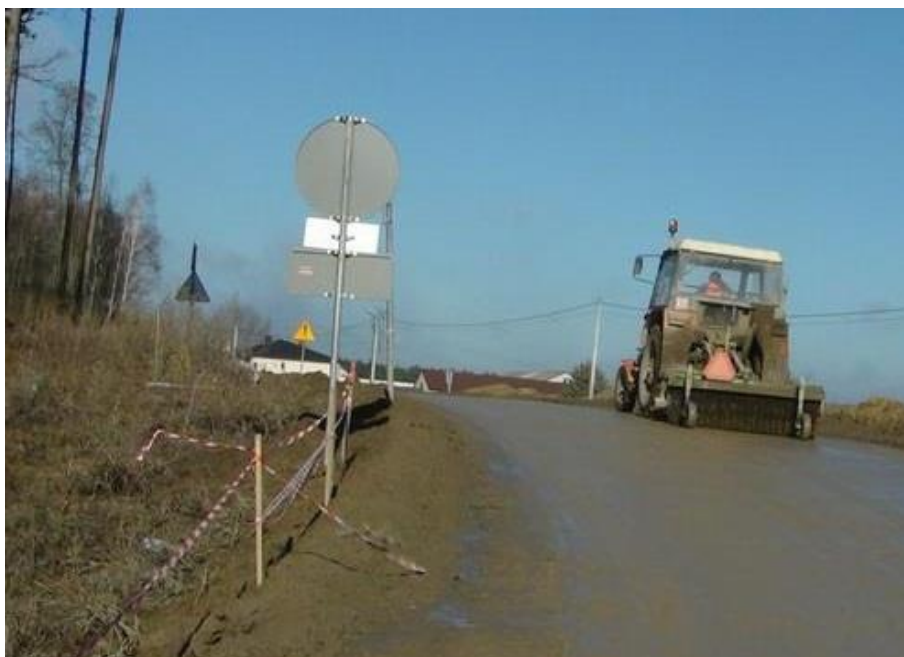
Fot. 7.2 Czyszczenie dróg dojazdowych
