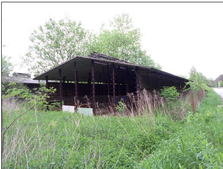
Fot. 8.5 Obiekt do rozbiórki zawierający azbest
