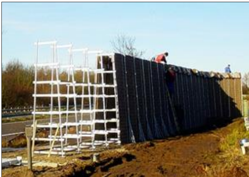
Fot. 10.14 Ekran ziemny w fazie konstrukcyjnej
