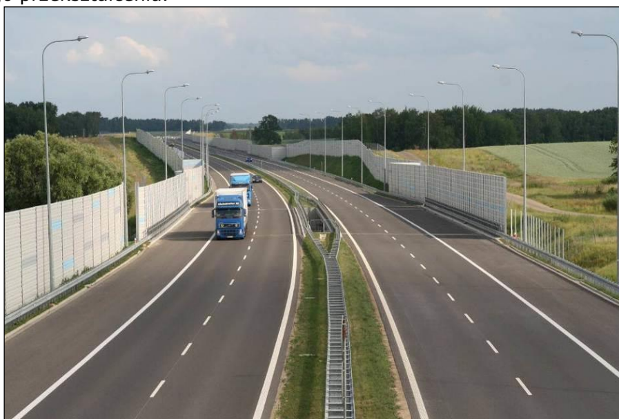
Fot. 8.2 Ekrany akustyczne wzdłuż drogi (droga ekspresowa S3)
