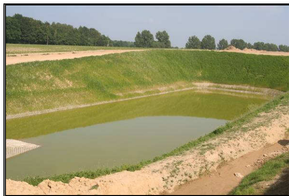
Fot. 11.2 Przykład zbiornika o konstrukcji betonowej z płytami ażurowymi (droga ekspresowa S3)
