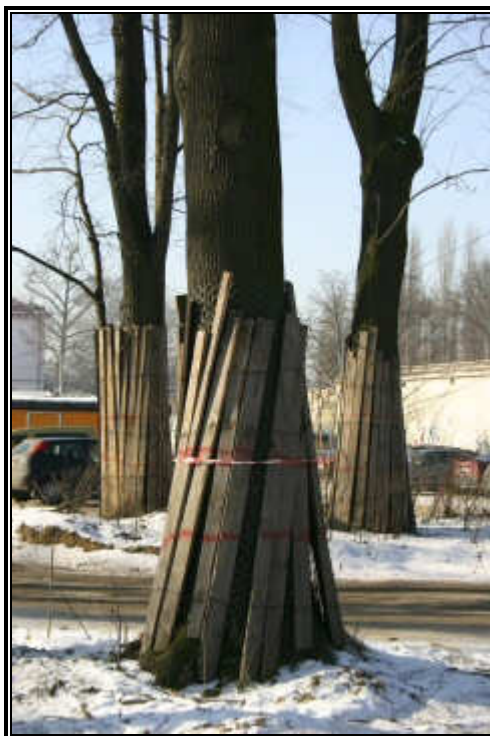
Fot. 11.3 Przykładowy sposób ochrony pnia drzewa przed uszkodzeniem związanym z pracami wykonywanymi w jego pobliżu
