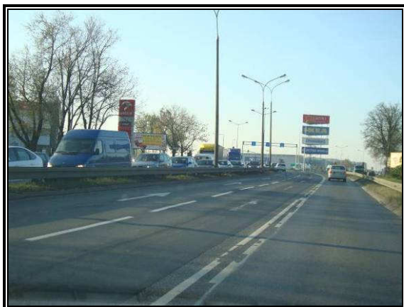
Fot. 4.5 Zagospodarowanie terenu u zbiegu ul. Krakowskiej i ul. Mszczonowskiej
