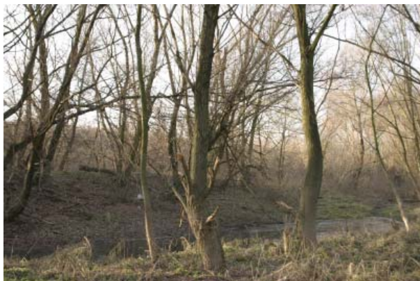
Rys. 46 Skarpa na lewym brzegu Wisły w rejonie Mostu Północnego prawdopodobnie wymagająca umocnienia
