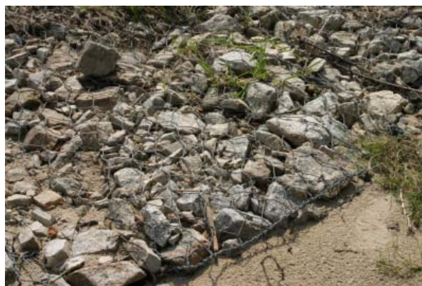
Rys. 45 „Worki” z siatki stalowej o wielkich oczkach
