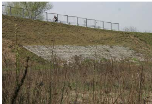
Rys. 47 Wykorzystanie krat betonowych do umocnienia wałów w rejonie Mostu Świętokrzyskiego.
