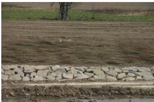
Rys. 44 Umocnienie brzegów rzeki w postaci materiałów naturalnych jak kamienie i faszyna
