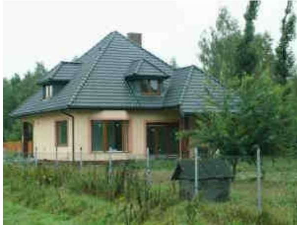
Fot. 11.4. Budynek mieszkalny numer 126
