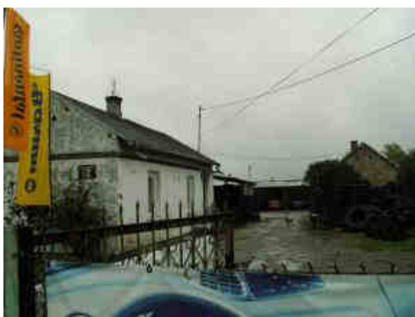
Fot. 11.3. Budynek mieszkalny numer 130
