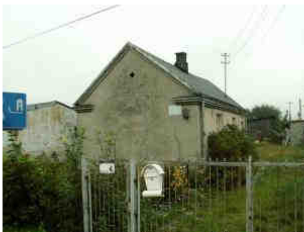
Fot. 11.1. Budynek mieszkalny numer 128
