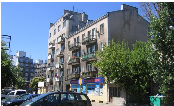
Fot. 49. Widok na budynek przy ul. Mackiewicza 3/5
