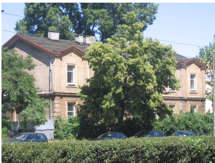
Fot. 53. Widok na budynek przy ul. Kijowskiej 7
