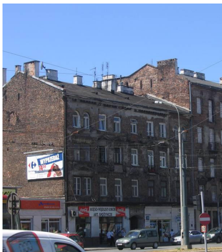
Fot. 43. Widok na budynek przy ul. Targowej 19
