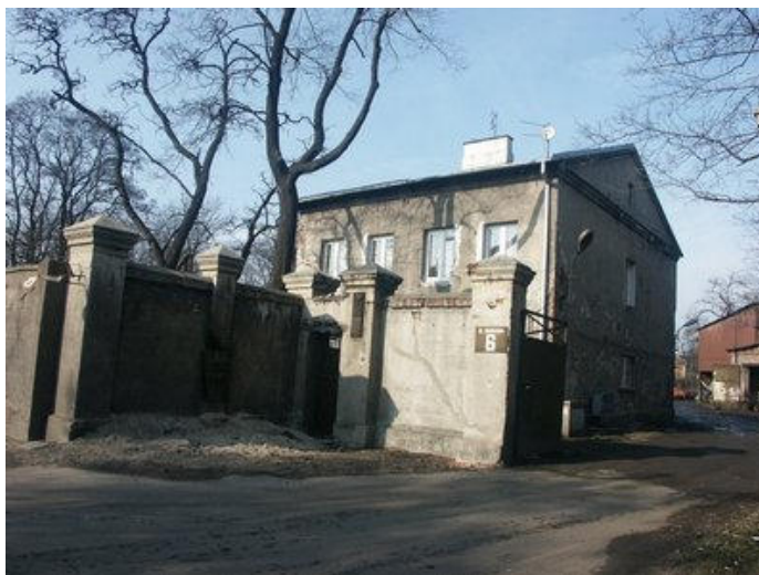
Fot. 60, 61. Widok na budynek przy ul. Siarczanej 6
