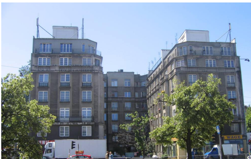
Fot. 42. Widok na budynek przy ul. Targowej 15
