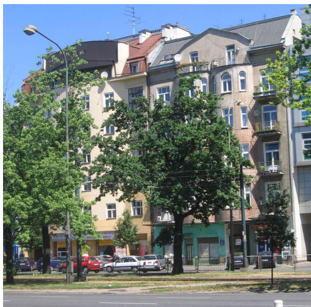
Fot. 47. Widok na budynek przy ul. Targowej 32
