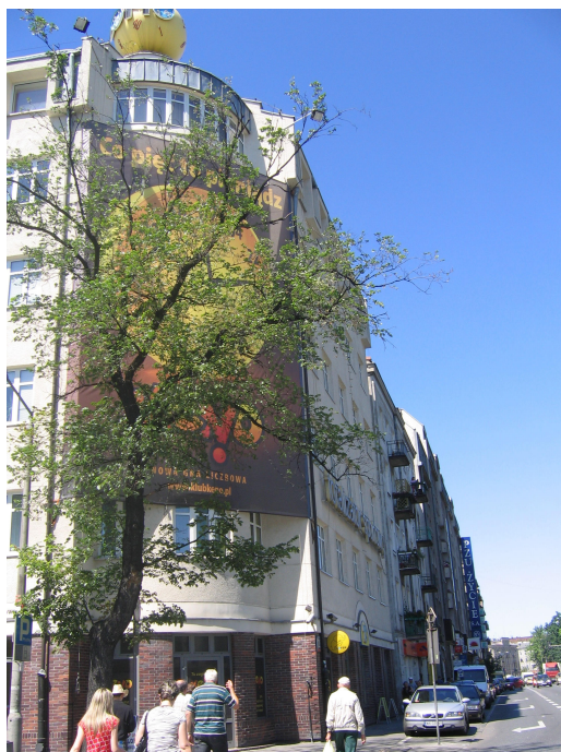
Fot. 46. Widok na budynek przy ul. Targowej 25
