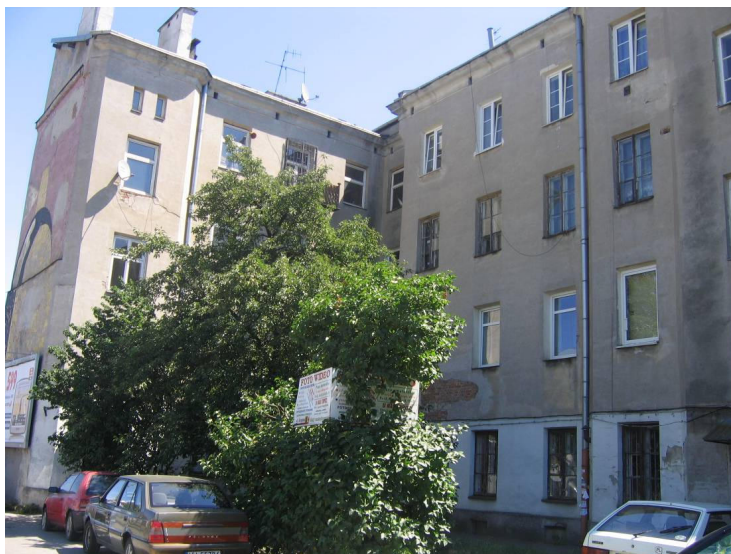
Fot. 45. Widok na budynek przy ul. Targowej 22
