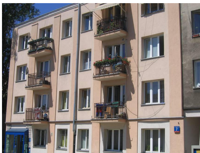
Fot. 50. Widok na budynek przy ul. Mackiewicza 7
