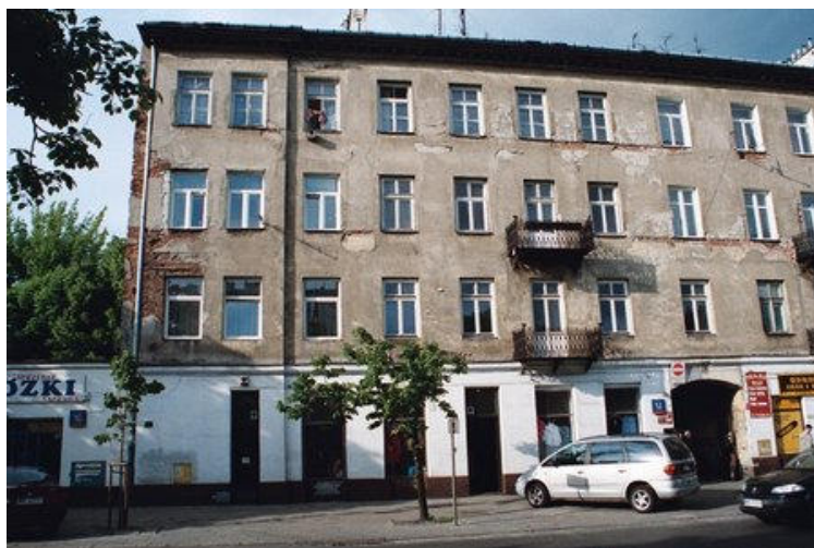
Fot. 41. Widok na budynek przy ul. Targowej 14
