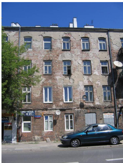
Fot. 35, 36. Widok na budynek przy ul. Zamoyskiego 25
