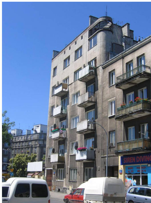
Fot. 48. Widok na budynek przy ul. Mackiewicza 1
