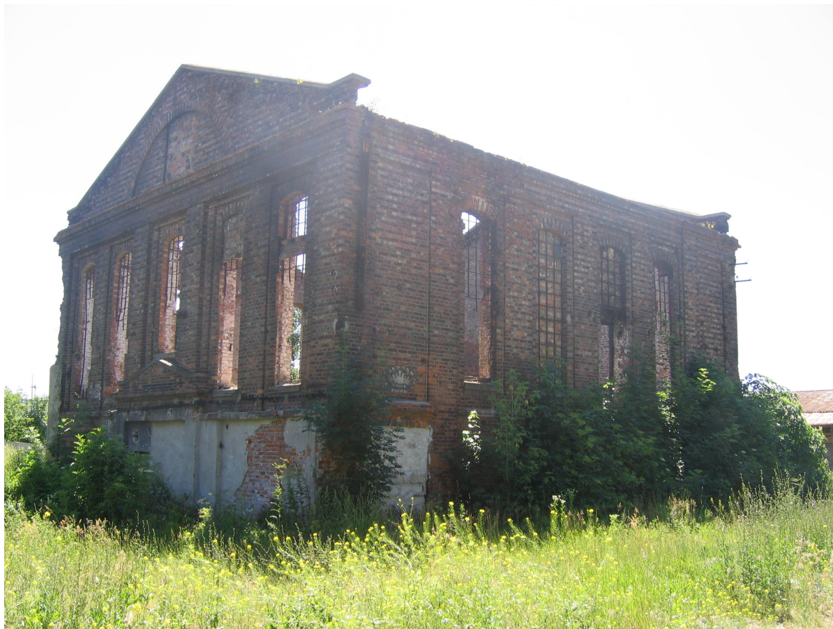
Obiekt przy ul. Objazdowej 2 – magazyn przeznaczony do rozbiórki
