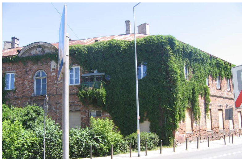
Fot. 39, 40. Widok na budynek przy ul. Zamoyskiego 15
