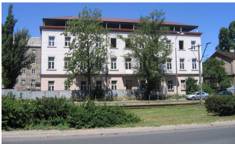
Fot. 52. Widok na budynek przy ul. Kijowskiej 5
