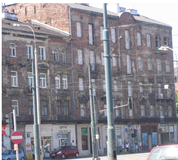
Fot. 44. Widok na budynek przy ul. Targowej 21
