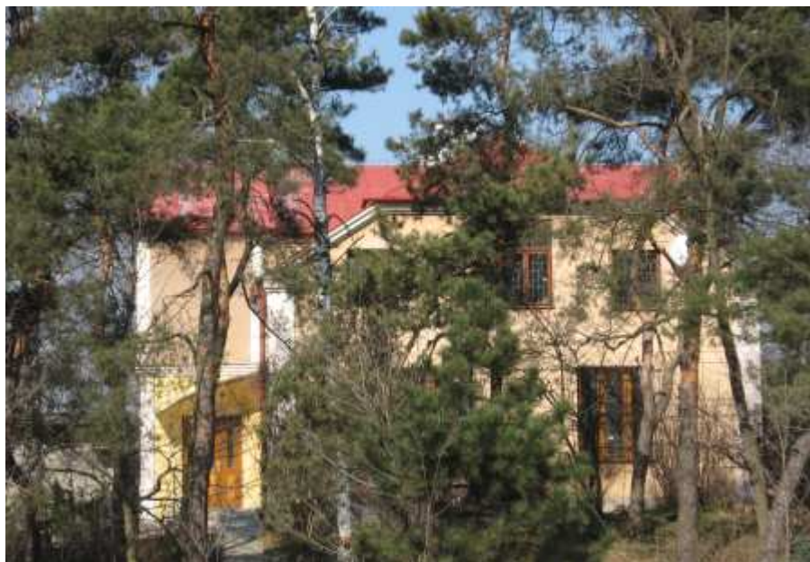
Fot. 4 Budynek przy ul. Marsa 61
