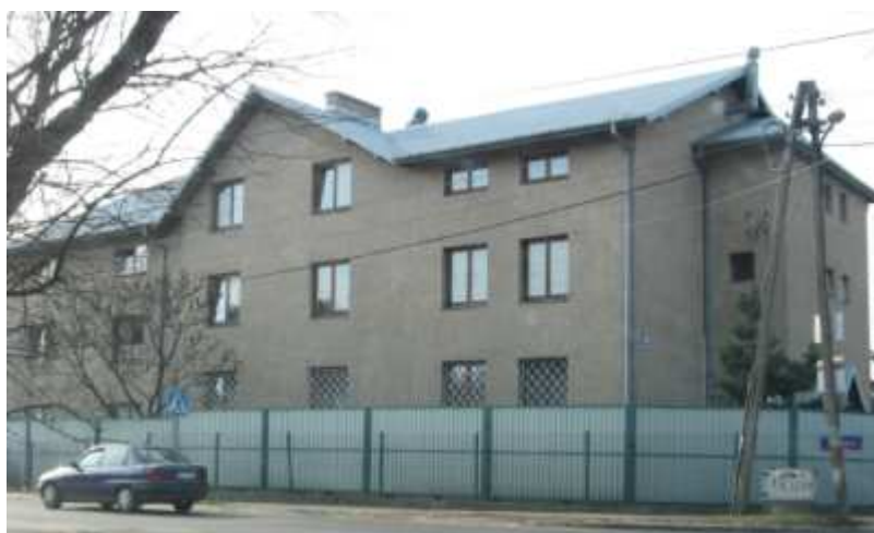
Fot. 13 Budynek przedszkola przy ul. Tytoniowej, na odcinku ul. Marsa
