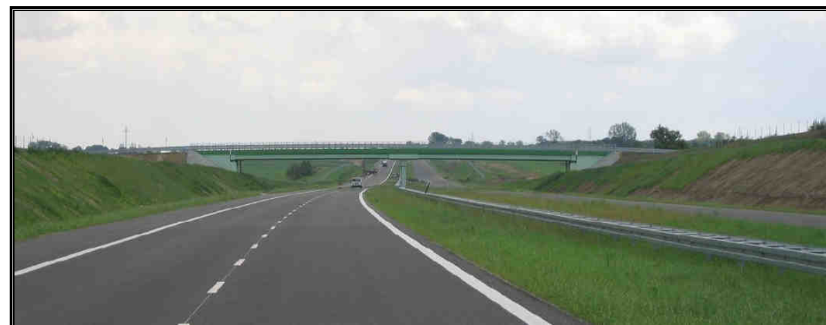
Fot. 4.7 Droga poprowadzona w wykopie jest niewidoczna z terenów sąsiadujących z nią. Takie rozwiązanie pozwala też znacznie obniżyć nasypy dojazdu do przejazdu nad drogą
