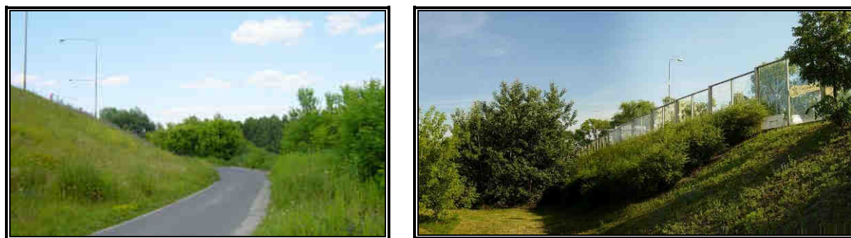
Fot. 4.8 Przykład odbioru drogi poprowadzonej na nasypie ok. 6m. U podnóża rosną krzewy i drzewa
