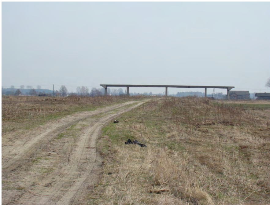
Fot. 1 Fragment pasa drogowego w rejonie Nowej Wsi - na drugim planie nieukończony wiadukt drogowy
