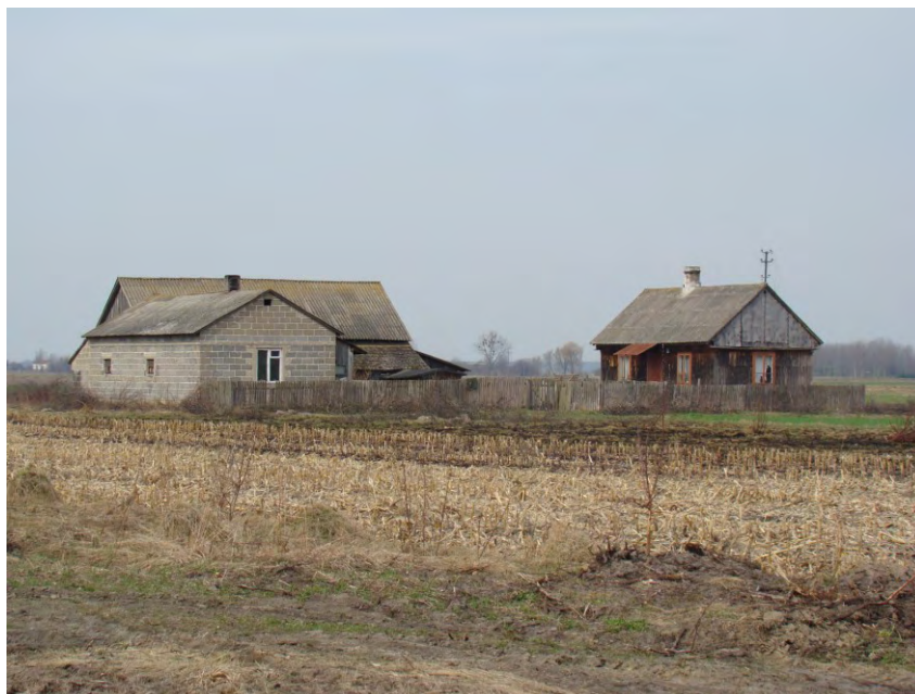
Fot. 5 Zabudowa siedliskowa w rejonie Nowej Wsi – marzec 2010 r.
