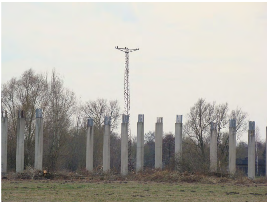
Fot.3 Podpory estakadowe nad niezrealizowaną magistralą węglową – realizacja lata siedemdziesiąte ubiegłego stulecia
