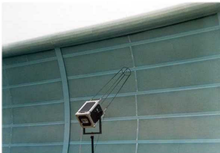
Rys. HAŁAS nr 3 – ekran z dyfraktorem
