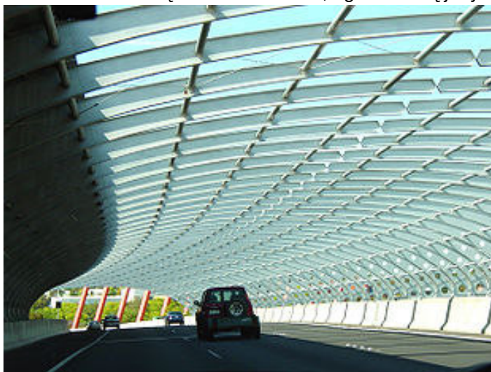
Rys. HAŁAS nr 2 – ekran tunelowy
