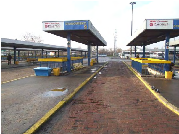
fot. 2 – Stanowiska odjazdowe od długości umożliwiającej obsługę dwóch autobusów przy jednej platformie
