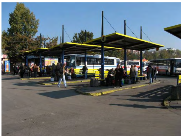
fot. 8 – Platformy przystankowe na dworcu
