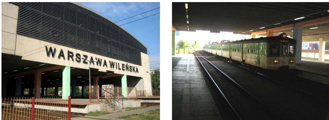
Fot: 6: Kolejowy Dworzec Warszawa - Wileńska (fot. z września 2008 r.)
