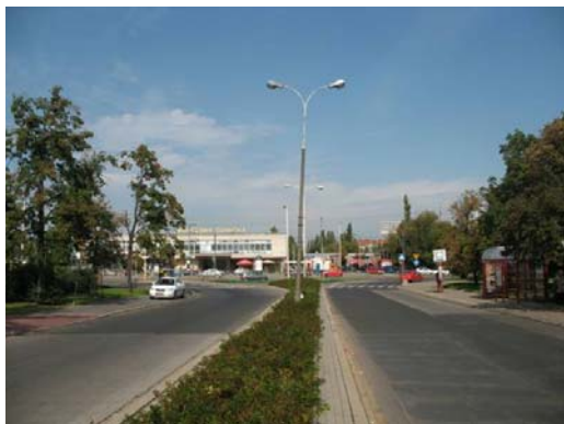
Fot. 3. Ul. Dawidowskiego – widok przekroju przed skrzyżowaniem z ul. Słomińskiego.
