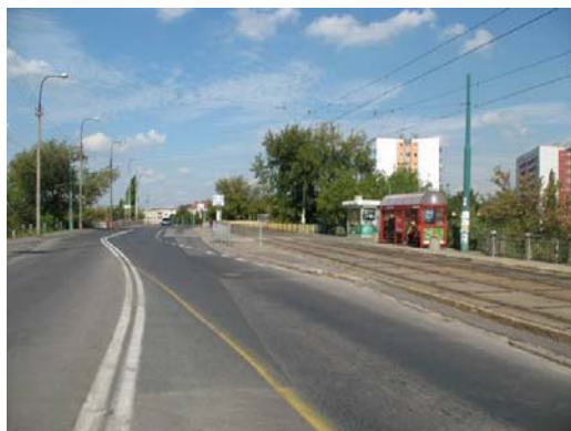
Fot. 5. Ul. Gen. W. Andersa – widok przekroju na wysokości wiaduktu nad ul. Słomińskiego.
