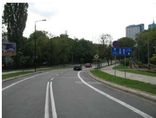
Fot. 9. Ul. Międzyparkowa – widok przekroju za skrzyżowaniem z ul. Słomińskiego.
