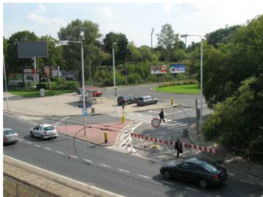
Fot. 7. Ul. Bonifraterska – widok na skrzyżowanie z ul. Słomińskiego.
