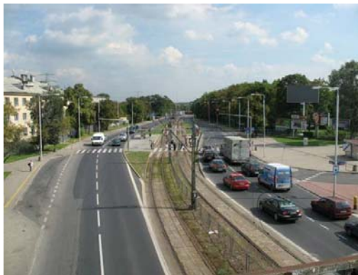
Fot. 2. Ul. Słomińskiego – widok na wschód od ul. Gen. W. Andersa.
