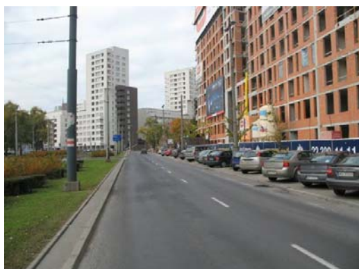
Fot. 13. Ul. Stawki – widok północnej jezdni w stronę skrzyżowania z ul. Pokorną.
