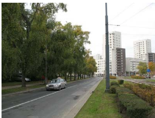
Fot. 14. Ul. Stawki – widok południowej jezdni w stronę skrzyżowania z ul. Pokorną.
