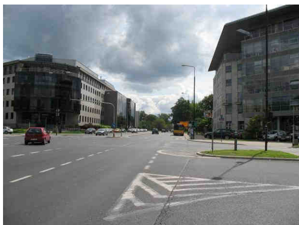
Fot. 53. Ul. Powązkowska, w rejonie skrzyżowania z ul. Krasińskiego.
