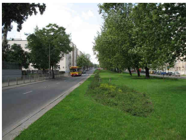
Fot. 5. Południowa jezdnia ul. Krasińskiego, odcinek między pl. Wilsona a ul. Hozjusza. Widoczny szeroki pas zieleni i barierka uniemożliwiająca parkowanie.
