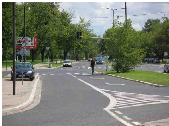
Fot. 35. Skrzyżowanie ul. Krasińskiego z ul. Powązkowską. Widok na wschodni wlot i zachodni wylot ul. Krasińskiego.
