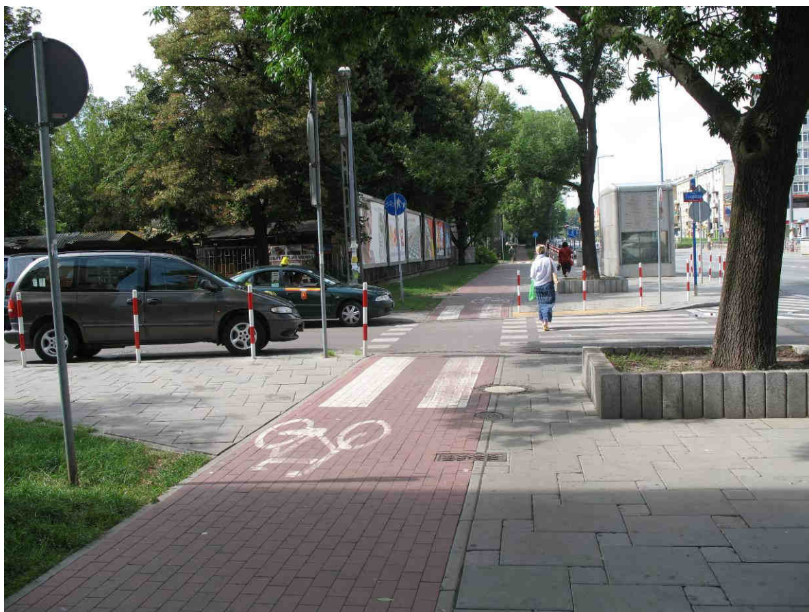
Fot. 67. Ścieżka rowerowa po południowej stronie ul. Krasińskiego, widok od strony pl. Wilsona
