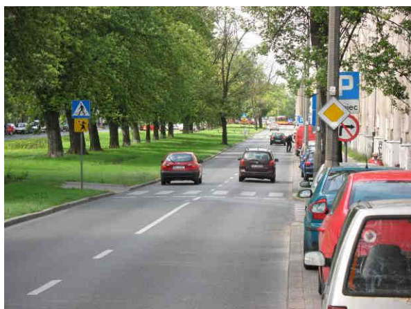
Fot. 3. Północna jezdnia ul. Krasińskiego, na odcinku między pl. Wilsona a ul. Popiełuszki. Widoczne parkowanie równoległe wzdłuż krawędzi z pojedynczymi drzewami pomiędzy miejscami do parkowania.
