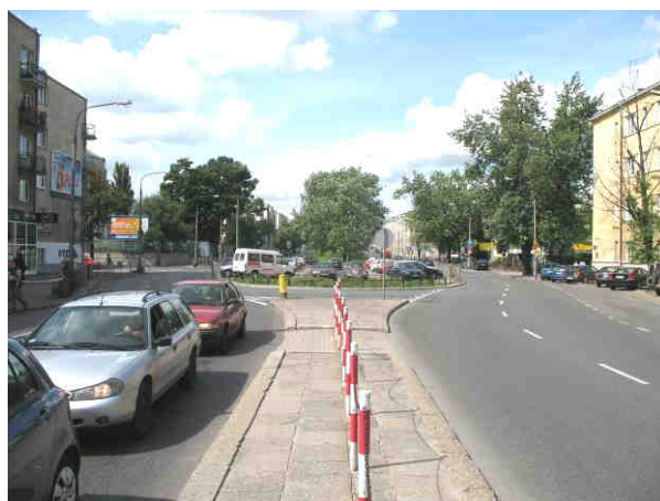
Fot. 4. Północna i południowa jezdnia ul. Krasińskiego w pobliżu pl. Wilsona. Po stronie północnej na początkowym odcinku między pl. Wilsona a ul. Popiełuszki występuje parkowanie prostopadłe.
