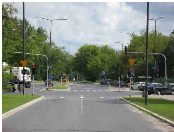
Fot. 36. Skrzyżowanie ul. Krasińskiego z ul. Powązkowską. Widok na wschodni wylot i zachodni wlot ul. Krasińskiego.
