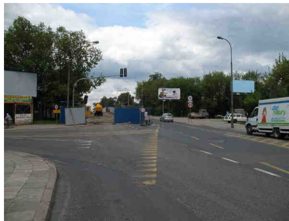
Fot. 56. Ul. Powązkowska, widok na prace budowlane, które są obecnie prowadzone w związku z modernizacją wiaduktu nad torami kolejowymi.
