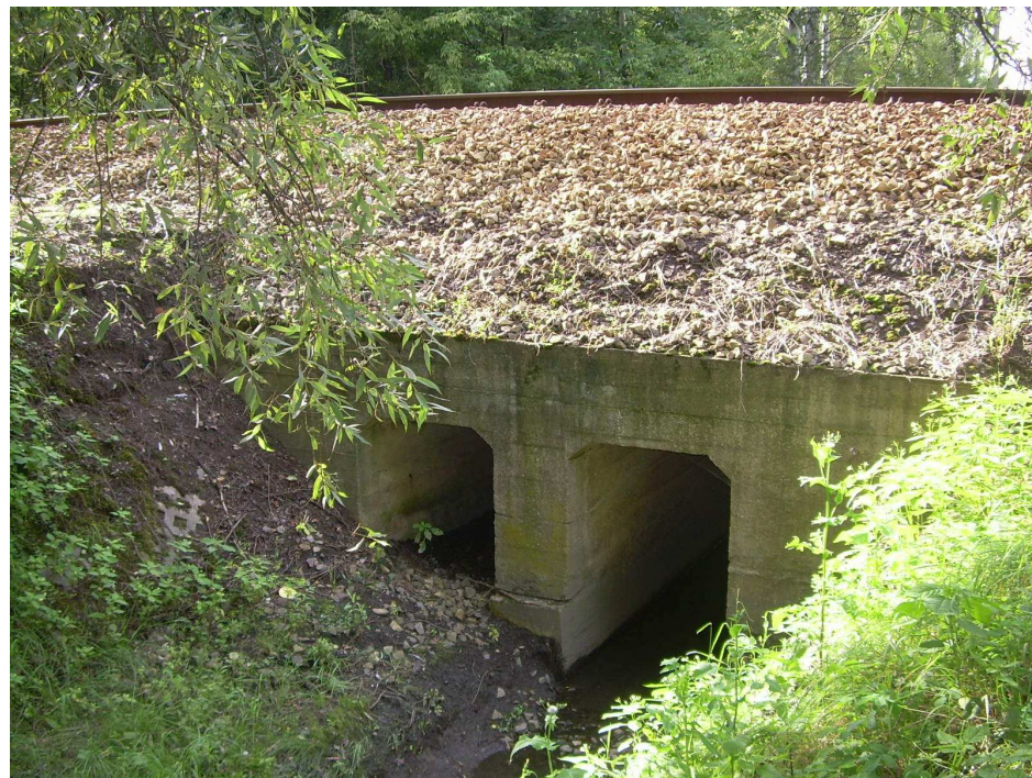
Fotografia 5 - 10 Przepust w km 20+085 na linii 6
