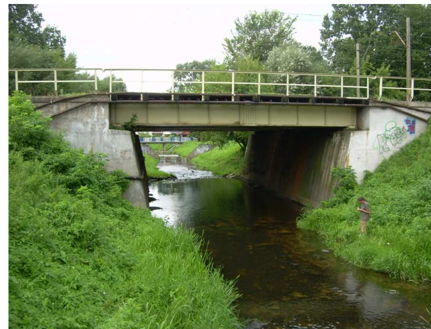
Fotografia 5 - 8 Most na rz. Długiej, km 14+896 linia nr 6
