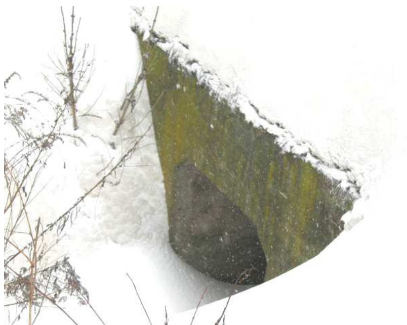
Fotografia 5 - 4 Przepust w km 18+950 linia nr 6
