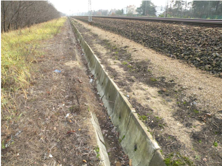
Fotografia 5 - 6 „Korytka krakowskie” budowane w ubiegłych latach w celu odwodnienia torowiska – pułapka dla płazów
