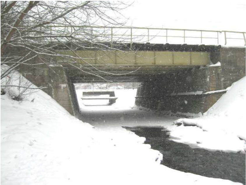
Fotografia 5 - 3 Most w km 14+896 linia nr 6
