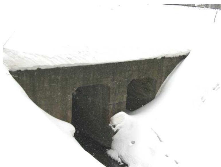
Fotografia 5 - 5 Przepust w km 20+085 linia nr 6
