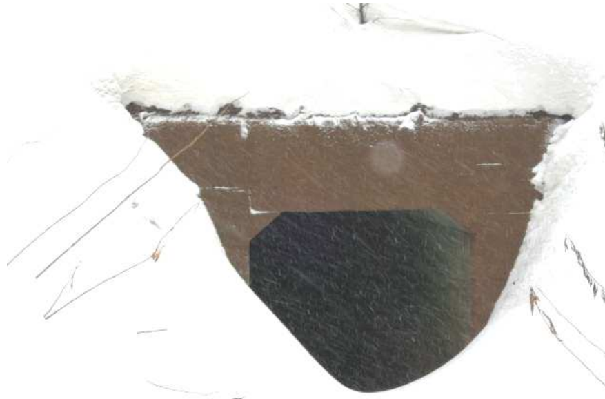
Fotografia 5 - 9 Przepust w km 18+950 na linii 6
