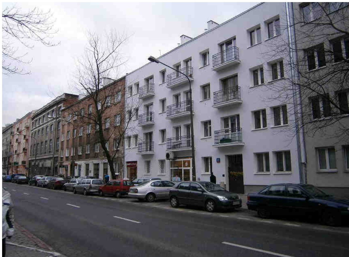
Fot.15 ODCINEK ZACHODNI - ul. Płocka 37 - bez numeru rejestru.
