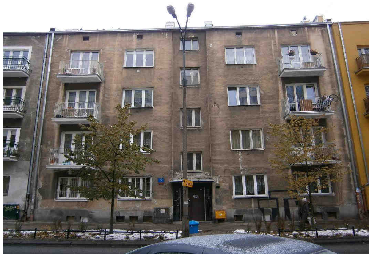
Fot.25 ODCINEK ZACHODNI - ul. Płocka 7 - bez numeru rejestru.
