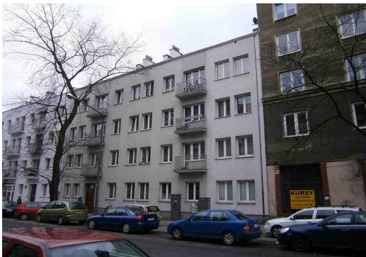
Fot.14 ODCINEK ZACHODNI - ul. Płocka 37a - bez numeru rejestru.
