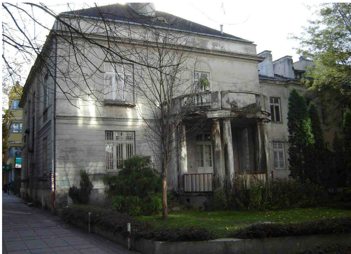
Fot.23 ODCINEK ZACHODNI - ul. Płocka 11 – nr rej. 1419 z dn. 17.04.1990r.
