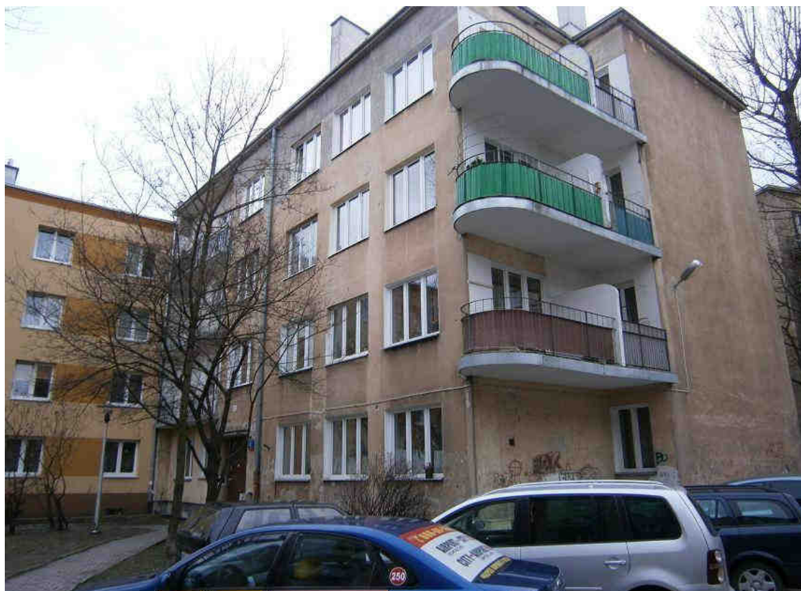
Fot.13 ODCINEK ZACHODNI - ul. Rabsztyńska 4 - bez numeru rejestru.
