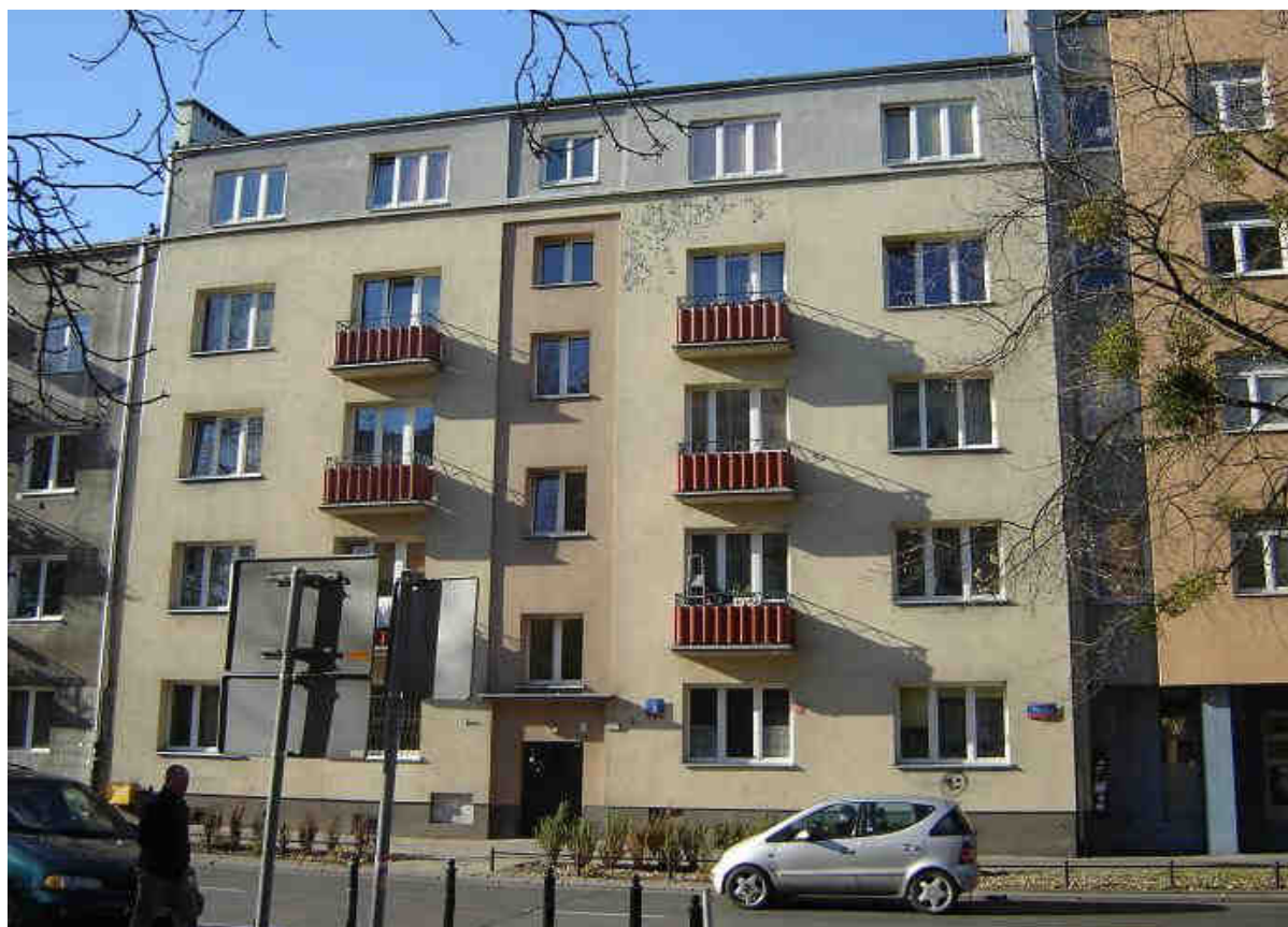
Fot.27 ODCINEK ZACHODNI - ul. Płocka 5 - bez numeru rejestru.
