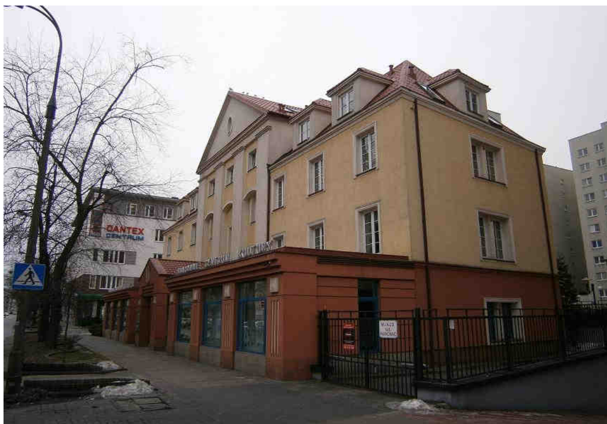
Fot.22 ODCINEK ZACHODNI - ul. Płocka 13 - bez numeru rejestru.
