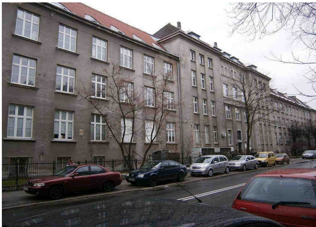
Fot.19 ODCINEK ZACHODNI - ul. Płocka 26 - bez numeru rejestru.
