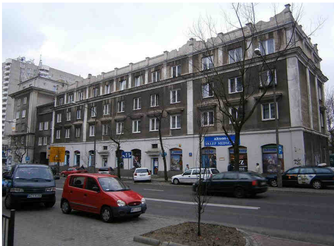
Fot.21 ODCINEK ZACHODNI - ul. Płocka 21 - bez numeru rejestru.
