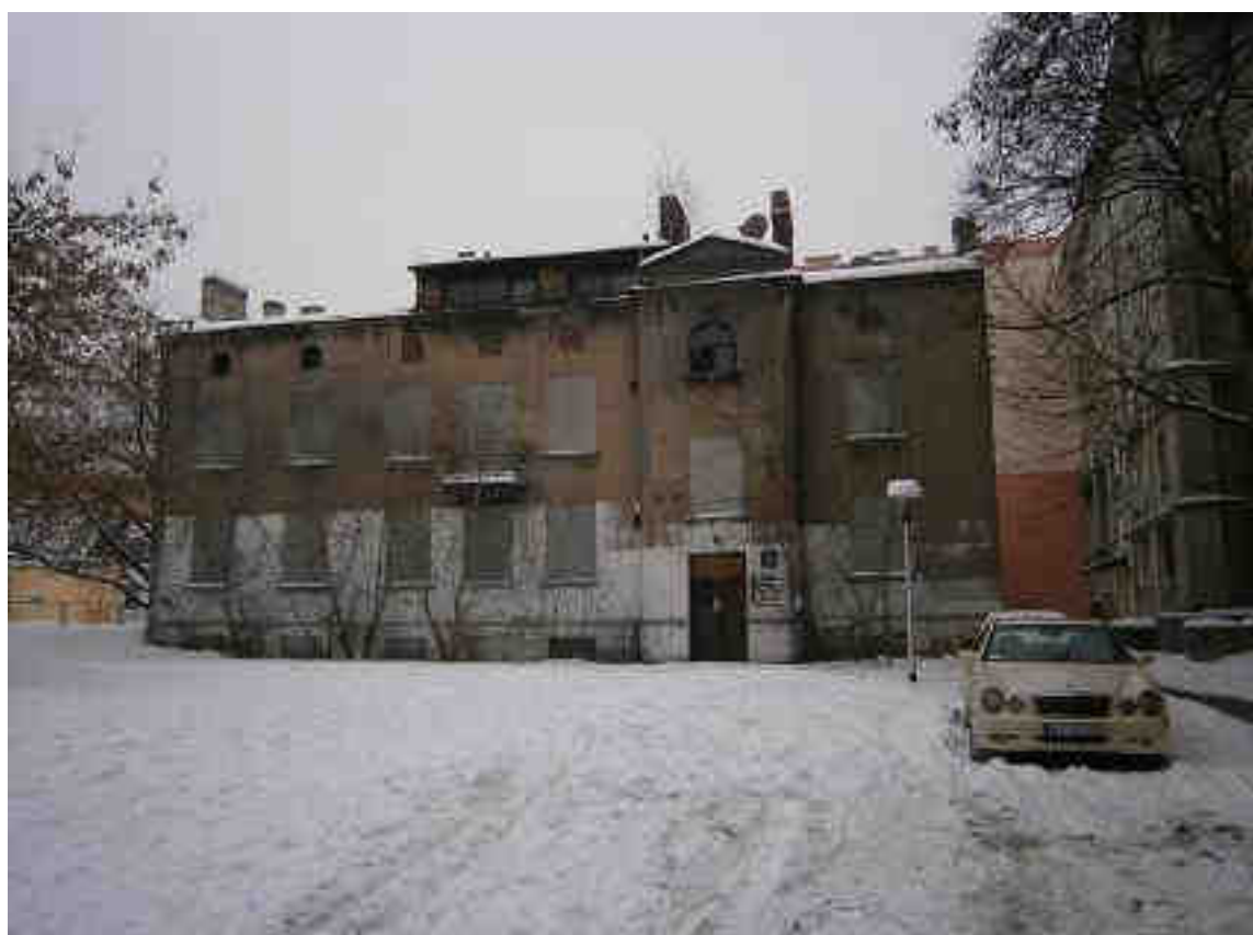
Fot.18 ODCINEK ZACHODNI - ul. Płocka 27a - bez numeru rejestru.
