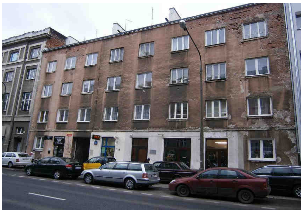
Fot.16 ODCINEK ZACHODNI - ul. Płocka 35 - bez numeru rejestru.
