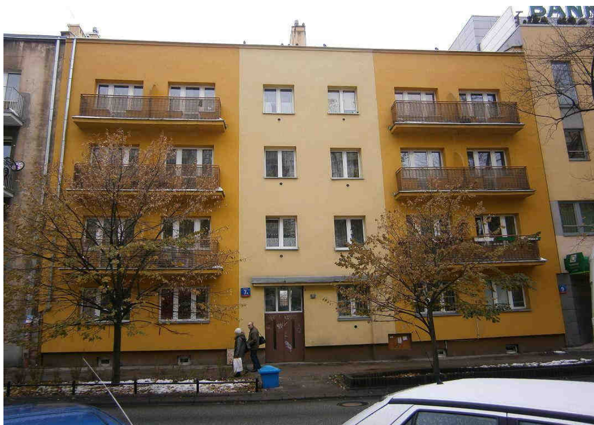
Fot.24 ODCINEK ZACHODNI - ul. Płocka 7a - bez numeru rejestru.
