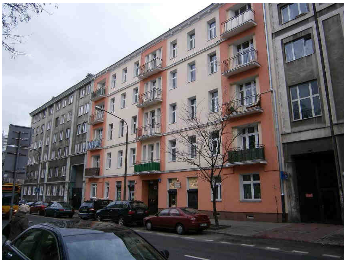
Fot.17 ODCINEK ZACHODNI - ul. Płocka 31 - bez numeru rejestru.
