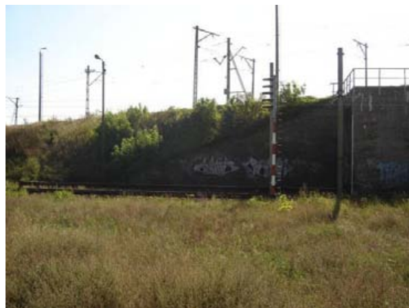
Fot. 8. Widok na linię kolejową o przebiegu równoległym do trasy tramwajowej.
