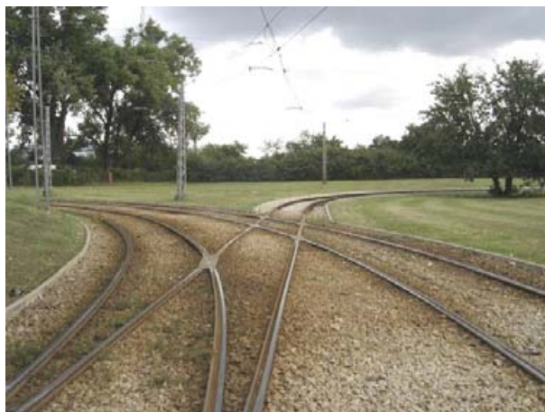
Fot. 1. Miejsce połączenia planowanej trasy tramwajowej z istniejącym torowiskiem tramwajowym, widok w kierunku wschodnim.
