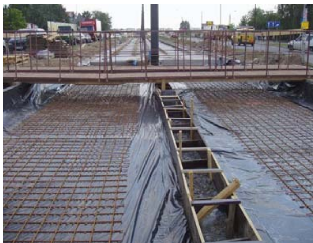
Fot. 31. Przykład koryta trasy tramwajowej wyłożonego matą podtorową i przygotowanego pod układanie podkładów betonowych
