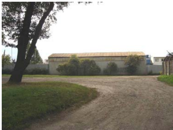
Fot. 3. Widok na budynek leżący w korytarzu trasy tramwajowej w rejonie ul. Objazdowej.
