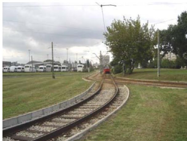
Fot. 2. Torowisko tramwajowe w ul. Kijowskiej, widok w kierunku zachodnim.
