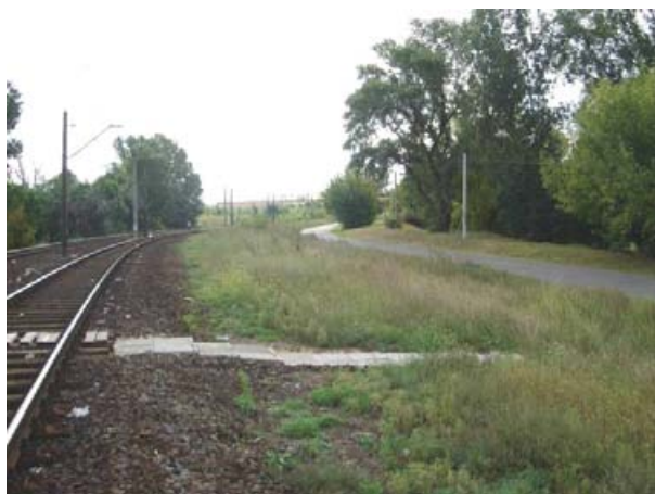
Fot. 9. Widok na rejon przekroczenia terenów kolejowych przez trasę tramwajową (potencjalna lokalizacja tunelu)
