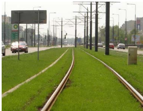
Fot. 34. Trasa tramwajowa z Bemowa na Bielany – przykład odcinka szlakowego z torowiskiem zabudowanym nawierzchnią trawiastą
