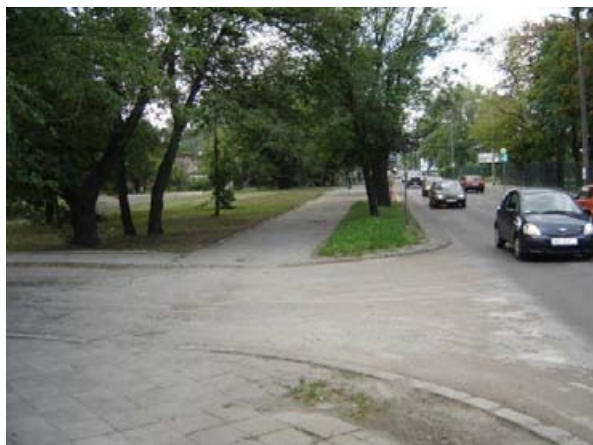
Fot. 21. Wlot ul. Księcia Mieszka I
