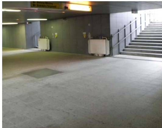
Zdj. 04. Stacja Metro Marymont, windy schodowe dla osób niepełnosprawnych, wzdłuż schodów prowadzących na perony. Przykład pochylni na zdj. 05
