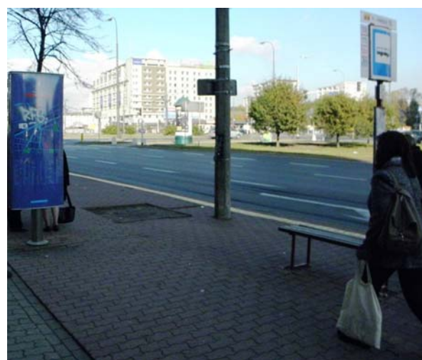
Zdj.12 Pl. Zawiszy, peron autobusowy przy ul. Raszyńskiej w kier. południowym. Widoczny plan najbliższej okolicy, w tym węzła, w postaci tablicy MSI. Zauważone wady: otwór w chodniku po wyciętym drzewie i słup w odległości mniejszej niż 1,5 m od krawężnika.
