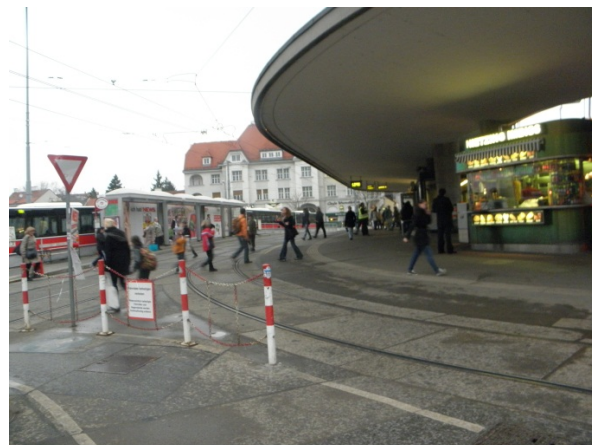
Zdj. 10 Budynek w centralnej części węzła Wiedeń-Heitzing, z zejściami na perony metra i kolei oraz częścią handlowo-usługową.
