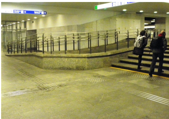
Zdj. 05. Pas ostrzegawczy z wypustkami przed schodami na Dworcu Centralnym. Obok pochylnia.
