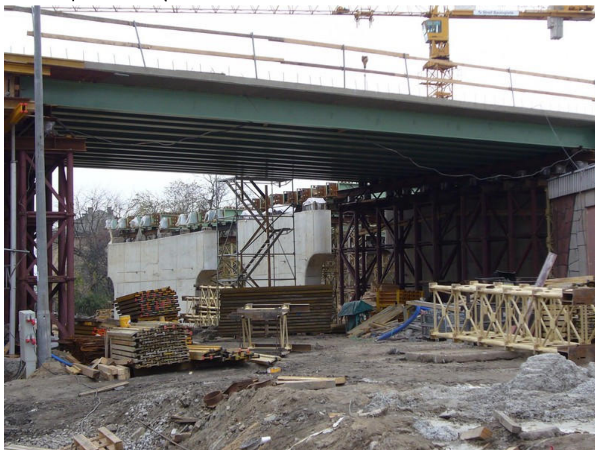
Fot. 1. Prace prowadzone na węźle.
