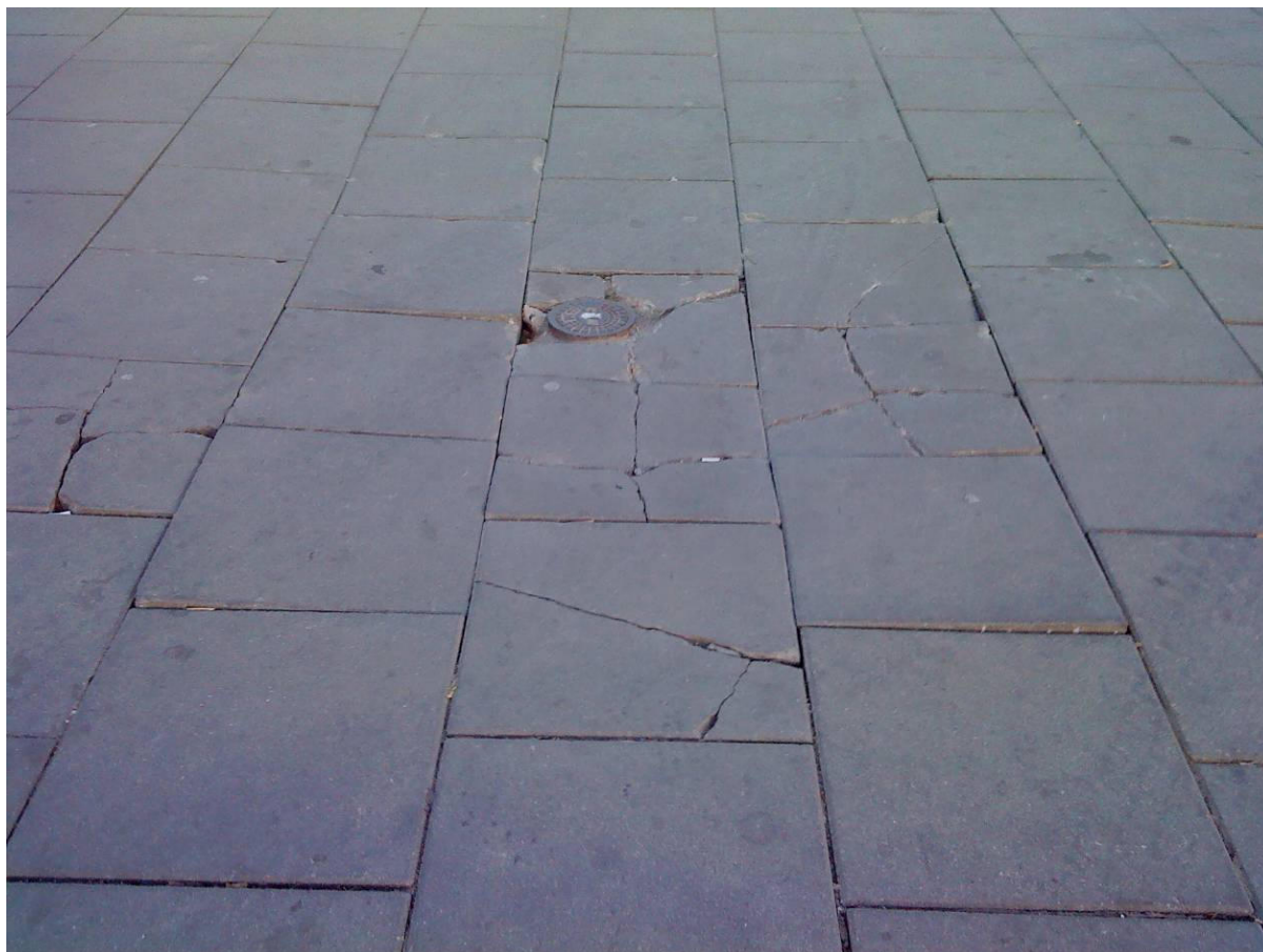
Fot. 3. Pozapadany chodnik.
