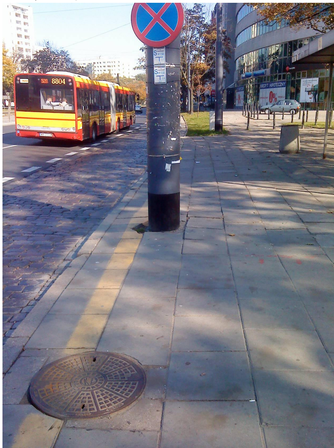
Fot. 2. Przystanek Okopowa 01.
