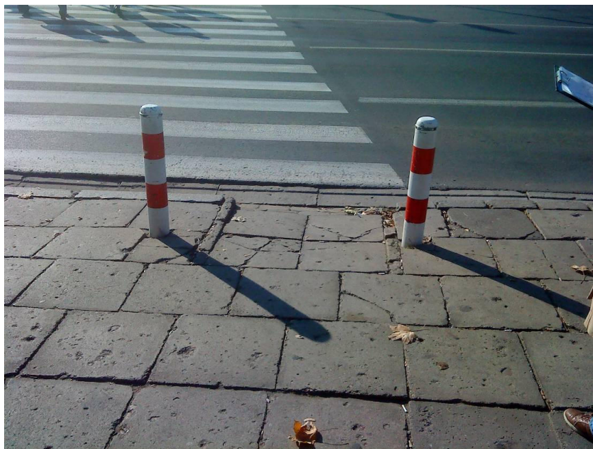
Fot. 4. Przystanek Okopowa 07.
