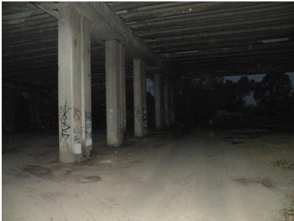
Fot. 2. Węzeł PKP Gocławek – nieoświetlone przejście z PKP Gocławek w kierunku przystanków autobusowych.
