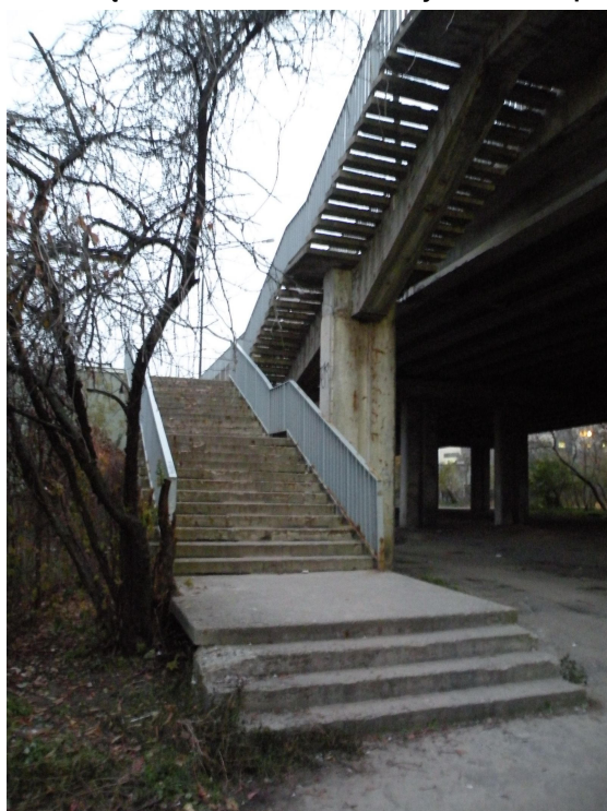
Fot. 4. Węzeł PKP Goławek – schody w kierunku przystanków autobusowych.
