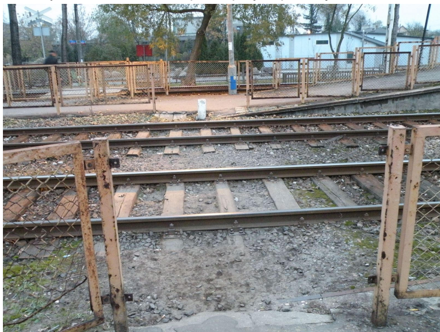
Fot. 3. Węzeł PKP Goławek – niebezpieczne przejście przez tory.
