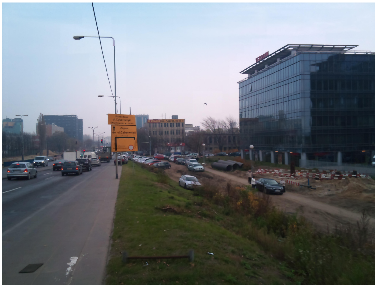
Fot. 1. Węzeł PKP Służewiec – dzikie parkowanie, elementy konstrukcyjne przy ciągu pieszym.
