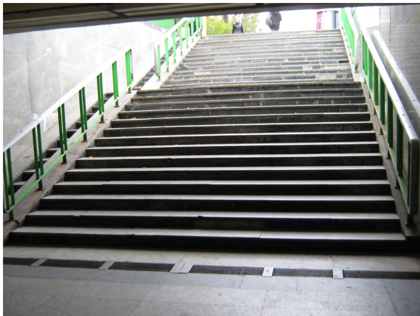
Fot. 2. Węzeł Pl. Na Rozdrożu – stan schodów w obrębie przejścia podziemnego.
