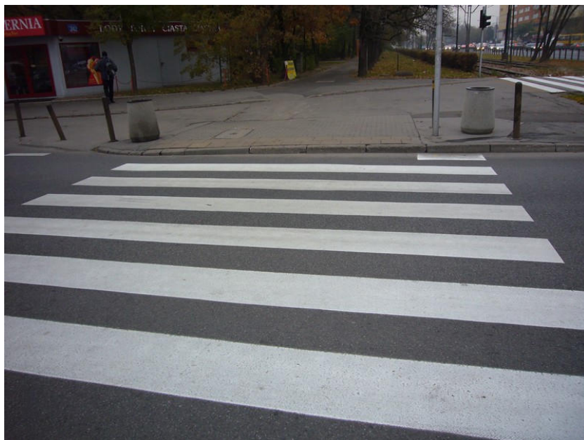
Fot. 9. Węzeł Al. Lotników – utrudnienia dla niepełnosprawnych ruchowo 1.
