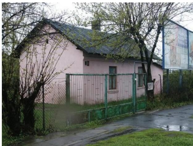
Fot. 23. Przeznaczony do wyburzenia budynek przy ul. Modlińskiej 279
