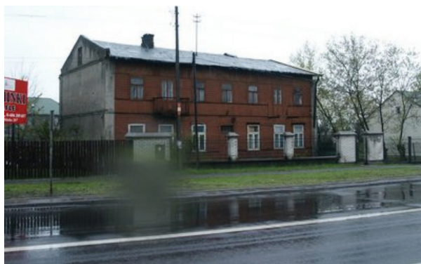
Fot. 25. Przeznaczony do wyburzenia budynek przy ul. Modlińskiej 289
