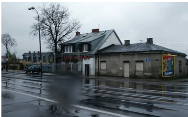
Fot. 27. Przeznaczony do wyburzenia budynek przy ul. Modlińskiej 331
