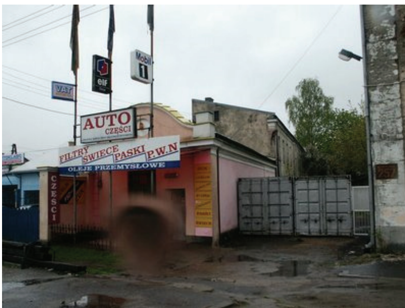
Fot. 14. Oficyna południowa budynku przy ul. Modlińskiej 257
