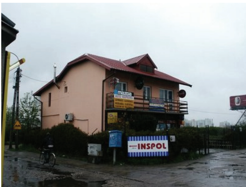
Fot. 28. Przeznaczony do wyburzenia budynek przy ul. Modlińskiej 333
