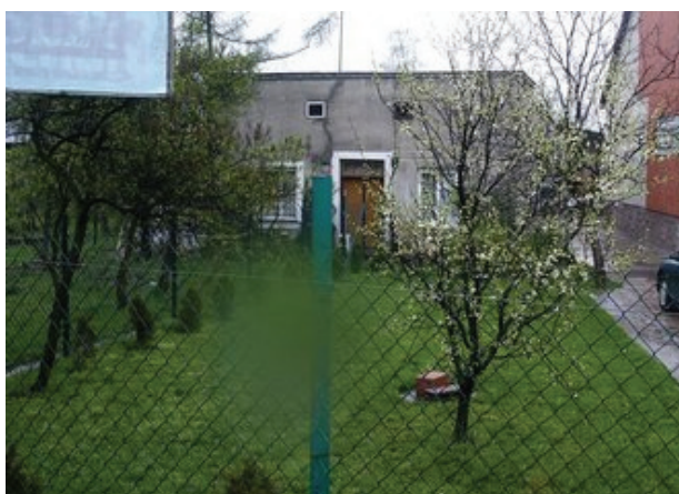
Fot. 26. Przeznaczony do wyburzenia budynek przy ul. Modlińskiej 327
