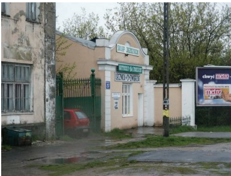
Fot. 13. Oficyna północna budynku przy ul. Modlińskiej 257
