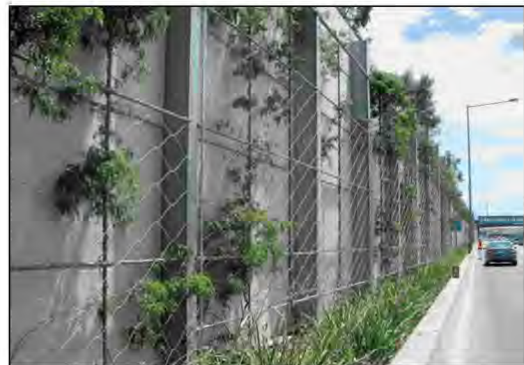
Przykładowe zdjęcie z realizacji, pnącza na siatce stalowej, nierdzewnej plecionej
