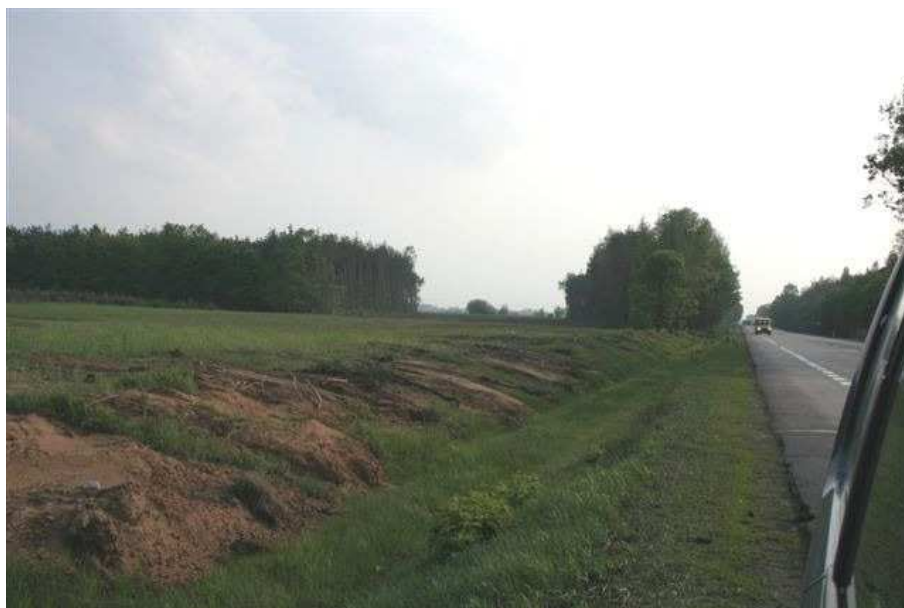
Fot. 1 Początek przebudowy drogi nr 8 – połączenie z obwodnicą Wyszkowa – (Nr 6 na mapie środowiskowej)
