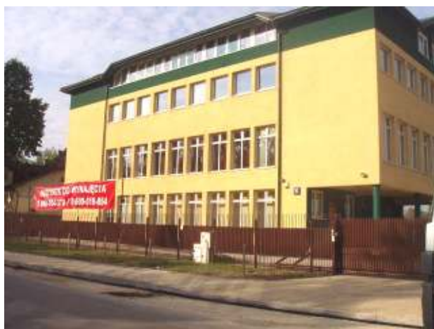
Fot. 10. Zagospodarowanie przestrzenne ul. Zgrupowania AK „Kampinos” – odcinek od ul. Marymonckiej do ul. Encyklopedycznej – budynek biurowy usytuowany po stronie północnej.
