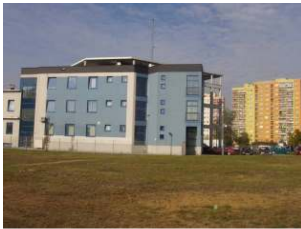
Fot. 16. Zagospodarowanie przestrzenne w rejonie skrzyżowania ul. Obrazkowa-Myśluborska – budynek komendy policji w narożniku północno-zachodnim.
