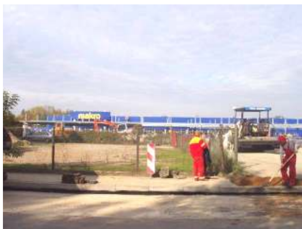
Fot. 9. Zagospodarowanie przestrzenne ul. Zgrupowania AK „Kampinos” – odcinek od ul. Marymonckiej do ul. Encyklopedycznej – w głębi budowa hurtowni Makro.
