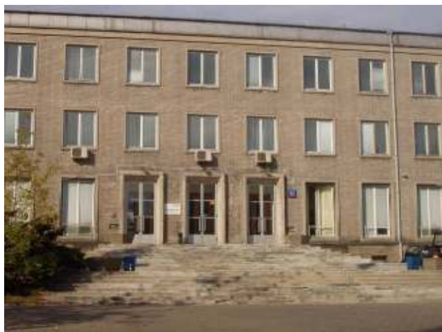
Fot. 3. Zagospodarowanie przestrzenne w rejonie Młocin – budynek biurowy huty Accelor.
