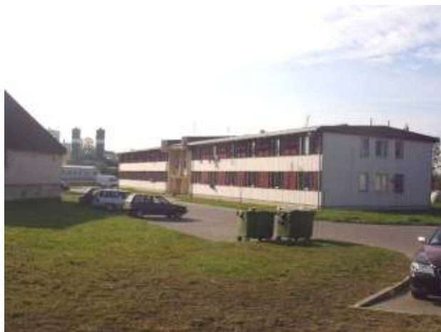
Fot. 13. Zagospodarowanie przestrzenne w rejonie skrzyżowania ul. Obrazkowa-Myśluborska – budynek mieszkalno-hotelowy Świdarska 41, w głębi hurtownia marmurów.
