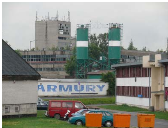
Rys. 17 Budynki do rozbiórki przy ul. Świderskiej (w głębi nieczynny zakład przemysłowy)
