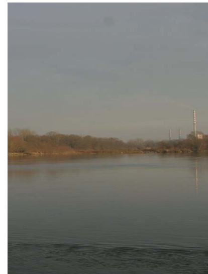
Rys. 69 W oddali widoczny komin elektrociepłowni
