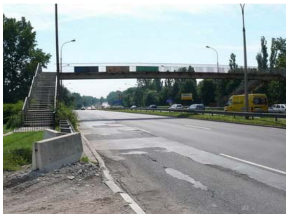
Rys. 8 ul. Wybrzeże Gdyńskie – widok w kierunku południowo-wschodnim za skrzyżowaniem z ul. Prozy
