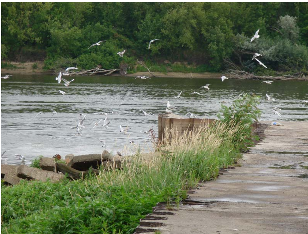
Rys. 64 Wylot kolektora MPWiK („burakowskiego”) w rejonie planowanej przeprawy mostowej
