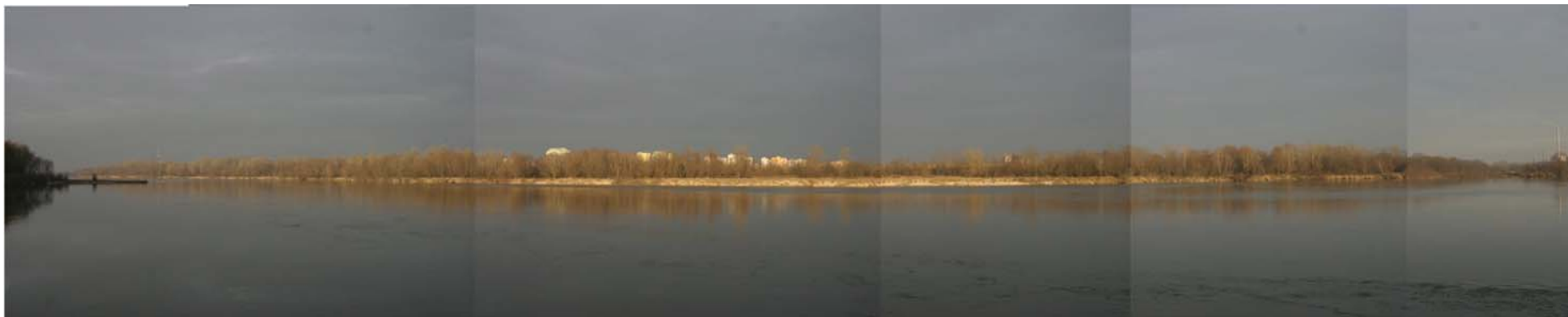
Rys. 66 Panorama prawego brzegu Wisły w rejonie przeprawy mostowej
