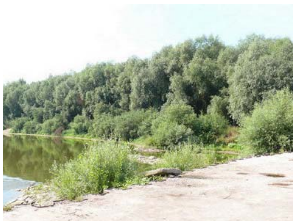
Rys. 13 Wisła – lewy brzeg na wysokości projektowanej przeprawy mostowej
