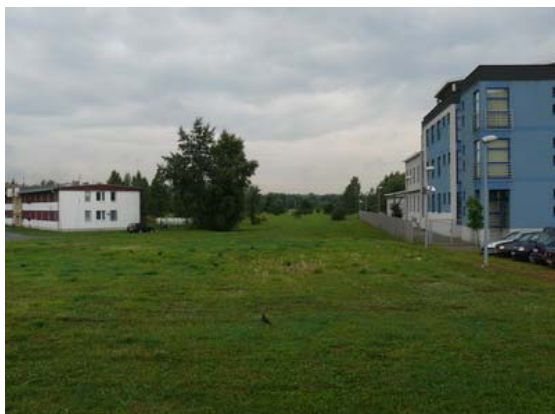
Rys. 19 Widok z ul. Myśliborskiej w kierunku południowo – zachodnim w osi TMP. Po prawej stronie budynek komisariatu Policji , po lewej – barak hotelowy do rozbiórki
